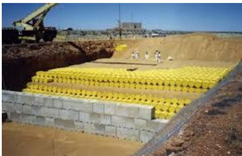
Εικόνα 4.2. Τοποθέτηση πυρηνικών αποβλήτων στη γη
