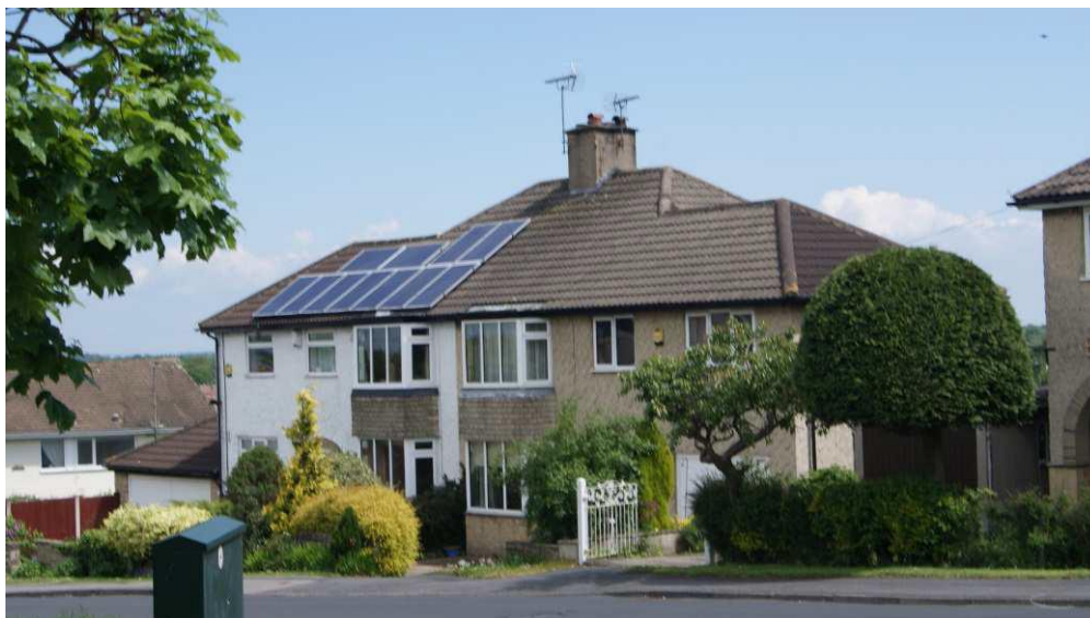
Εικόνα 5.14. Φωτοβολταϊκά στη στέγη ενός σπιτιού στο Ηνωμένο Βασίλειο
