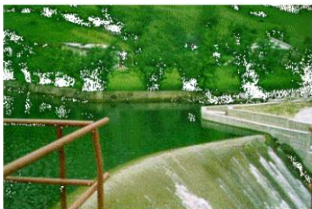
Εικόνα 3.8 : Υδροφράκτης ενός μικρού υδροηλεκτρικού σχήματος εκτροπής
