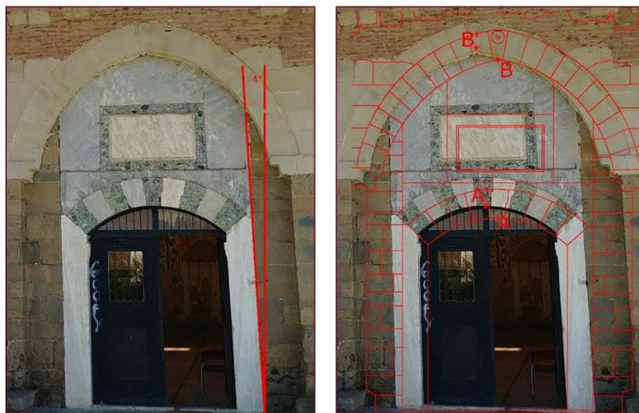
Εικόνα 84. Γεωμετρικές διαφορές στην αποτύπωση του μνημείου πριν και μετά την ορθοαναγωγή.
