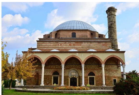
Εικόνα 40. Το τέμενος μετά την αποκατάσταση του 1993 (Trikala-ident 2014).
