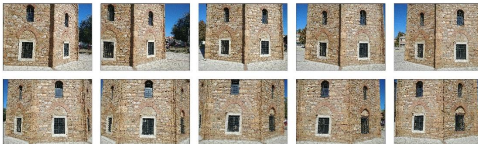
Εικόνα 93. Στερεοζεύγη για την τρισδιάστατη φωτογραμμετρική αποτύπωση του τουρμπέ.
