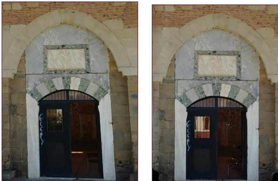
Εικόνα 83. Αρχική φωτογραφία και ορθοανηγμένη της εισόδου του τεμένους του Οσμάν Σαχ.
