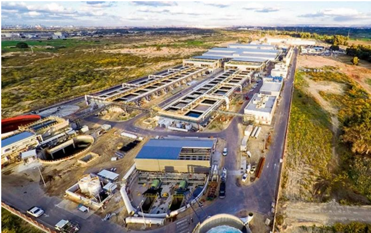
Εικόνα 5.1.3 Η μονάδα αφαλάτωσης αντίστροφης όσμωσης του Ashkelon, Ισραήλ (Πηγή : Διαδίκτυο)
