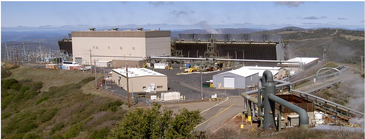
Εικόνα 7.2 Η μονάδα “Geysers Complex”, για την παραγωγή ενέργειας από γεωθερμία στην Καλιφόρνια, δυναμικής 1.520 MW (Πηγή : διαδίκτυο)
