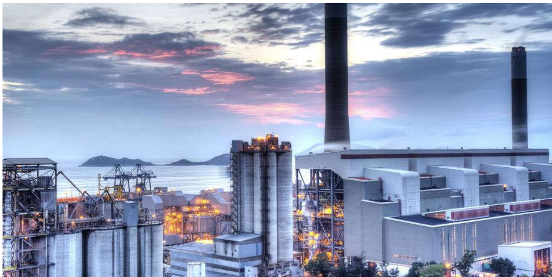
Εικόνα 4: Μονάδα σύγχρονης βιομηχανίας
