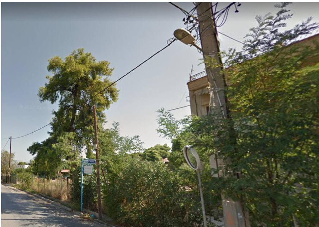
Εικόνα 33 Ανεπαρκής φωτισμός στις κύριες οδούς, Λεωφόρος Τραπεζούντας 126
