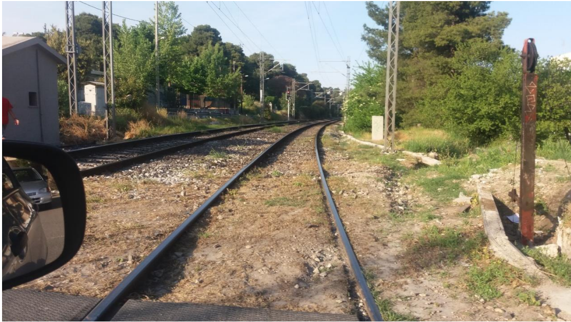
Εικόνα 6 Για το εν λόγω σημείο απαιτείται η ενίσχυση των μέτρων ασφαλείας
