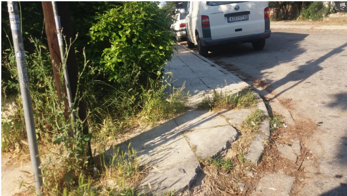
Εικόνα 35 Αμέλεια και εγκατάλειψη των πεζοδρομίων
