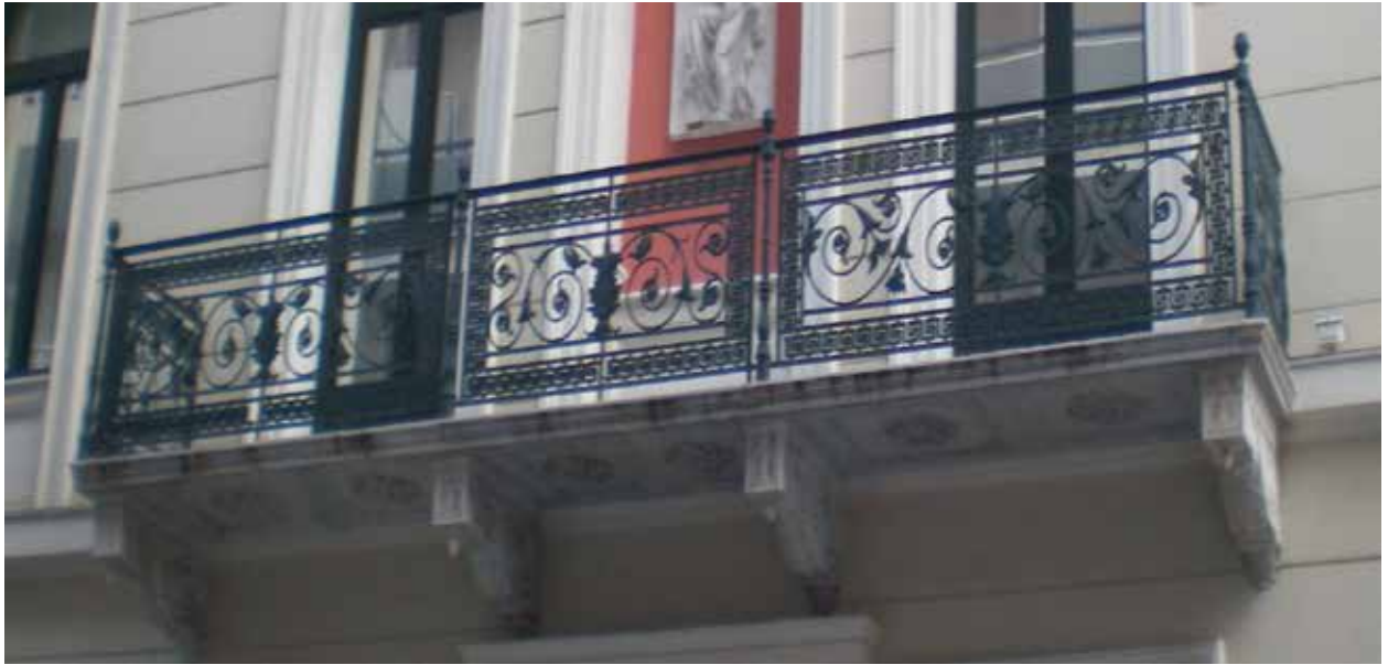
Εικ. 222. Το κτίριο στη γωνία Κουντουριώτου – Μπουμπουλίνας
