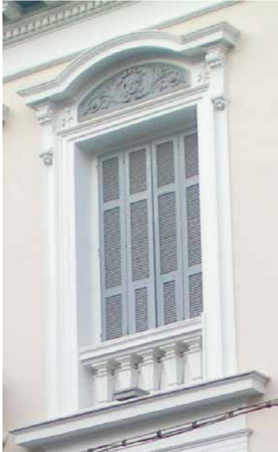
Εικ. 189. Ψευδοστηθαίο με μπαλούστρες στο κτίριο στη γωνία Πραξιτέλους – Σωτήρος Διος
