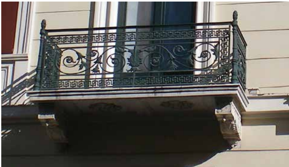
Εικ. 223. Το κτίριο στη γωνία Πραξιτέλους - Μπουμπουλίνας
