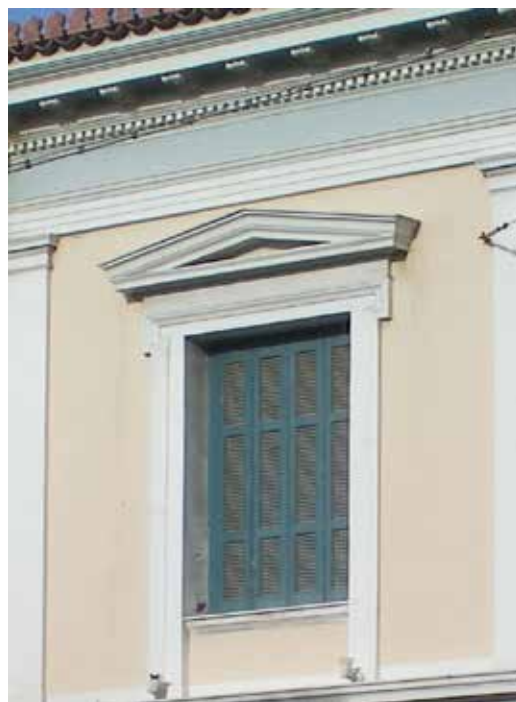
Εικ. 193. Πλήρης αετωματική στέγη παραθύρου και τμήμα διακοσμητικής ζώνης στο κτίριο στη γωνία Ελ. Βενιζέλου – Κολοκοτρώνη
