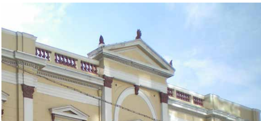
Εικ. 155. Το κεντρικό αέτωμα του Παλαιού Ταχυδρομείου.
