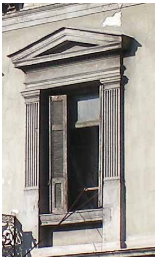
Εικ. 194. Παραστάδες με ραβδώσεις στο κτίριο στη γωνία Γρ. Λαμπράκη – Καραολή και Δημητρίου
