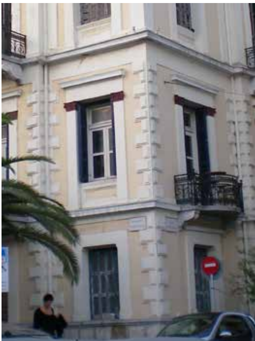
Εικ. 151. Κτίριο στη γωνία Υψηλάντου – Β' Μεραρχίας
