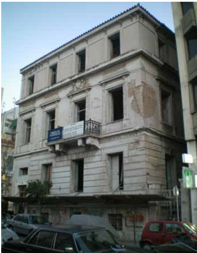
Εικ. 129. Κτίριο στην οδό Καραϊσκού 153 (αποκατάσταση)
