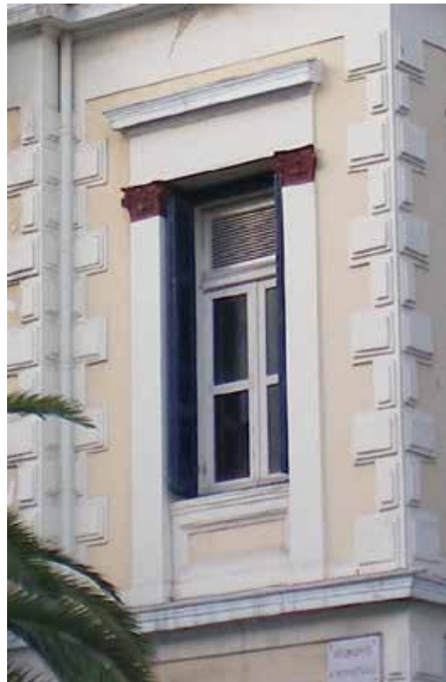
Εικ. 200. Το κτίριο στη γωνία Υψηλάντου – Β' Μεραρχίας
