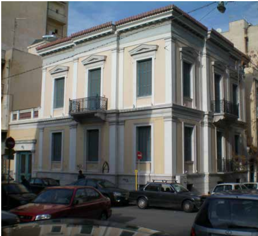
Εικ. 138. Κτίριο στη γωνία Ελ. Βενιζέλου – Κολοκοτρώνη
