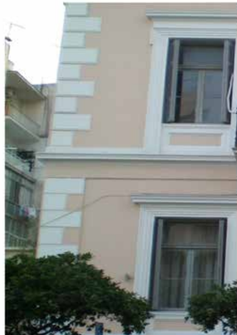
Εικ. 152. Κτίριο στην οδό Β' Μεραρχίας 34α
