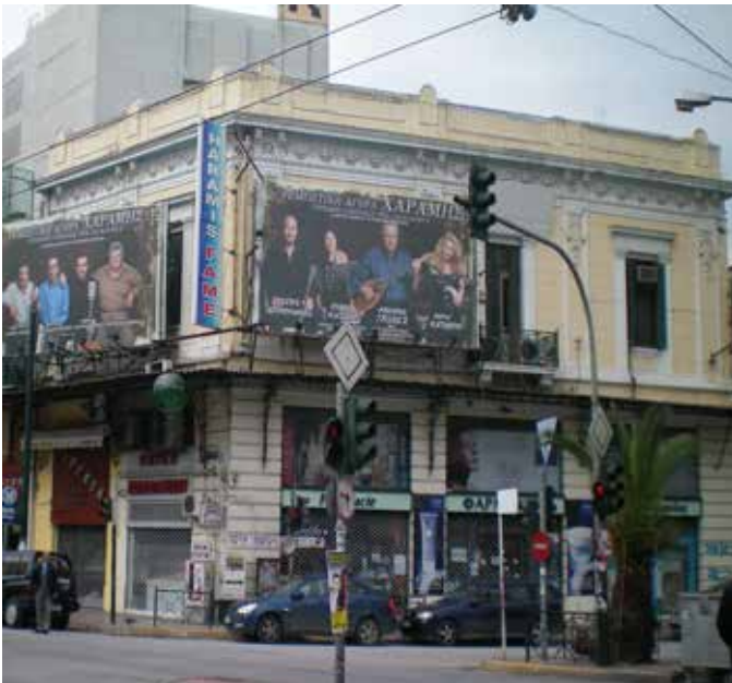
Εικ. 146. Το κτίριο στην οδό Γούναρη 11
