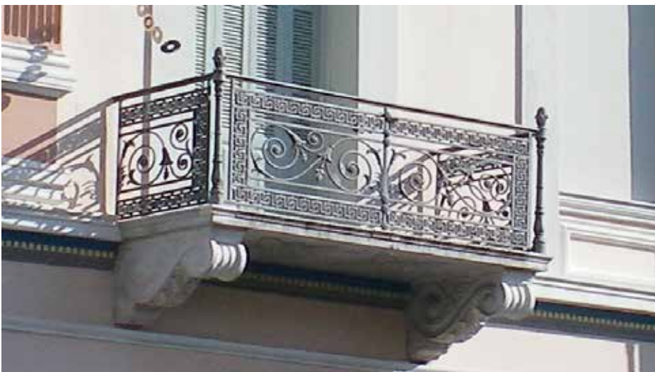
Εικ. 224. Το κτίριο στη γωνία Καραΐσκου – Καραολή και Δημητρίου
