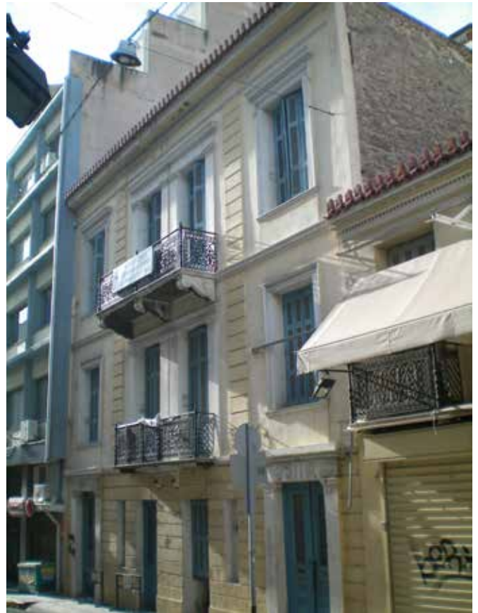
Εικ. 130. Κτίριο στην οδό Νοταρά 32
