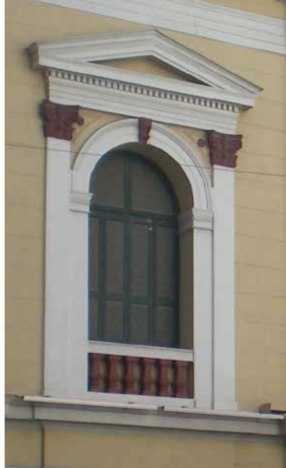
Εικ. 190. Ψευδοστηθαίο με μπαλούστρες στο Παλαιό Ταχυδρομείο
