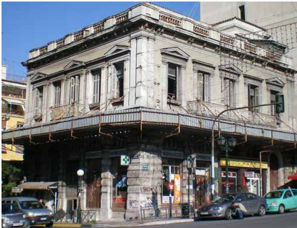
Εικ. 153. Οι "μπόμπες" στο κτίριο στη γωνία Γρ. Λαμπράκη – Τσαμαδού
