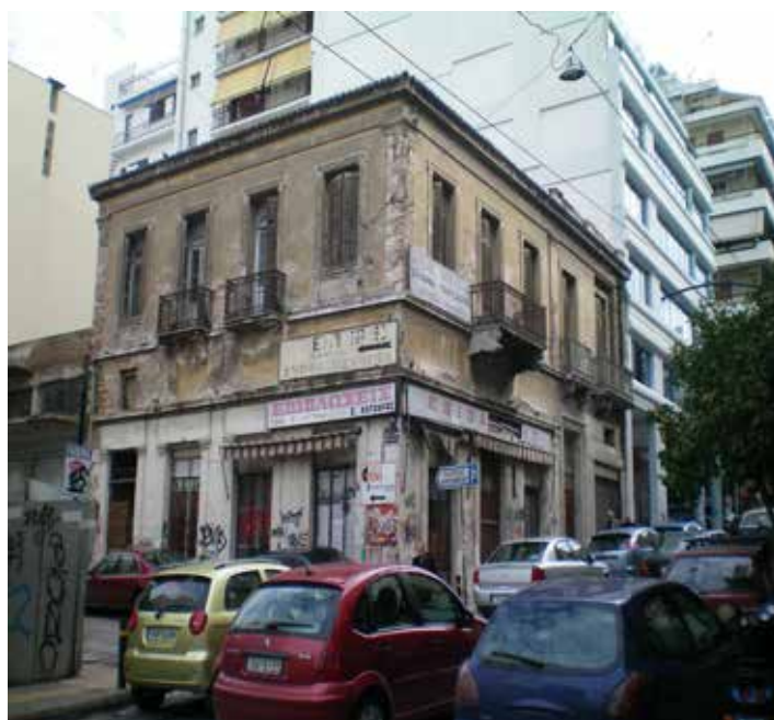
Εικ. 122. Το κτίριο στη γωνία Ελ. Βενιζέλου και Τζελέπη
