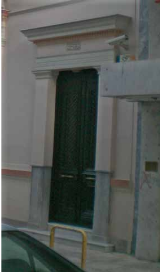
Εικ. 203. Η εξώθυρα της οικίας στην οδό Περικλέους 13. Ο πιο διαδεδομένος τύπος επίστεψης θυρώματος με τριμερή θρίγκο, ενώ οι παραστάδες είναι μόνο κατά το 1/3 επενδυμένες με μάρμαρο.
