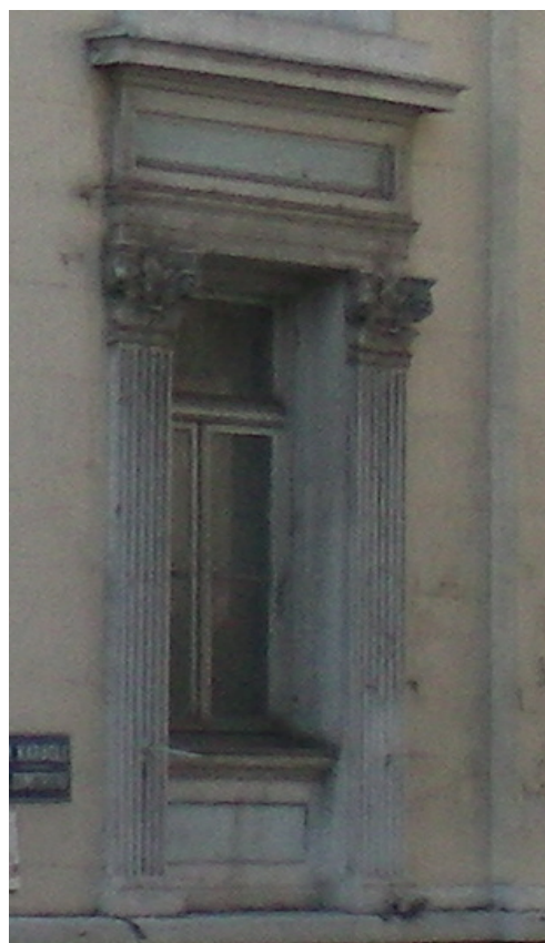
Εικ. 195. Παραστάδες με ραβδώσεις στο κτίριο στη γωνία Γρ. Λαμπράκη – Τσαμαδού
