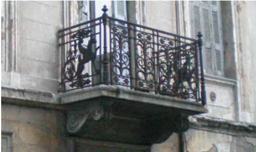
Εικ. 227. Κτίριο στην οδό Υψηλάντου 51
