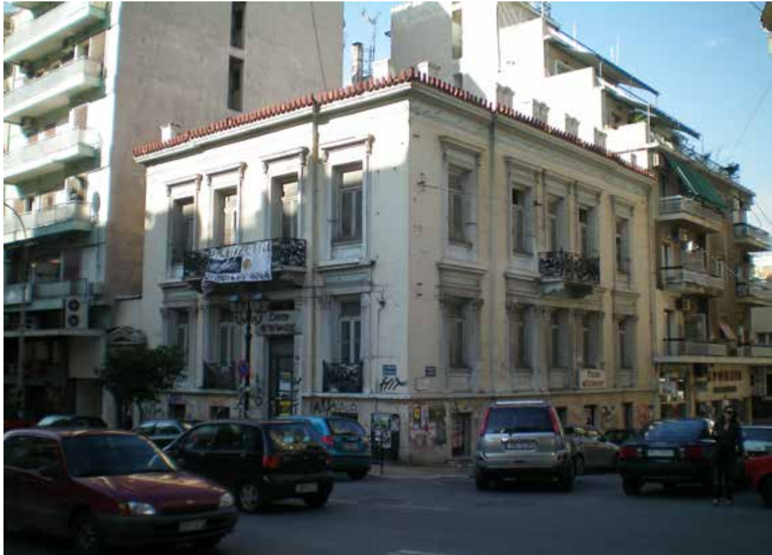
Εικ. 131. Κτίριο στη γωνία Γρ. Λαμπράκη – Καραολή και Δημητρίου
