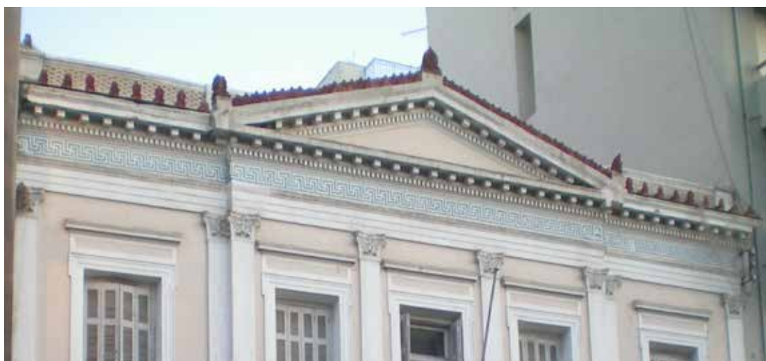
Εικ. 154. Το κεντρικό αέτωμα με κεραμικά στοιχεία, της οικίας Χριστοπούλου στην οδό Καραϊσκού 161.
