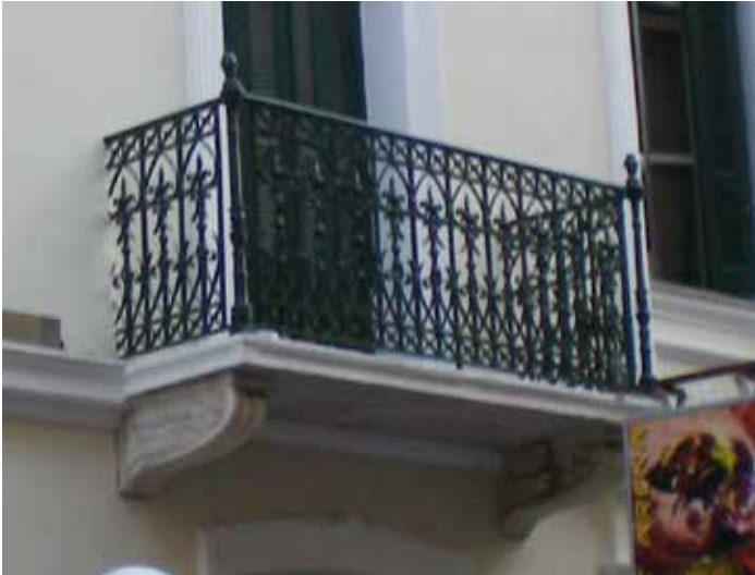
Εικ. 218. Το κτίριο στην οδό Ανδρούτσου 121
