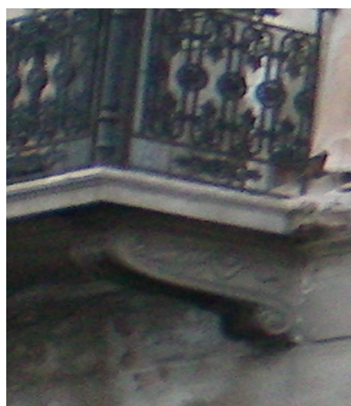
Εικ. 208. Κτίριο στη γωνία Ανδρούτσου - Ευαγγελιστρίας
