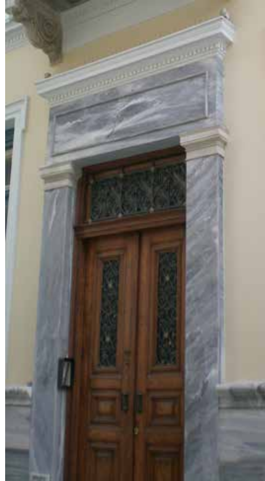
Εικ. 204. Η εξώθυρα της οικίας στην οδό Κολοκοτρώνη 61 με εξ ολοκλήρου μαρμάρινες παραστάδες και επίσης μαρμάρινη επίστεψη.
