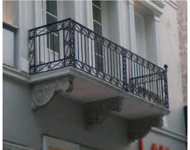
Εικ. 219. Το κτίριο στην οδό Ανδρούτσου 153
