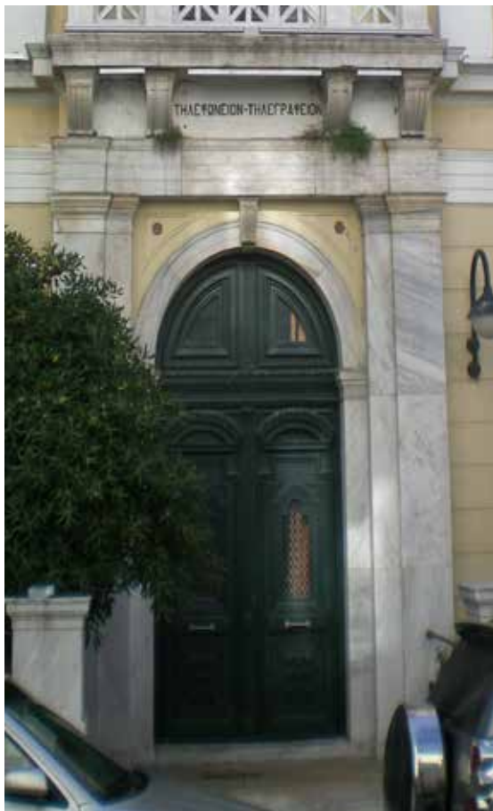
Εικ. 201. Η εξώθυρα του Παλαιού Ταχυδρομείου. Ημικυκλικό τόξο με διπλές εξ ολοκλήρου μαρμαρίνες παραστάδες, με τριμερή, επίσης μαρμάρινο, θρίγκο.
