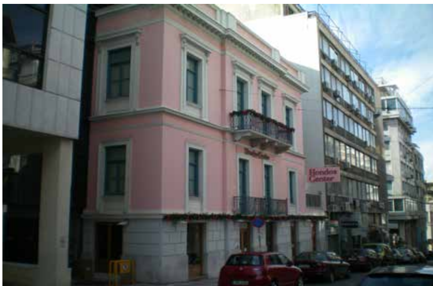
Εικ. 126. Το κτίριο στην οδό Μπουμπουλίνας 18
