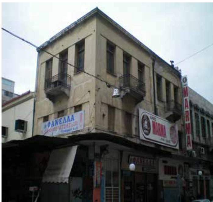
Εικ. 121. Το κτίριο στη γωνία Δημοσθένους και Τσαμαδού
