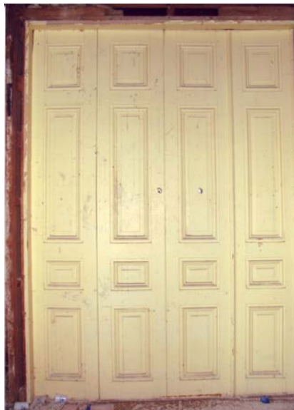
Φωτογραφία 58 Εσωτερική θύρα ορόφου.
