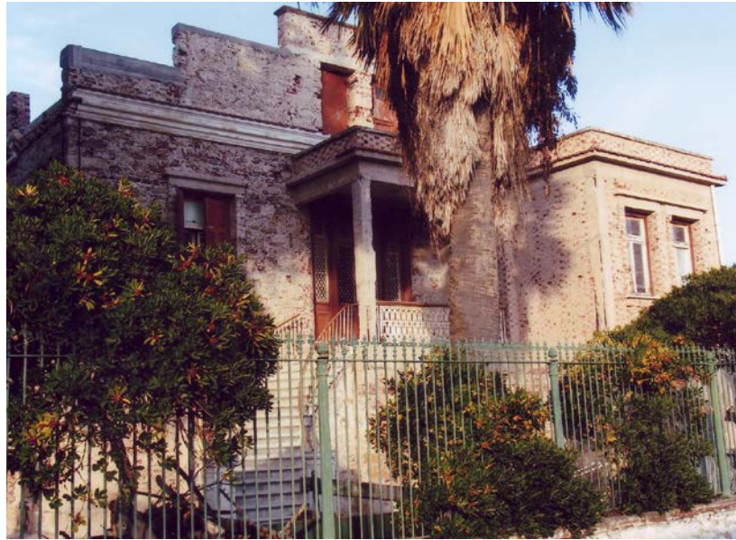
Φωτογραφία 23 .Πρόσοψη από τον δρόμο.
