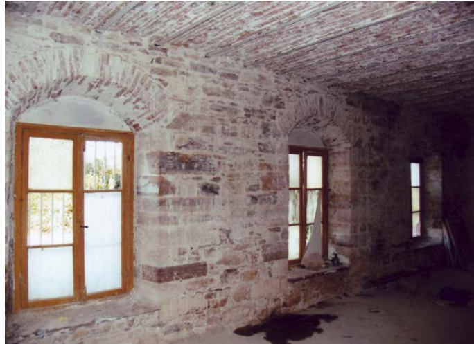
Φωτογραφία 28. Ανοίγματα στο ισόγειο.
