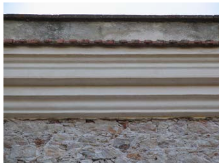
Φωτογραφία 44. Επίστεψη στέγης.
