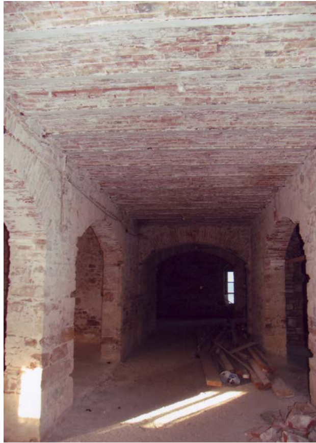
Φωτογραφία 1 5. Κεντρικός διάδρομος ισογείου-Βόρεια πλευρά.
