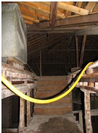
Φωτογραφία 26.Ξύλινη σκάλα που οδηγεί στην σοφίτα.
