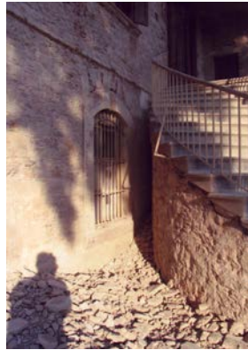
Φωτογραφία 9. Δυτική όψη σκάλας.
