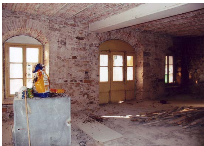
Φωτογραφία 19. Άποψη από δωμάτιο στο δυτικό τμήμα του ισογείου.
