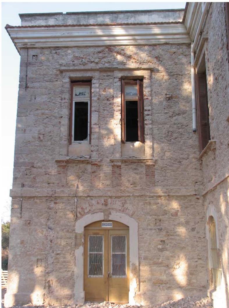
Φωτογραφία 31. Νότια όψη. Είναι εμφανής η τριγωνική επίστεψη και η παραστάδες που συνεχίζουν ως το ύψος της πλάκας.
