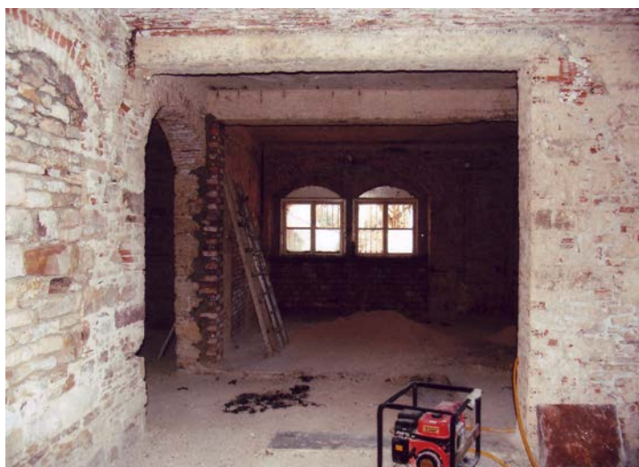
Φωτογραφία 18. Άποψη από δωμάτιο που βρίσκεται στο βόρειο τμήμα του ισογείου.
