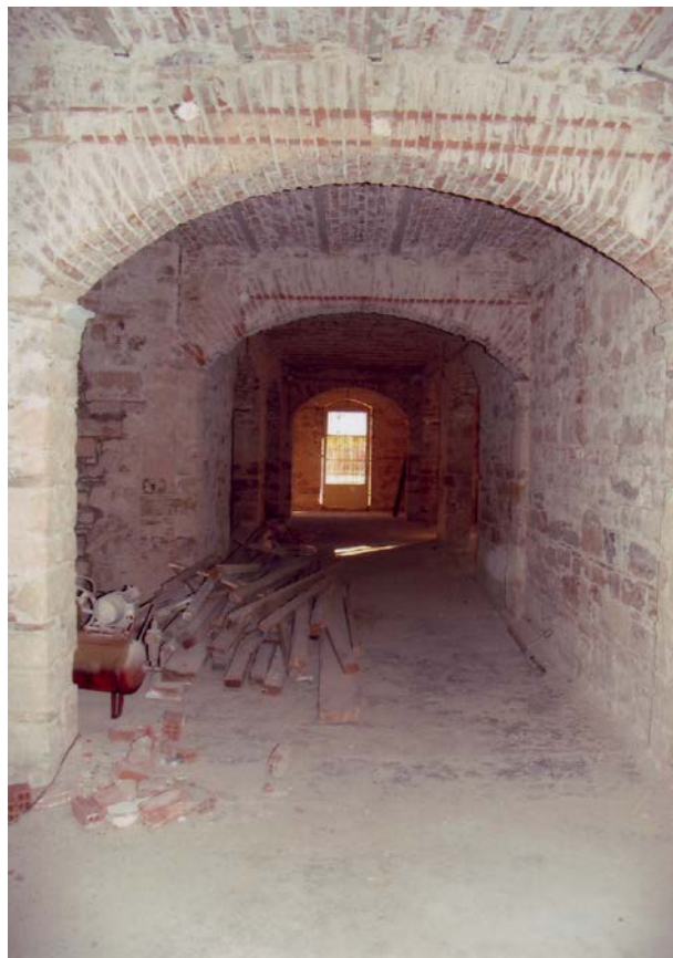
Φωτογραφία 1 6.Κεντρικός διάδρομος ισογείου-Νότια πλευρά.
