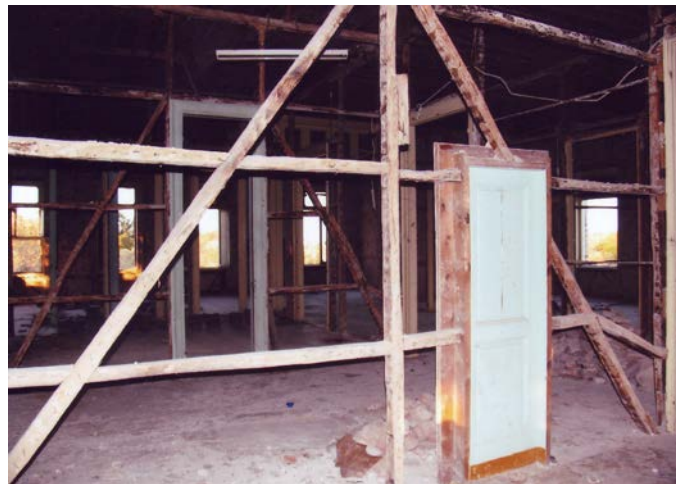
Φωτογραφία 29. Διαχωριστικοί τοίχοι δωματίων του ορόφου. Ότι υπάρχει μετά τις επισκευές.
