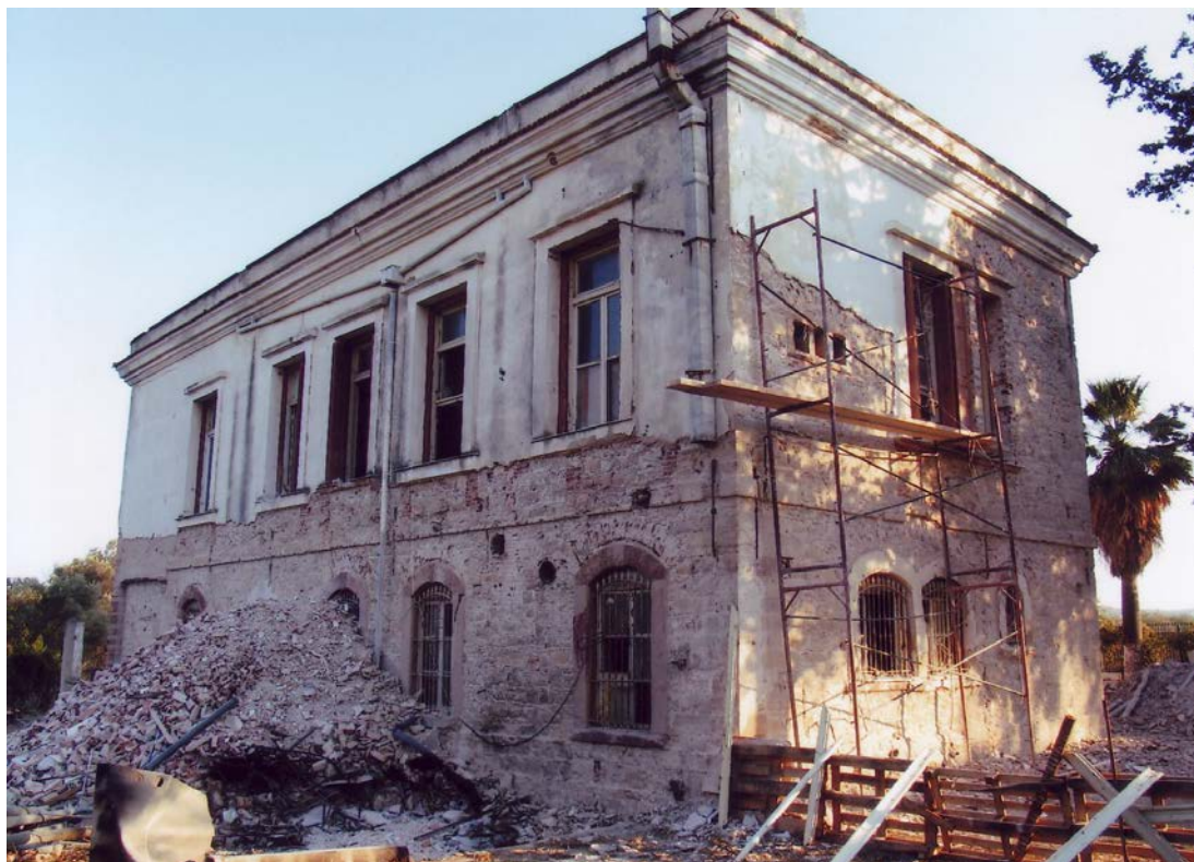
Φωτογραφία 13.Βορειοδυτική όψη. Πρίν γίνει η αφαίρεση όλου του επιχρίσματος.
