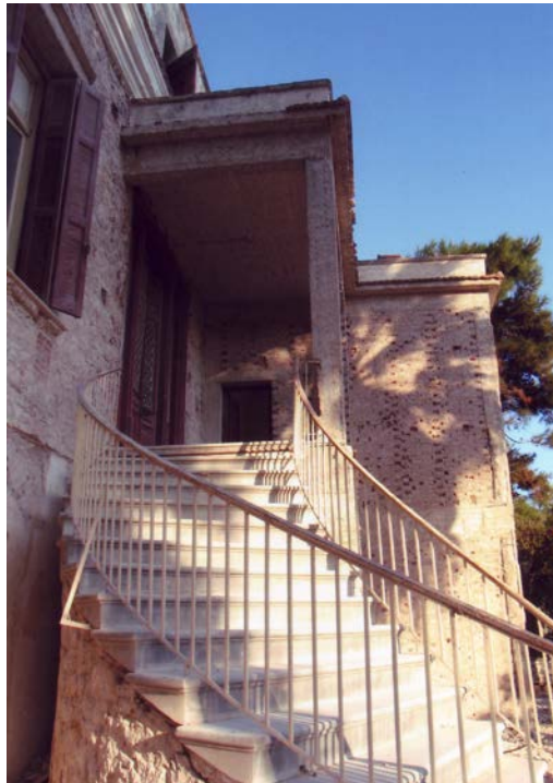
Φωτογραφία 20. Δυτική όψη σκάλας.
