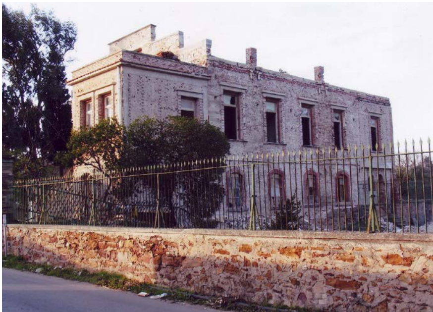
Φωτογραφία 11. Νοτιοανατολική όψη από το δρόμο.
