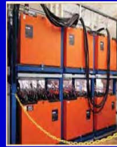
Μπαταρίες μολύβδου για αποθήκευση ενέργειας.
