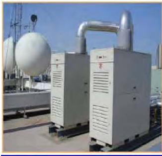
Μικροστρόβιλοι με ανάκτηση θερμότητας.
