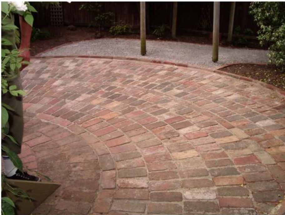
Εικόνα 19 - Χρήση ανακυκλωμένων κεραμικών πλίνθων για την διάστρωση υπαίθριου χώρου (Πηγή : www.anakem.gr )
