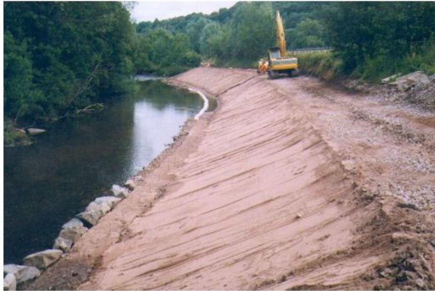
Εικόνα 16 - Χρήση αδρανών από ανακύκλωση για την διευθέτηση ρέματος (Πηγή : www.anakem.gr )
