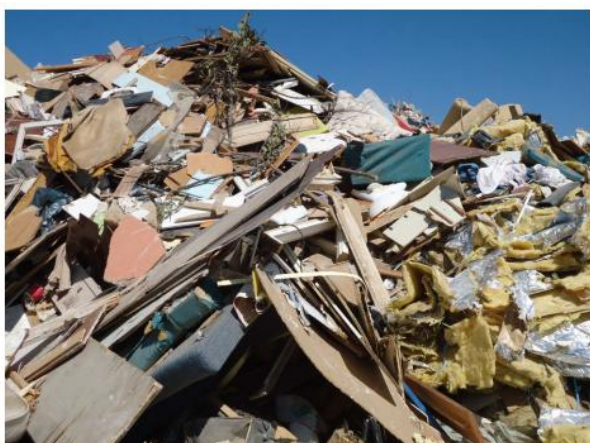
Εικόνα 4 Ανομοιογενή απόβλητα κατεδάφισης
