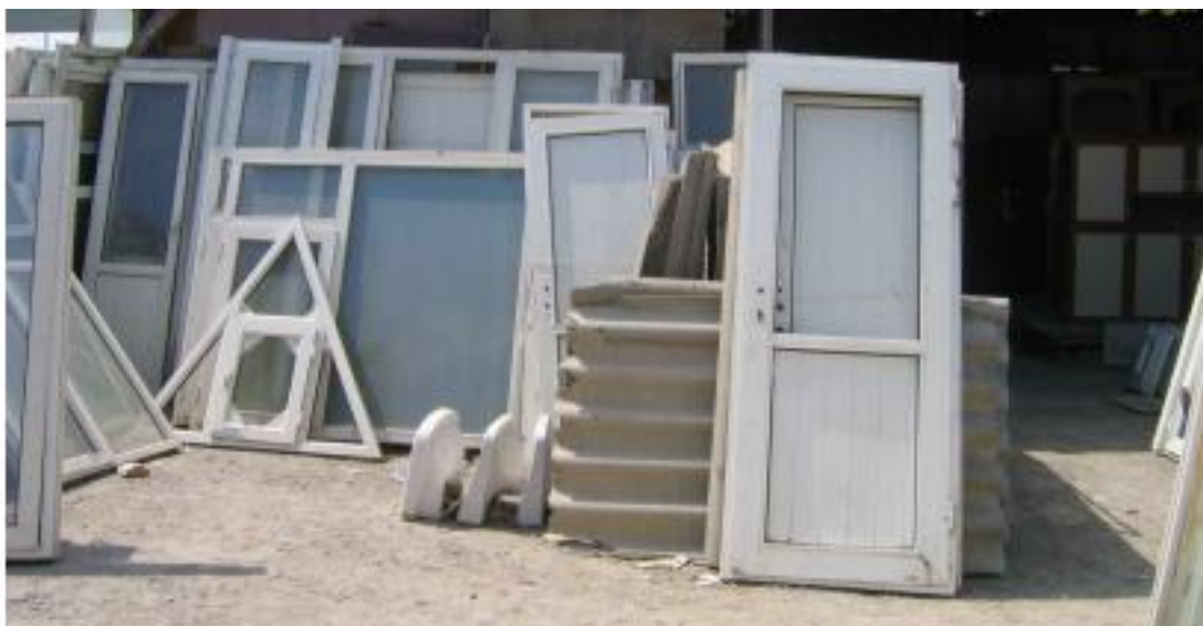
Εικόνα 3 Αφαίρεση κουφωμάτων από κτίριο πριν την κατεδάφιση (Πηγή : www.eoan.gr )
