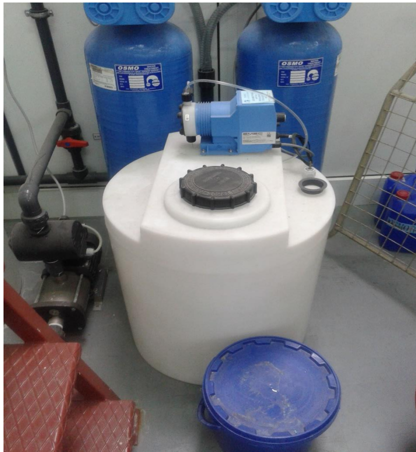
Εικόνα 42: Δεξαμενή προχλωρίωσης
