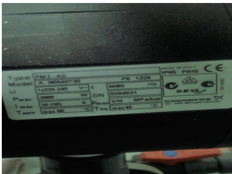
Εικόνα 44: Τεχνικά χαρακτηριστικά αντλίας τροφοδοσίας
