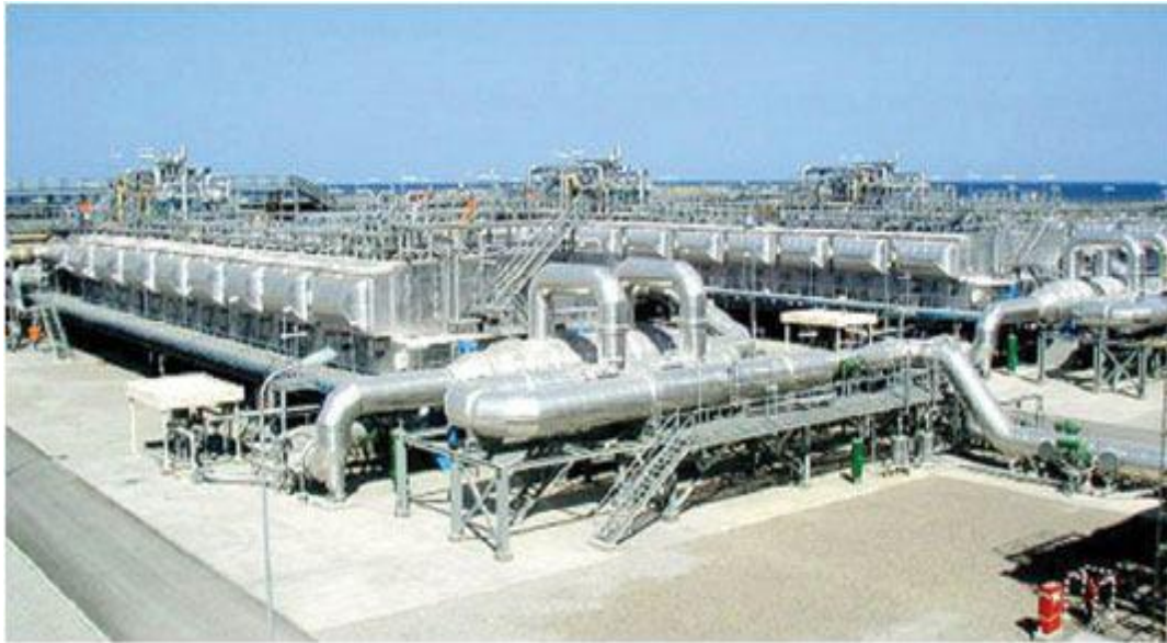
Εικόνα 11: Εγκατάσταση πολυβάθμιας εκτόνωσης στη Μέση Ανατολή [18]
