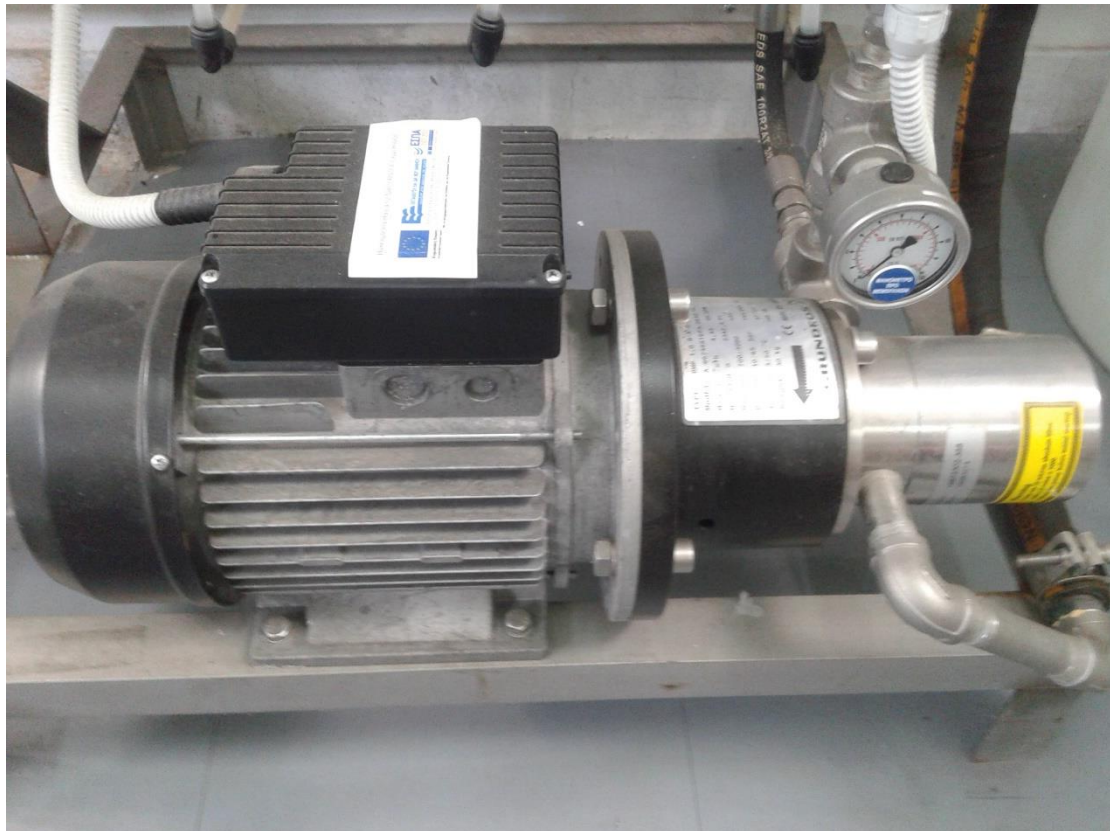
Εικόνα 30: Κύρια αντλία ή αντλία αντίστροφης ώσμωσης
