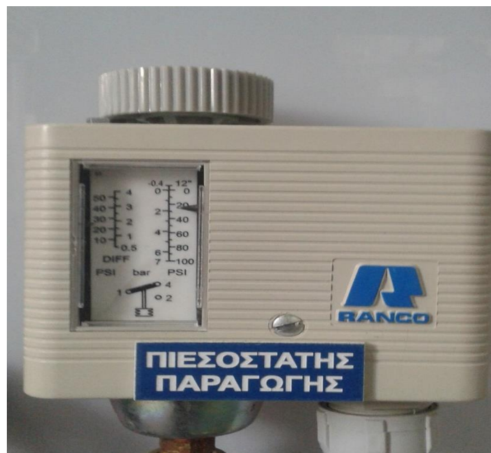
Εικόνα 35: Πιεσοστάτης παραγωγής
