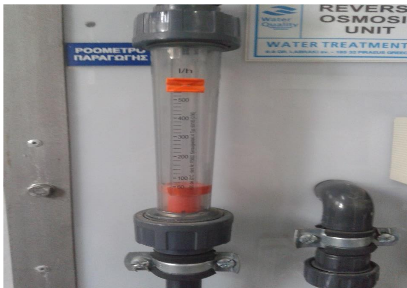
Εικόνα 33: Ροόμετρο παραγωγής
