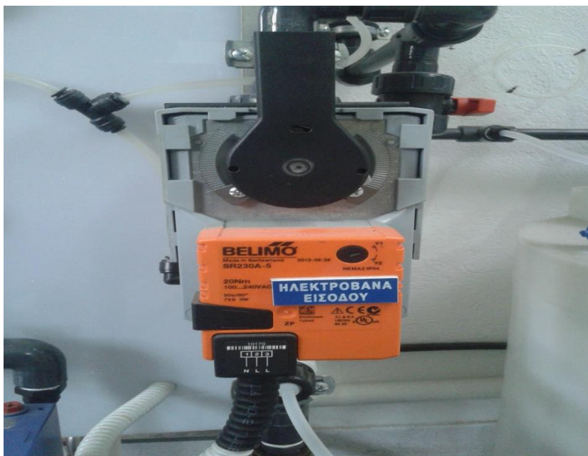
Εικόνα 29: Ηλεκτρομαγνητική βαλβίδα εισόδου
