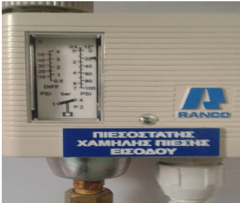
Εικόνα 34: Πιεσοστάτης χαμηλής πίεσης εισόδου
