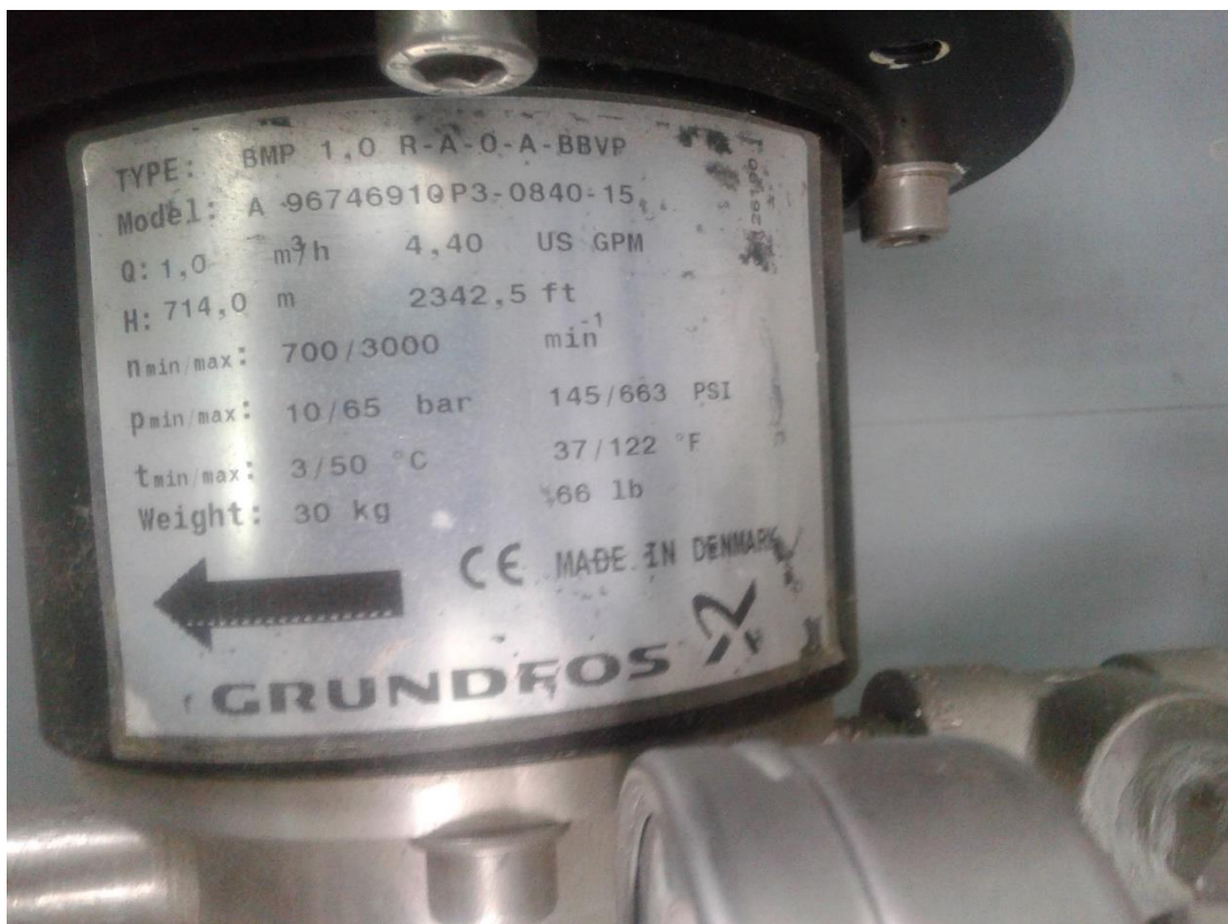
Εικόνα 31: Τεχνικά χαρακτηριστικά κύριας αντλίας
