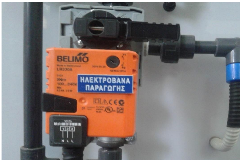
Εικόνα 32: Ηλεκτρομαγνητική βαλβίδα παραγωγής
