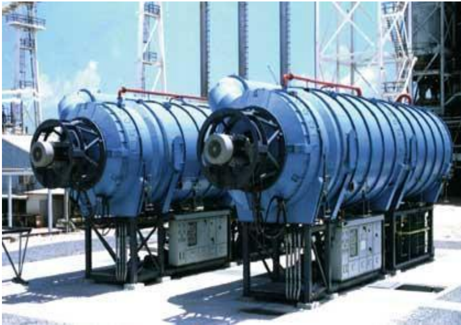
Εικόνα 15: Εγκατάσταση εξάτμισης με συμπίεση ατμών [18]
