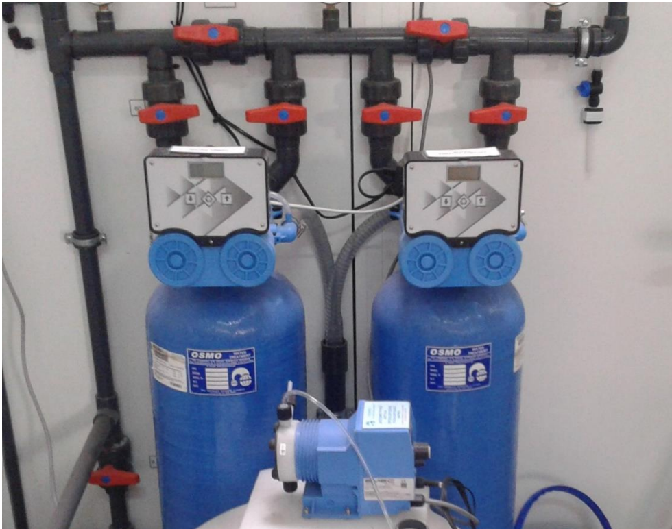
Εικόνα 45: Αριστερά το φίλτρο άμμου και δεξιά το φίλτρο ενεργού άνθρακα
