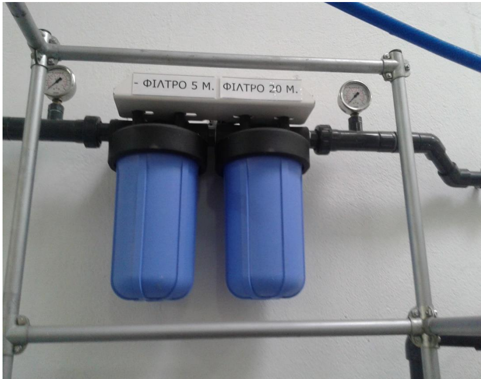
Εικόνα 46: Φίλτρα 5 και 20 \mu\text{m}
