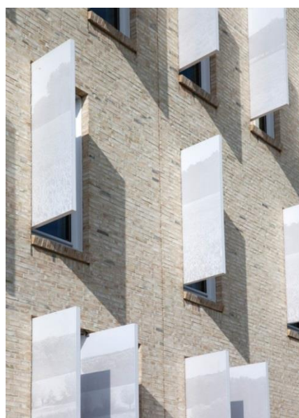
ΕΙΚΟΝΑ 55: ΚΑΤΑΚΟΡΥΦΑ ΠΛΕΥΡΙΚΑ ΣΚΙΑΣΤΡΑ – ΤΡΙΣΔΙΑΣΤΑΤΗ ΤΟΜΗ ΠΑΡΑΘΥΡΟΥ ΜΕ ΣΚΙΑΣΤΡΟ ( HTTP://WWW.KTIRIO.GR )
