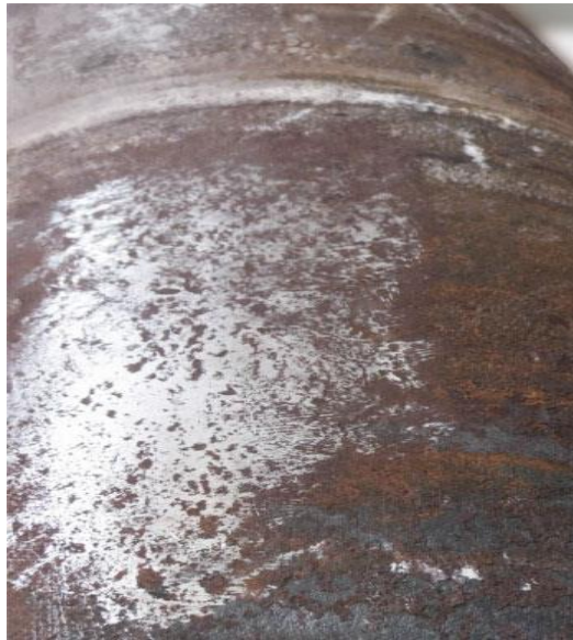
Εικόνα 66 Προετοιμασία Επιφανείας
