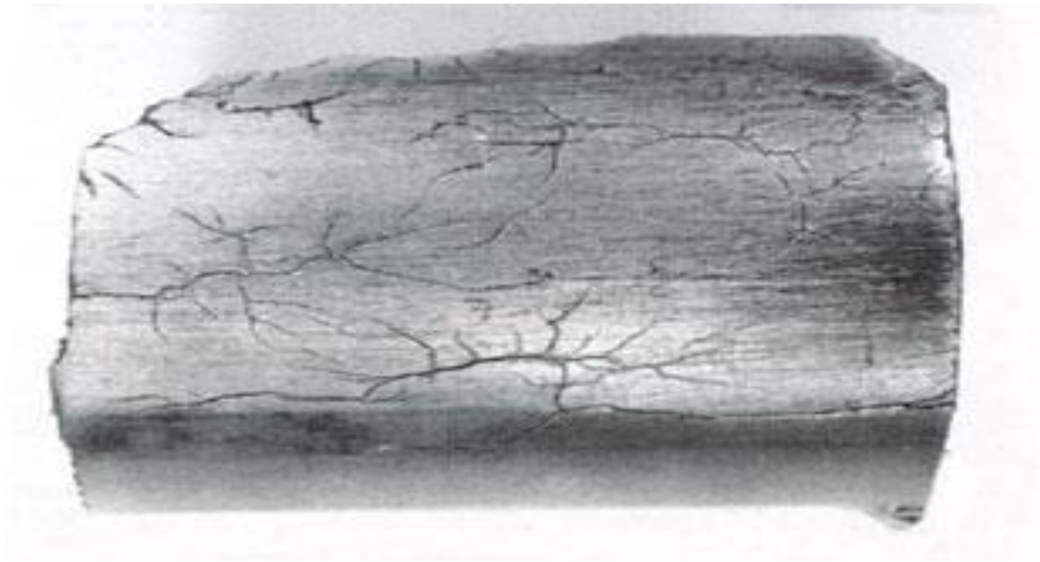
Εικόνα 17: Διάβρωση με μηχανική καταπόνηση [11]
