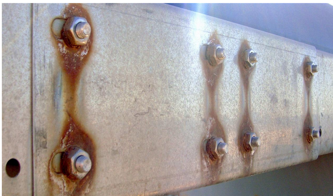
Εικόνα 12: Γαλβανική διάβρωση [7]
