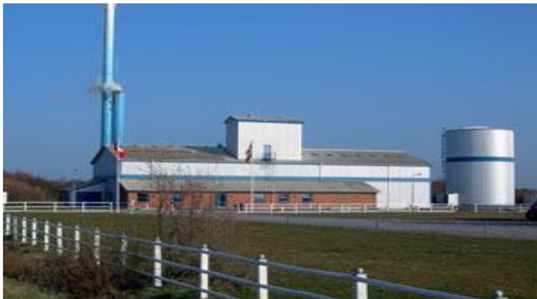
Εικόνα 50. Εγκατάστασης Δανια Harboore
