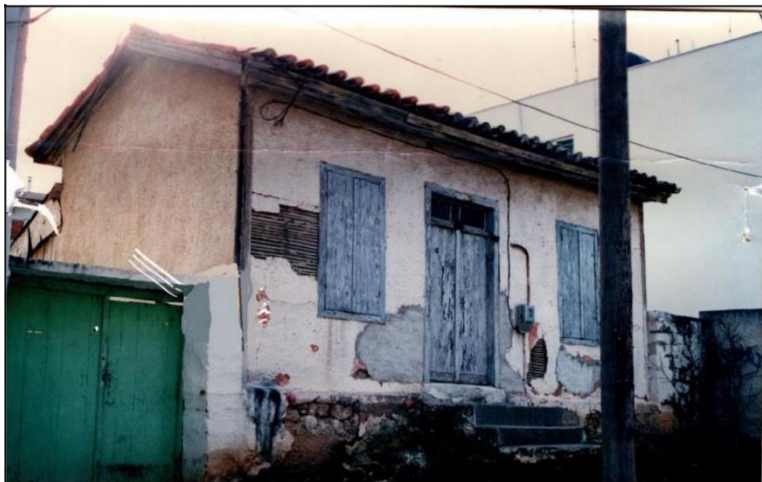
Προσφυγική κατοικία στον Συνοικισμό. Τύπος κατοικίας της ΕΑΠ. Διακρίνεται η θεμελίωση από επιχρισμένη λιθοδομή και οι φέροντες τοίχοι από μπαγδαντί.
