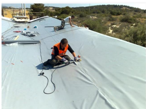
Εικόνα 15 Θερμομόνωση και στεγανοποίηση κτιρίου σε σχήμα V με διογκωμένη πολυστερίνη και μεμβράνη επικόλλησης PVC. 42
