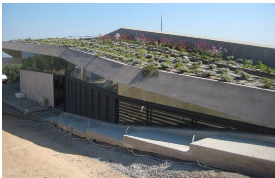
Εικόνα 27 Έργο της εταιρείας OS Green Roofs στην Συκάμινο 67
