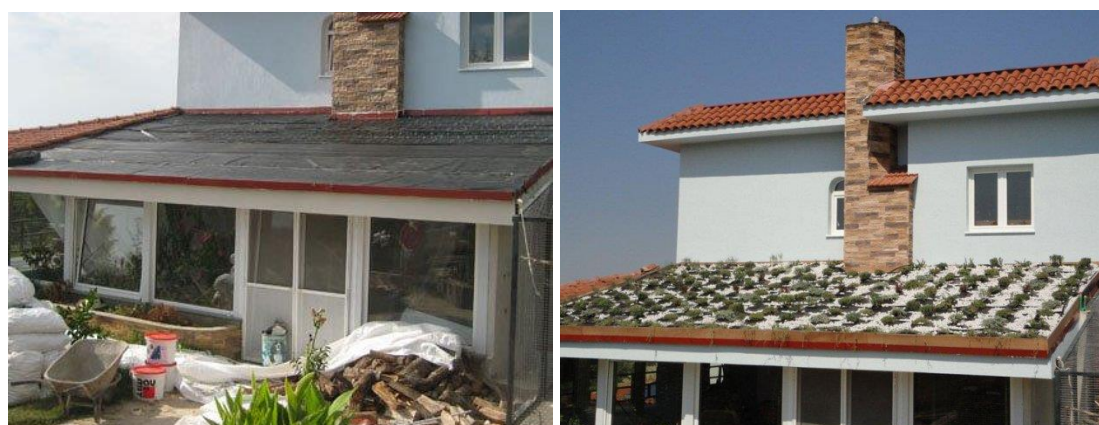
Εικόνα 25 Προετοιμασία στέγης για την φύτευση. Τοποθέτηση βλάστησης σε δώμα με κλίση 5° – 15° 65
