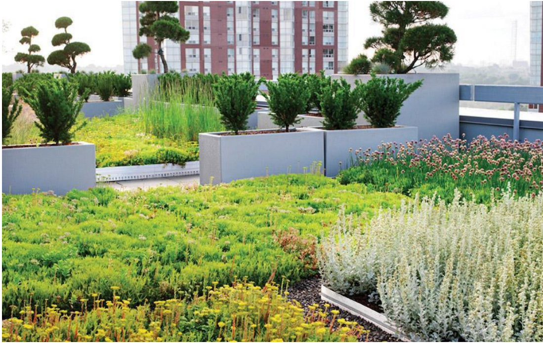
Εικόνα 5 Εκτατικός τύπος φυτεμένου δώματος 12
