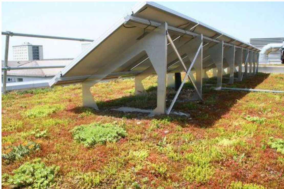
Εικόνα 30 Συνδυασμός φύτευσης δώματος με τοποθέτηση φωτοβολταικών συστημάτων
