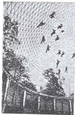
Σχ. 1. Τροῦλλος Zeiss Dywidag. Μεταλλικὸς σκελετὸς χρησιμεύων συγχρόνως ὡς ἰκρίωμα καὶ ὡς ὄπλισμός τοῦ τροῦλλου
