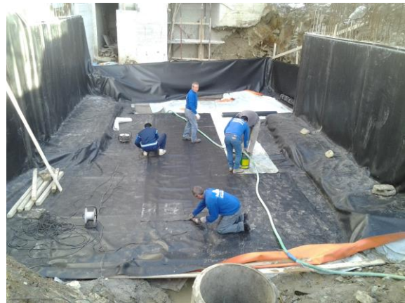
Εικόνα 4.1 Στεγάνωση Υγραμόνωση Θεμελίωσης (Στεγανολεκάνη) - Άγιοι Απόστολοι Ευβοίας. [33]
