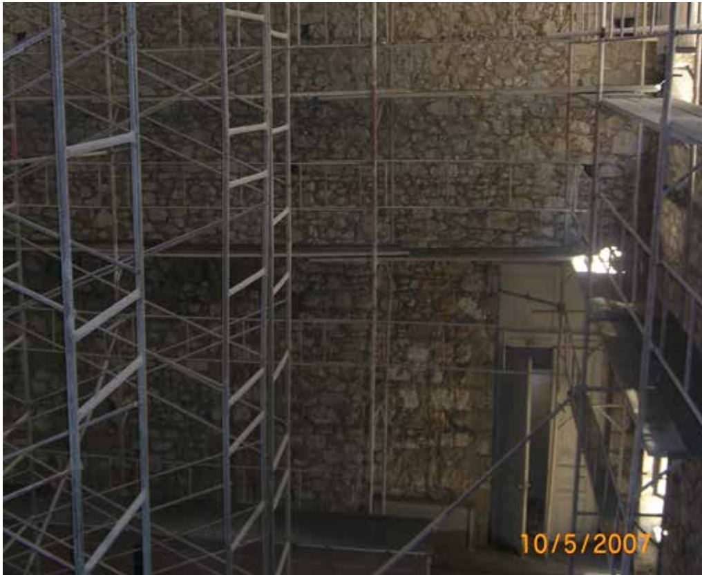
Καθαίρεση παλαιού επιχρίσματος.
