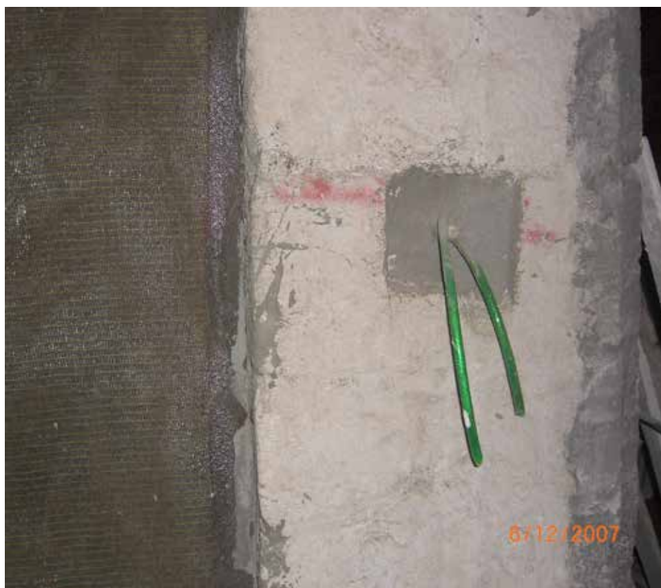
Τοποθέτηση πλάκας αγκύρωσης 16*16*1.
