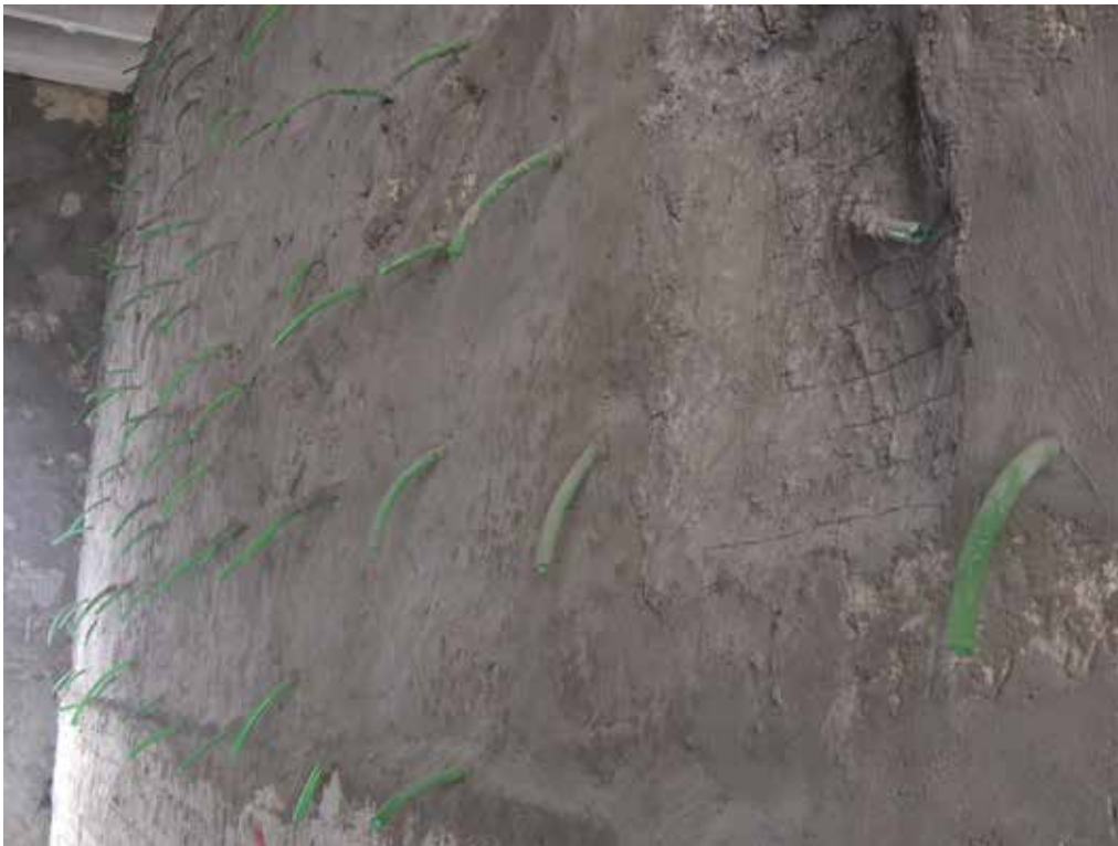
Πλήρωση κενών λιθοδομής με τσιμεντενέματα.
