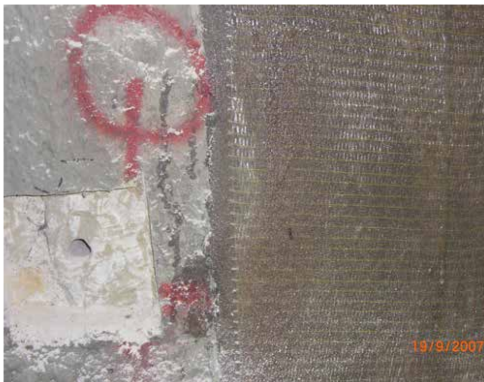
Τοποθέτηση πλάκας αγκύρωσης 16*16*1.
