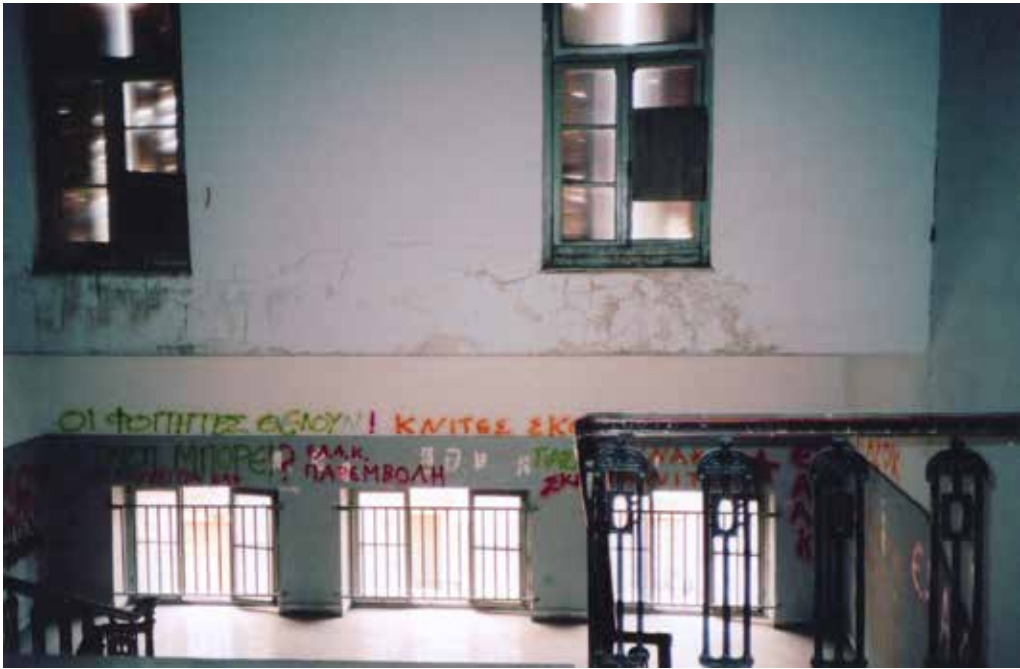
Κεντρικό κλιμακοστάσιο, Γ' όροφος.
