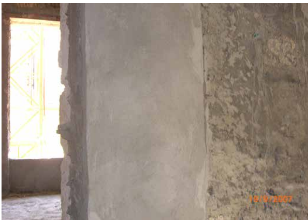
Εξομάλυνση της επιφάνειας με επισκευαστικό κονίαμα.
