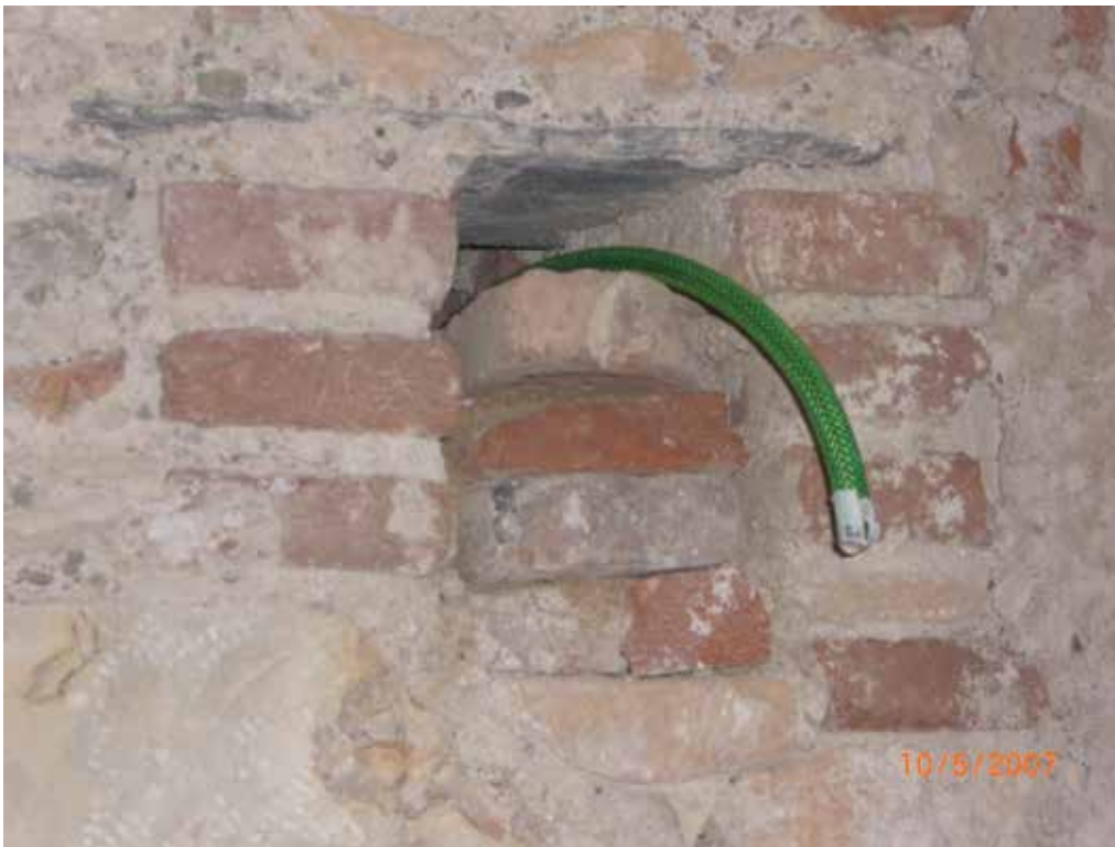
Καθαίρεση παλαιού επιχρίσματος λιθοδομής με υδροβολή και αμμοβολή. Τοποθέτηση αλφαιδολάστιχου.
