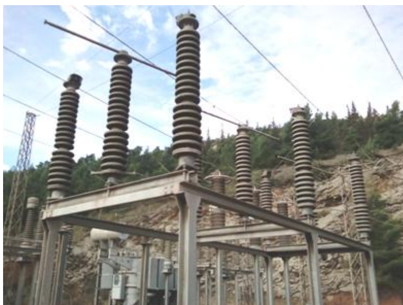
Ο ΑΠΟΖΕΥΚΤΗΣ 150 kV ΜΕ “ ΚΛΕΙΣΤΑ ” ΚΑΙ “ ΑΝΟΙΚΤΑ ” ΜΑΧΑΙΡΙΑ
