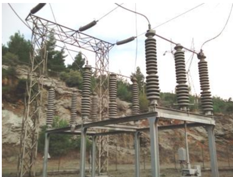
Ο ΑΠΟΖΕΥΚΤΗΣ 150 kV ΜΕ “ ΚΛΕΙΣΤΑ ” ΚΑΙ “ ΑΝΟΙΚΤΑ ” ΜΑΧΑΙΡΙΑ
