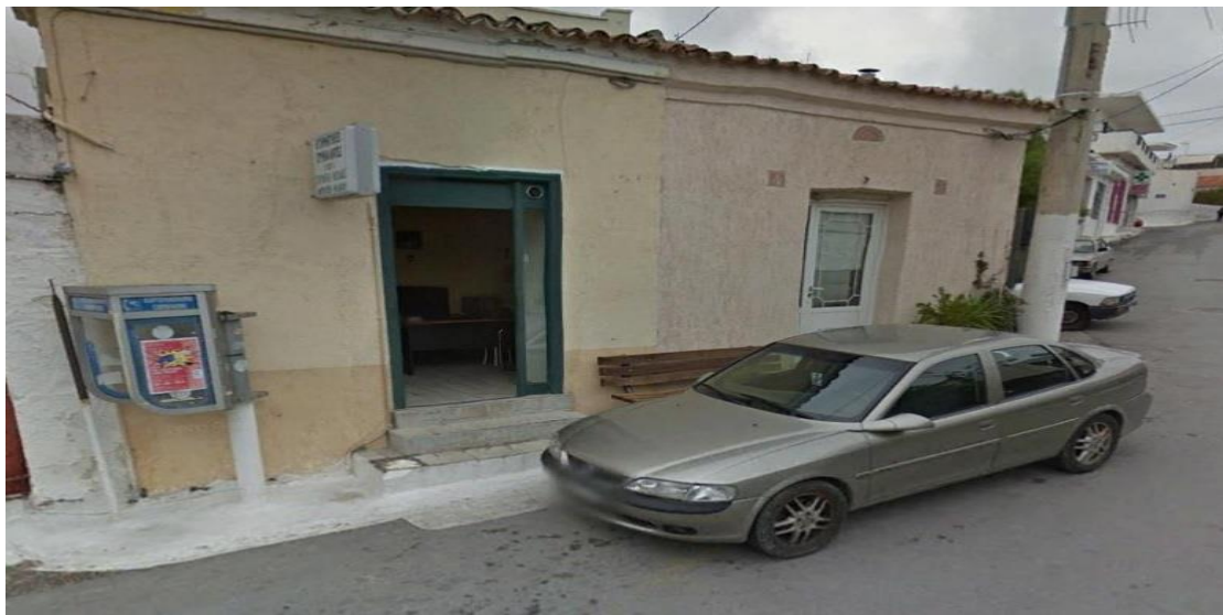
Εικόνα 3.1.6 : Παλαιό κτίριο στον Κουβαρά.
