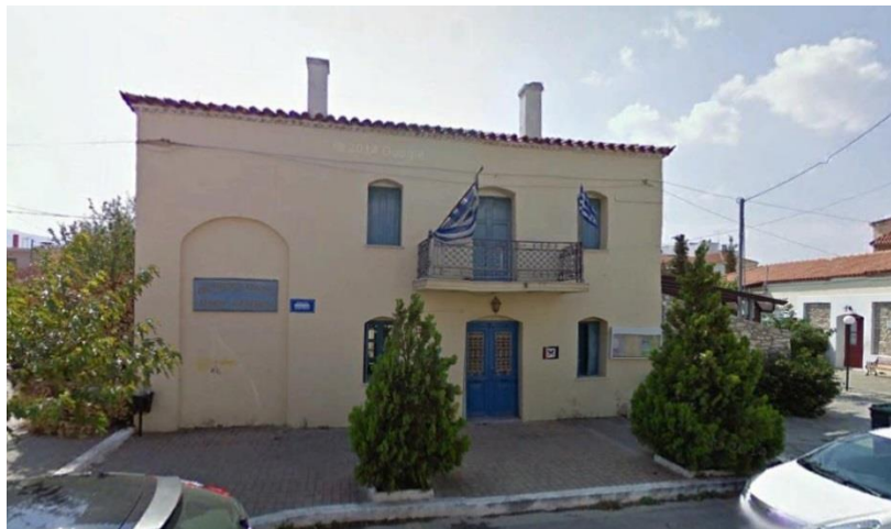
Εικόνα 3.6: Άποψη διατηρητέου κτιρίου στην πλατεία Καλυβίων.
