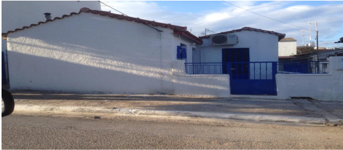
Εικόνα 3.1.4 : Παλιό κτίριο στην Π. Φώκαια.
