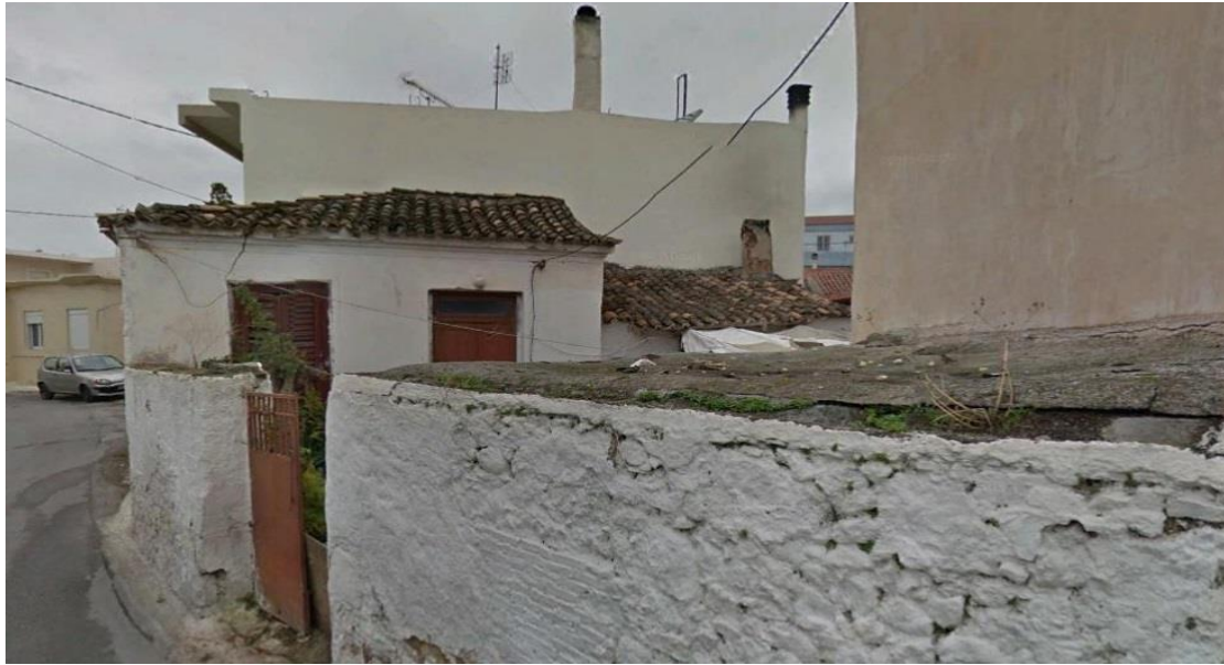
Εικόνα 3.1.2 : Παλαιό κτίριο στον Κουβαρά.
