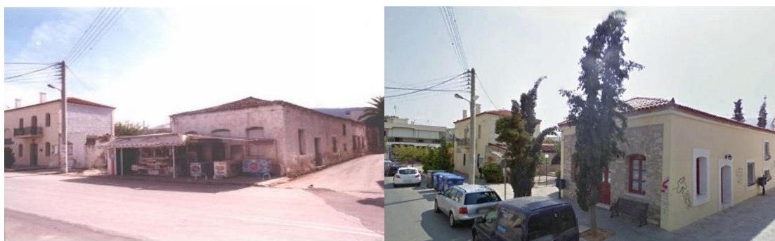
Εικόνα 3.7 : Άποψη διατηρητέων κτιρίων στην πόλη Καλυβίων (αριστερά φωτογραφία από το 1980 και δεξιά σημερινή).
