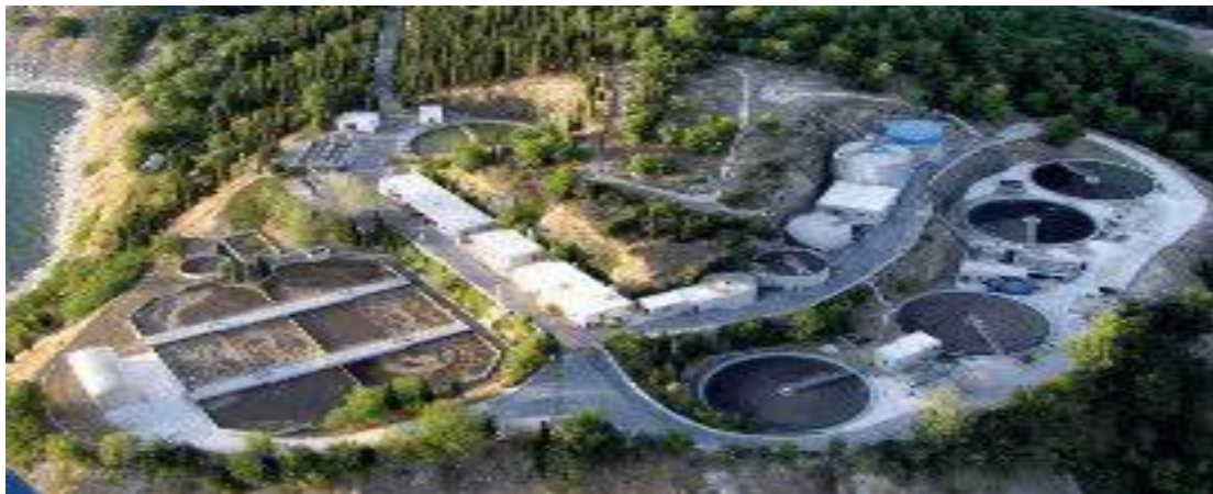
Εικόνα 5.1.3 : Παράδειγμα βιολογικού σταθμού επεξεργασίας λυμάτων.
