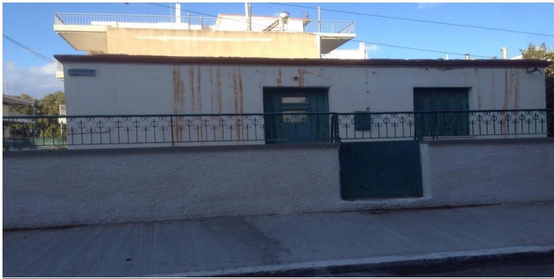
Εικόνα 3.1.4 : Παλιό κτίριο στην Π. Φώκαια.
