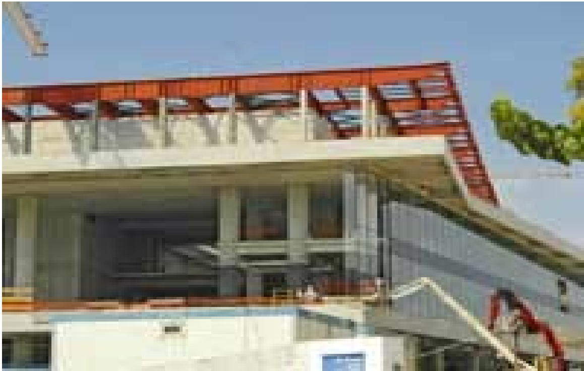
Σχήμα 21. Το Νέο Μουσείο της Ακρόπολης υπό κατασκευή
