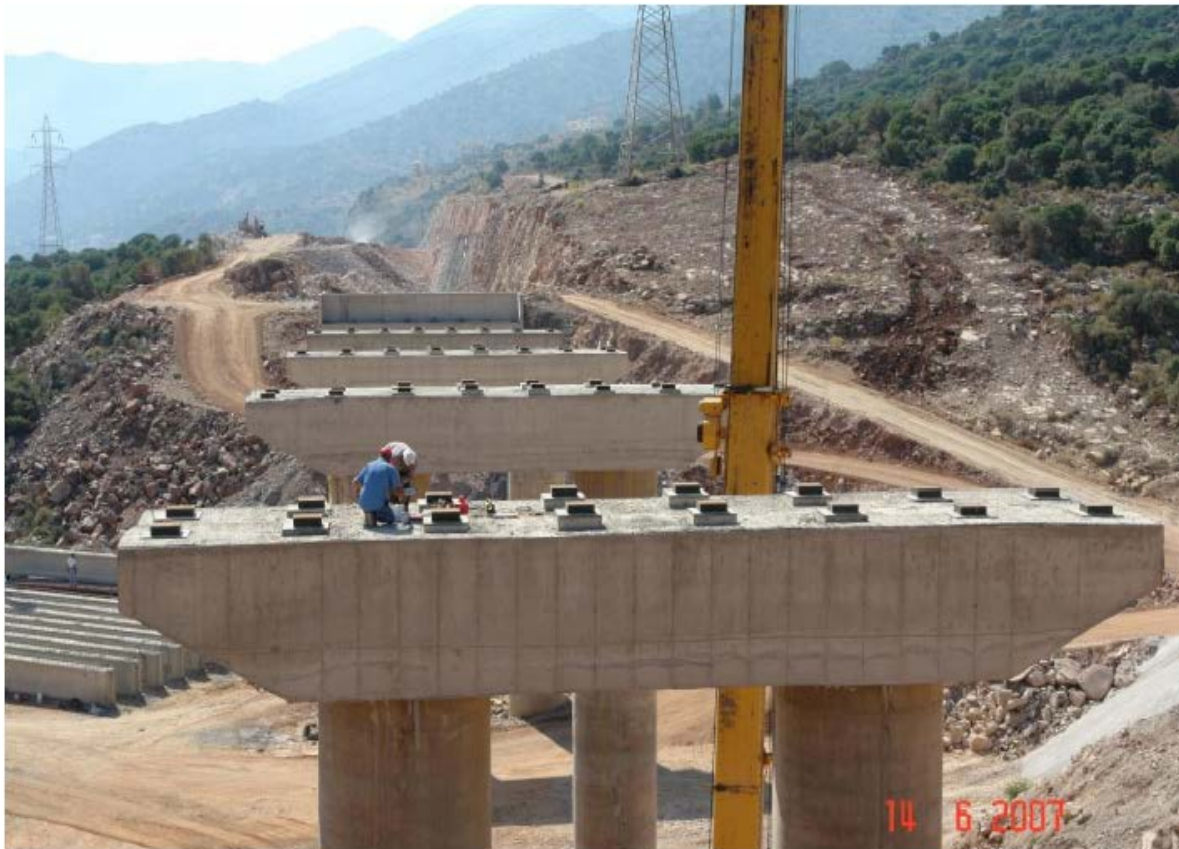
Σχήμα 24. Φωτογραφία από την εγκατάσταση των εφεδράνων
