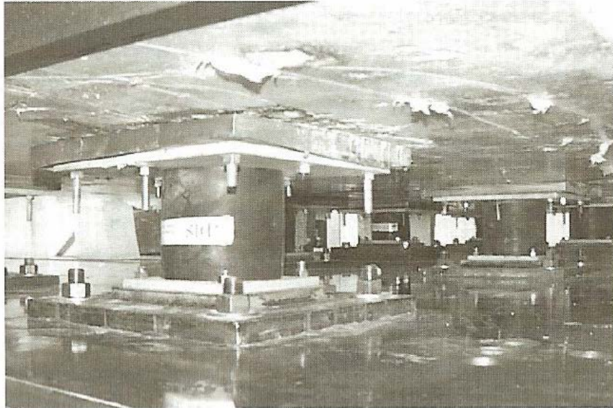
Σχήμα 5. Ελαστομεταλλικό εφέδρανο - ELB
