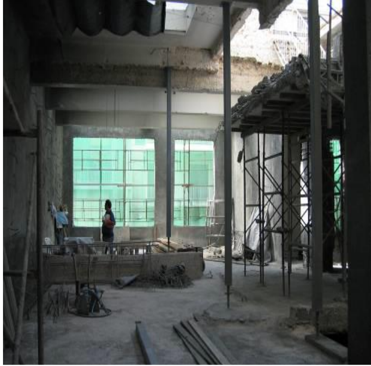
Πηγή ως άνω, φωτ.6 : όροφος κτιρίου χώρος με φωταγωγό
