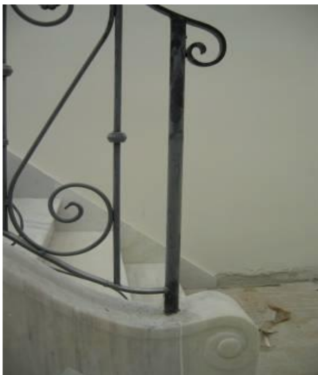
Πηγή ως άνω, φωτ.13 κιγκλίδωμα εσωτ. σκάλας
