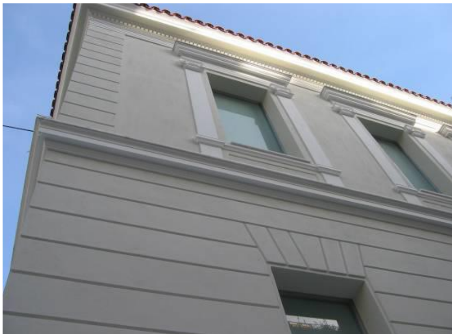
Πηγή ως άνω, φωτ.18 : όψη από οδό Χανίων
