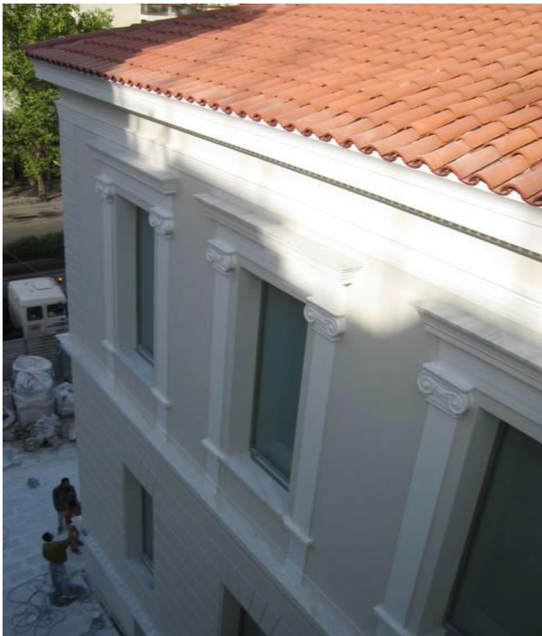
Πηγή ως άνω φωτ.19 όψη από οδό Χανίων
