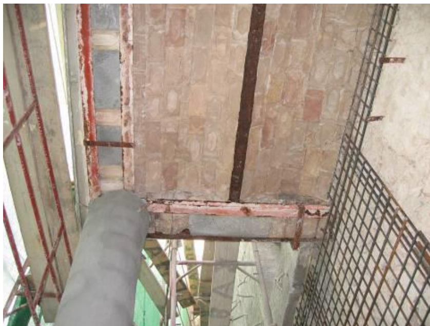
Πηγή ως άνω, φωτ.9 : ενίσχυση εξωτερικής όψης
