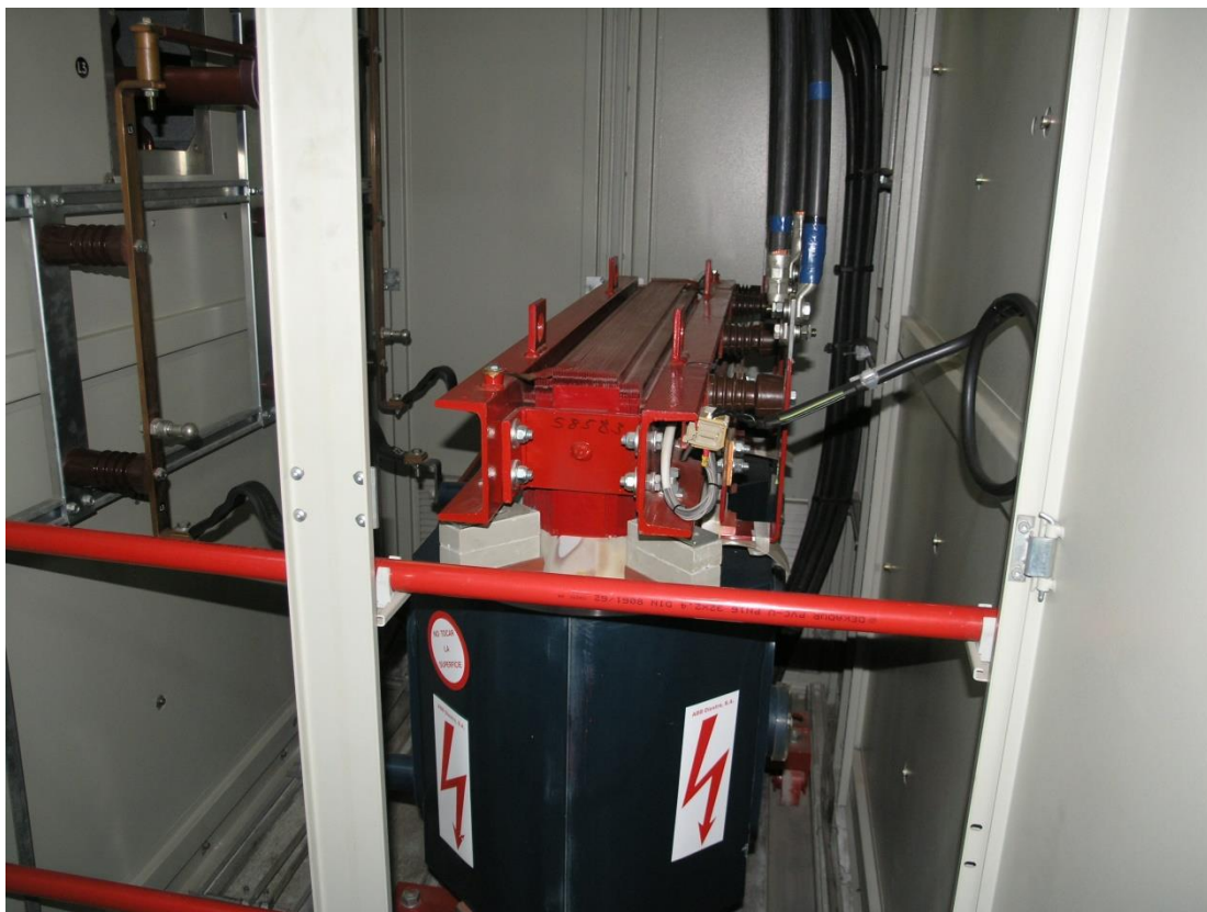
Μετασχηματιστές διέγερσης PIELSTICK1 & PIELSTICK2 & PIELSTICK3
