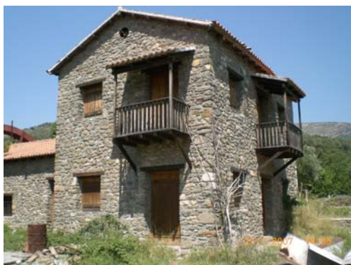
Εικ. 2.1: Κτίσμα από τοιχοσώματα και συνδετικό κονίαμα.
