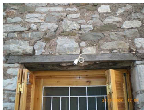
Εικ. 2.4: Ξύλινο στοιχείο στήριξης της τοιχοποιίας στο πρέκι.
