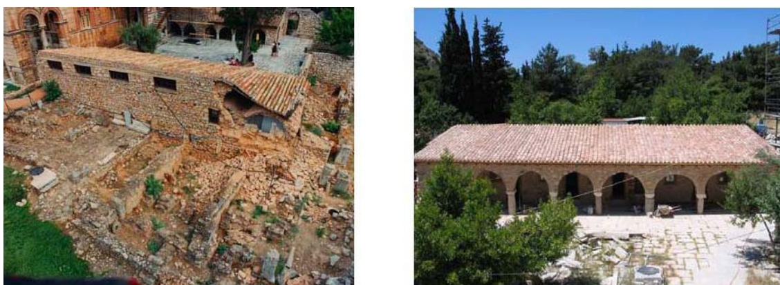
Εικ. 13.3: Δυτική πτέρυγα πριν και μετά τις εργασίες στερέωσης-αποκατάστασης.
