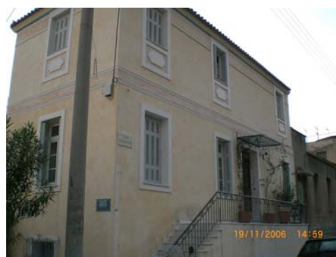
Εικ. 2.2 : Κτίσματα με επικάλυψη επιχρίσματος (σοβάς).
