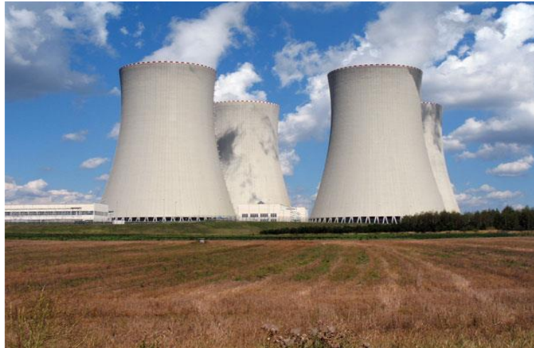
Εικόνα 1. Βιομηχανικός πύργος Ψύξης Ατμοηλεκτρικού σταθμού (προσαρμογή από Μποντοζόγλου, 2015).
