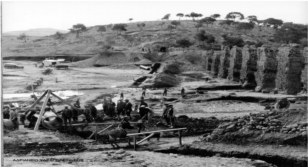
Κατασκευαστικά έργα στο Αδριάνειο υδραγωγείο(Αρχείο ΕΥΔΑΠ)
