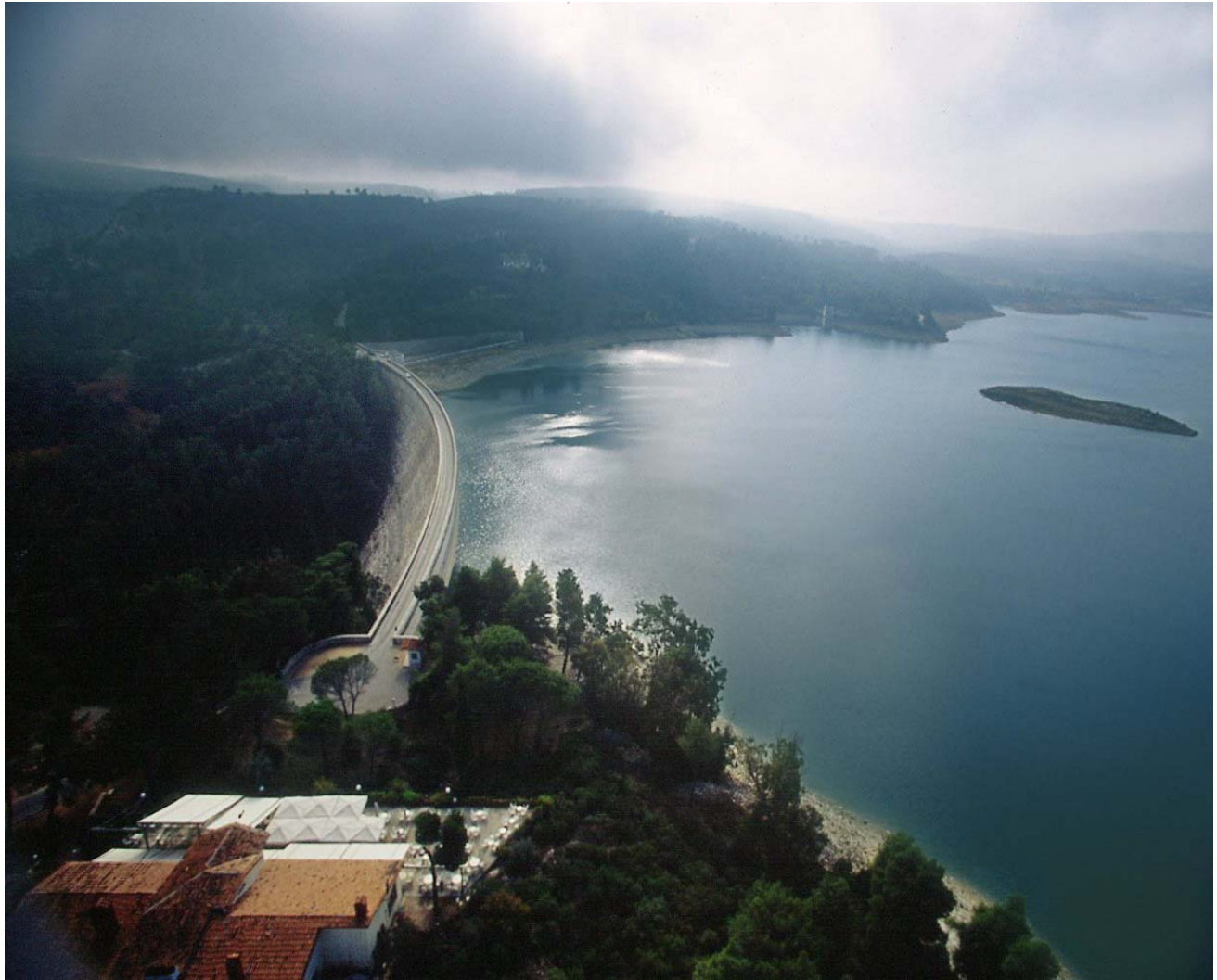
Φράγμα Λίμνης Μαραθώνα. (Αρχειο ΕΥΔΑΠ)
