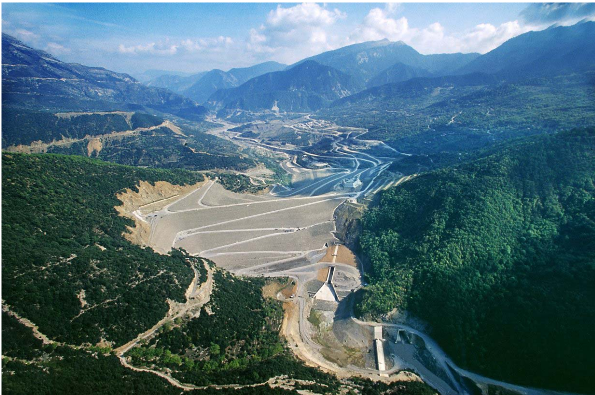
Φράγμα Ευήνου(Αρχείο ΕΥΔΑΠ)
