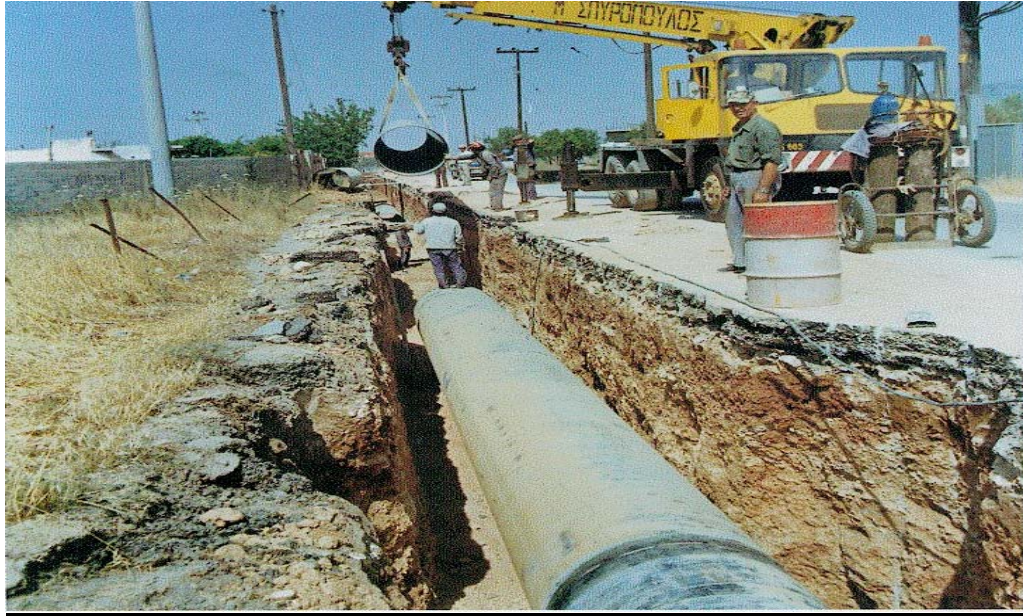
Κατασκευή Αγωγού(Αρχείο ΕΥΔΑΠ)
