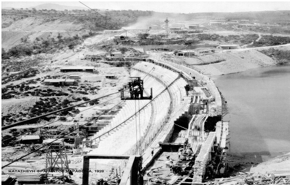
Κατασκευή φράγματος Μαραθώνα, 1928(Αρχείο ΕΥΔΑΠ)
