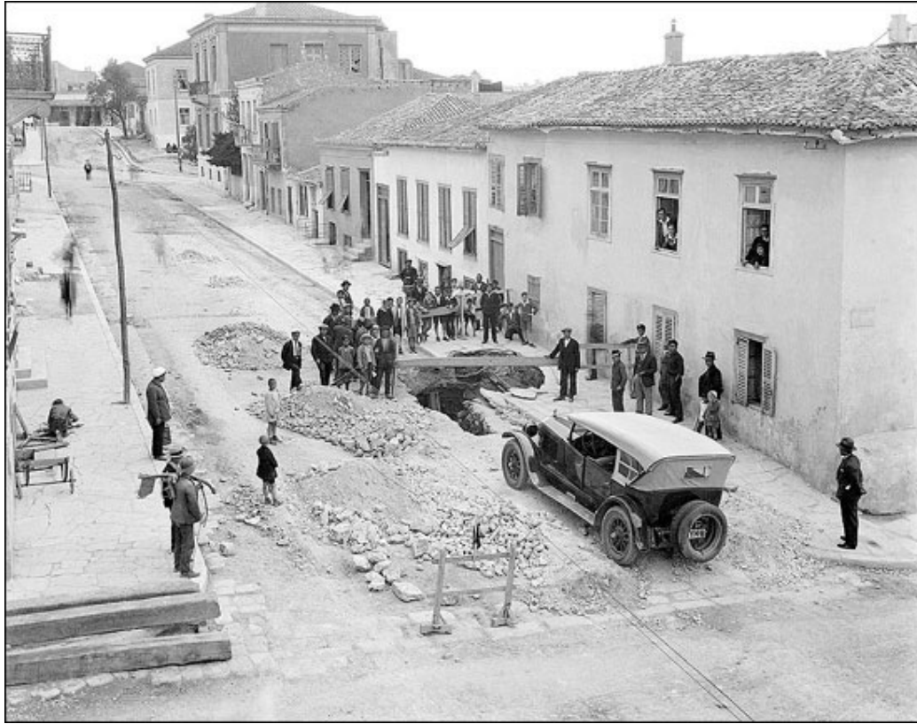
Επισκευή αγωγού εντός πόλεως, 1936 (φωτ. Αρχείο ΕΥΔΑΠ)
