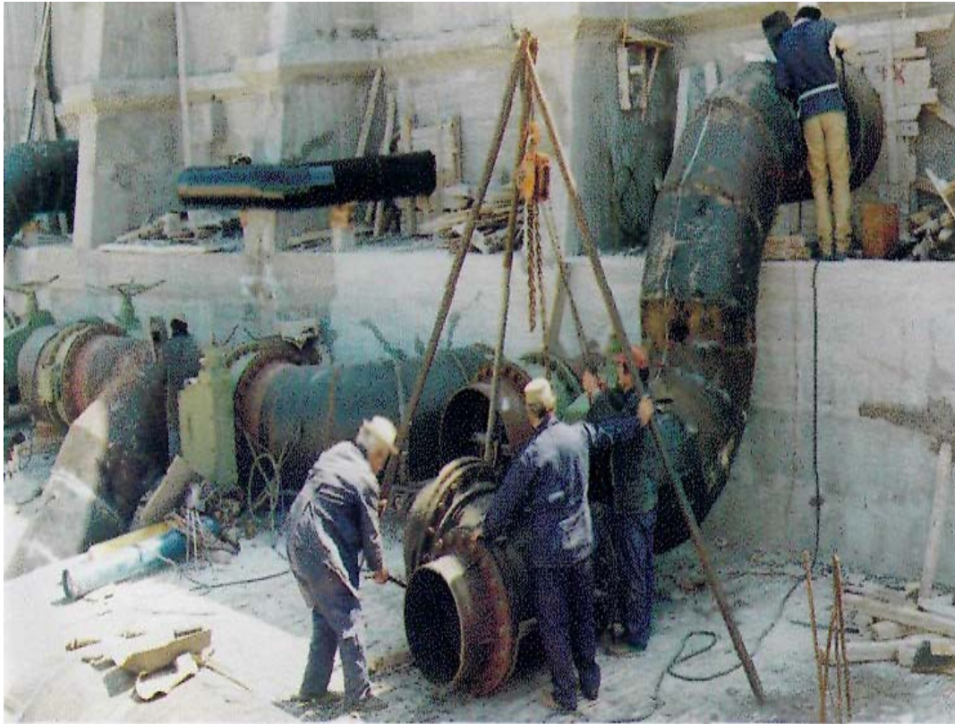
Κατασκευή Αγωγού(Αρχειο ΕΥΔΑΠ)
