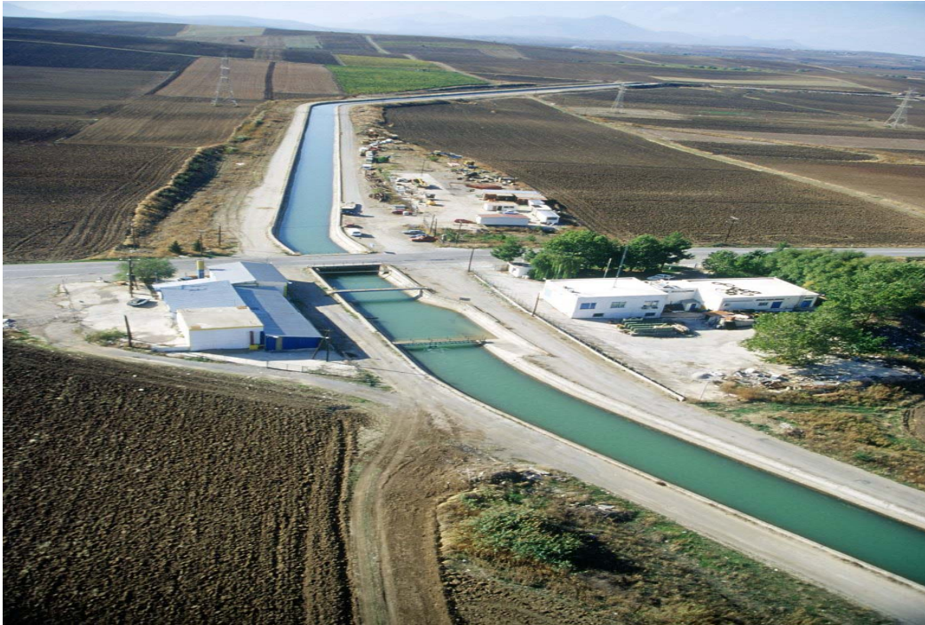
Ενωτικό Υδραγωγείο Μόρνου-Υλίκης (φωτο 2000 Αρχείο ΕΥΔΑΠ)
