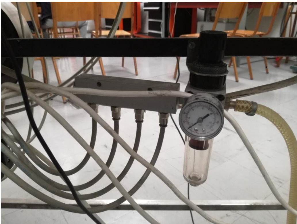
Εικόνα 30 Μονάδα συντήρησης (όψη χειριστή)
