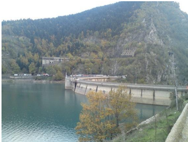
Σχήμα 1.1 Υδροηλεκτρικό φράγμα στη λίμνη Πλαστήρα (πηγή: wikipedia)
