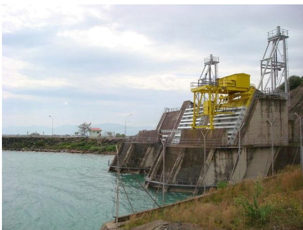
Σχήμα 1.2 Υδροηλεκτρικό φράγμα Στράτου στον Αχελώο (πηγή: wikipedia)
