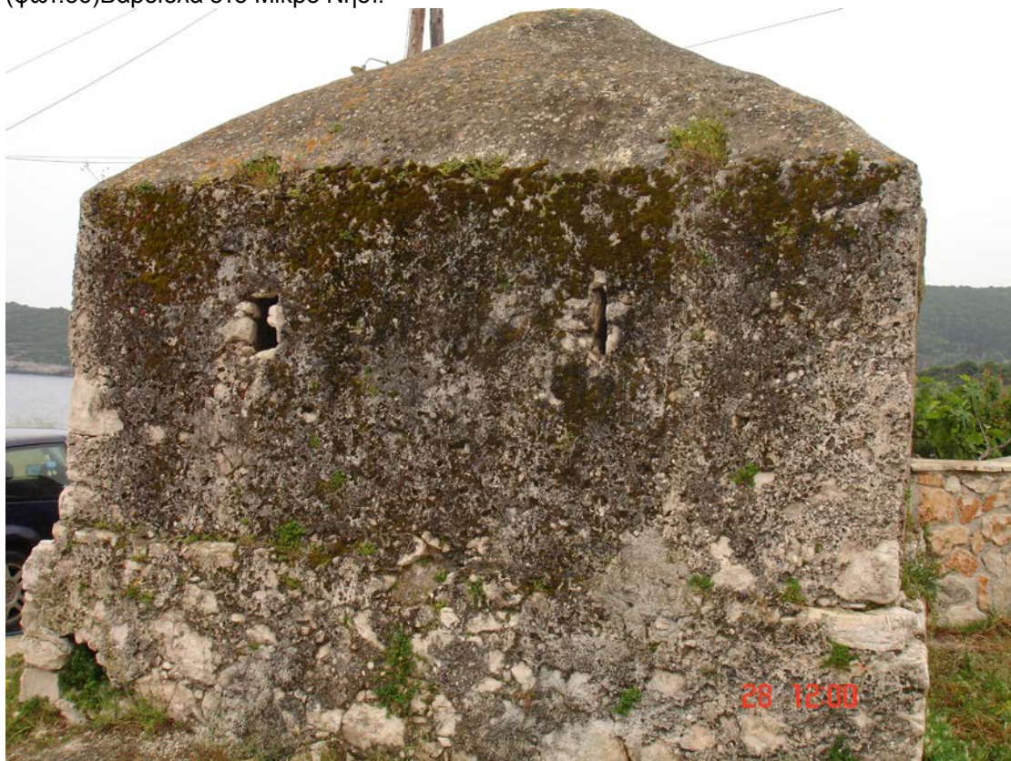
(φωτ.57) Βόρεια όψη.
