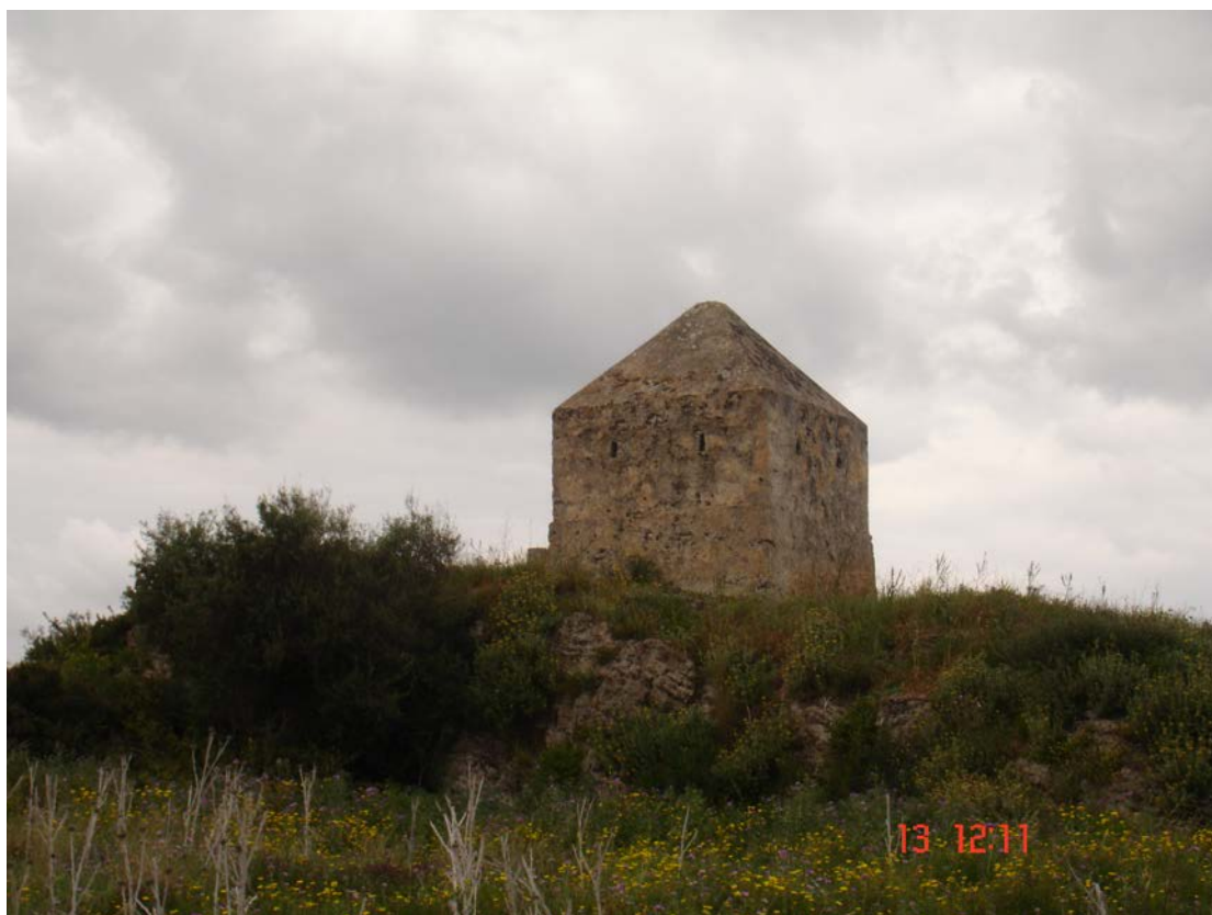
(φωτ.52)Β.Α. όψη.Πάνω στο λόφο.
