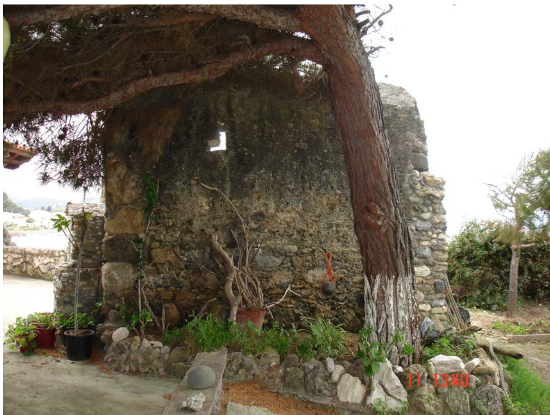
(φωτ.3)Σωζόμενος στο μεγαλύτερο μέρος ο νοτιοανατολικός τοίχος
