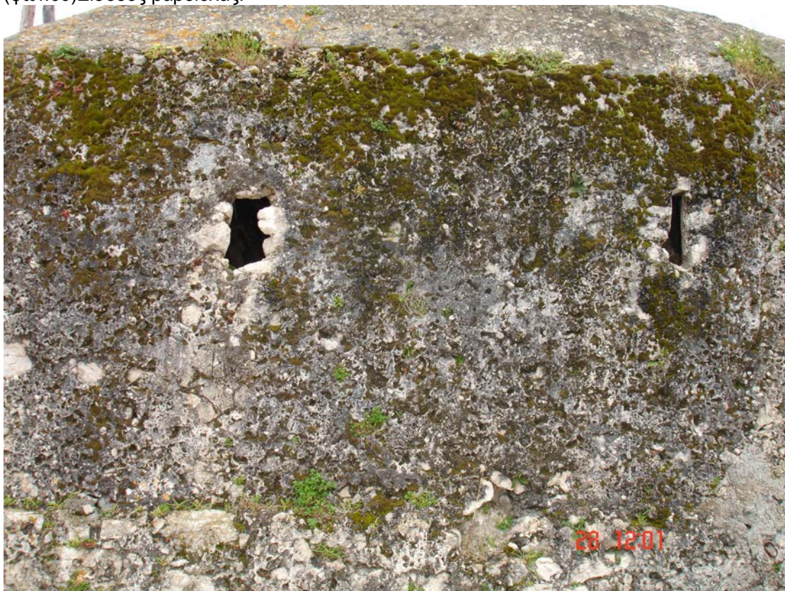
(φωτ.61)Τυφεκιοθυρίδες βόρειας πλευράς.
