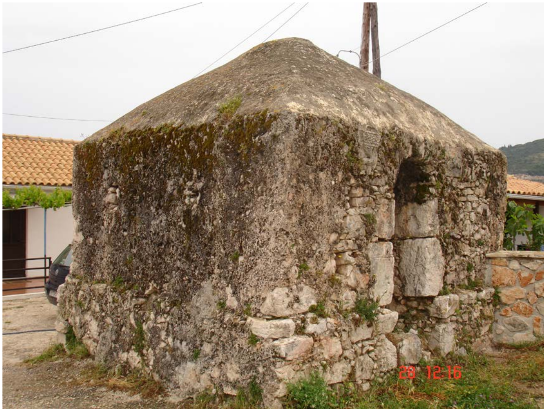
(φωτ.68)Φαίνεται καθαρά η ανακατασκευασμένη στέγη.
