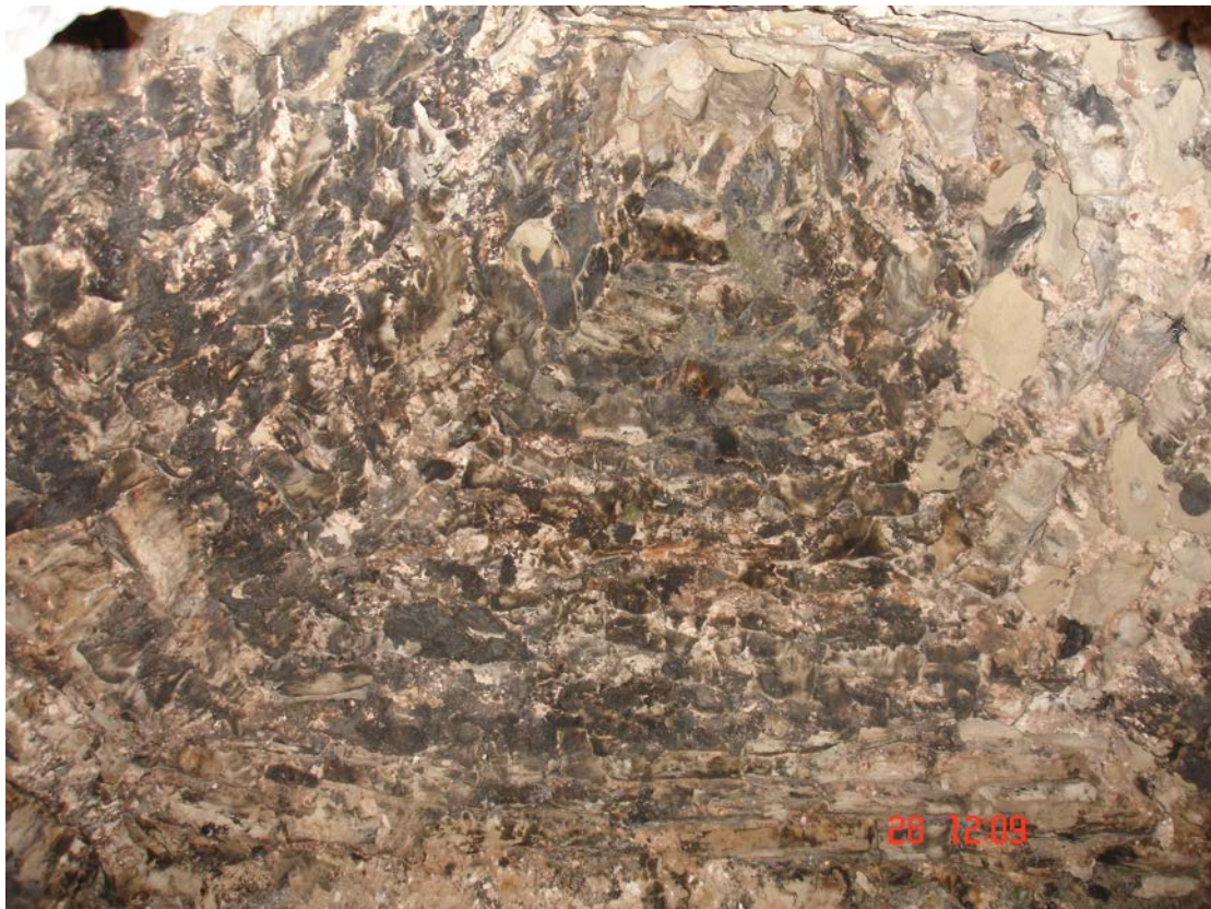
(φωτ.66)Εσωτερική άποψη ανακατασκευασμένης στέγης.
