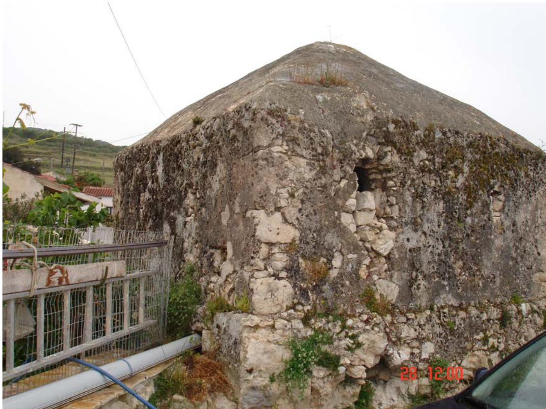
(φωτ.62)Νοτιοανατολική όψη βαρδιόλας.
