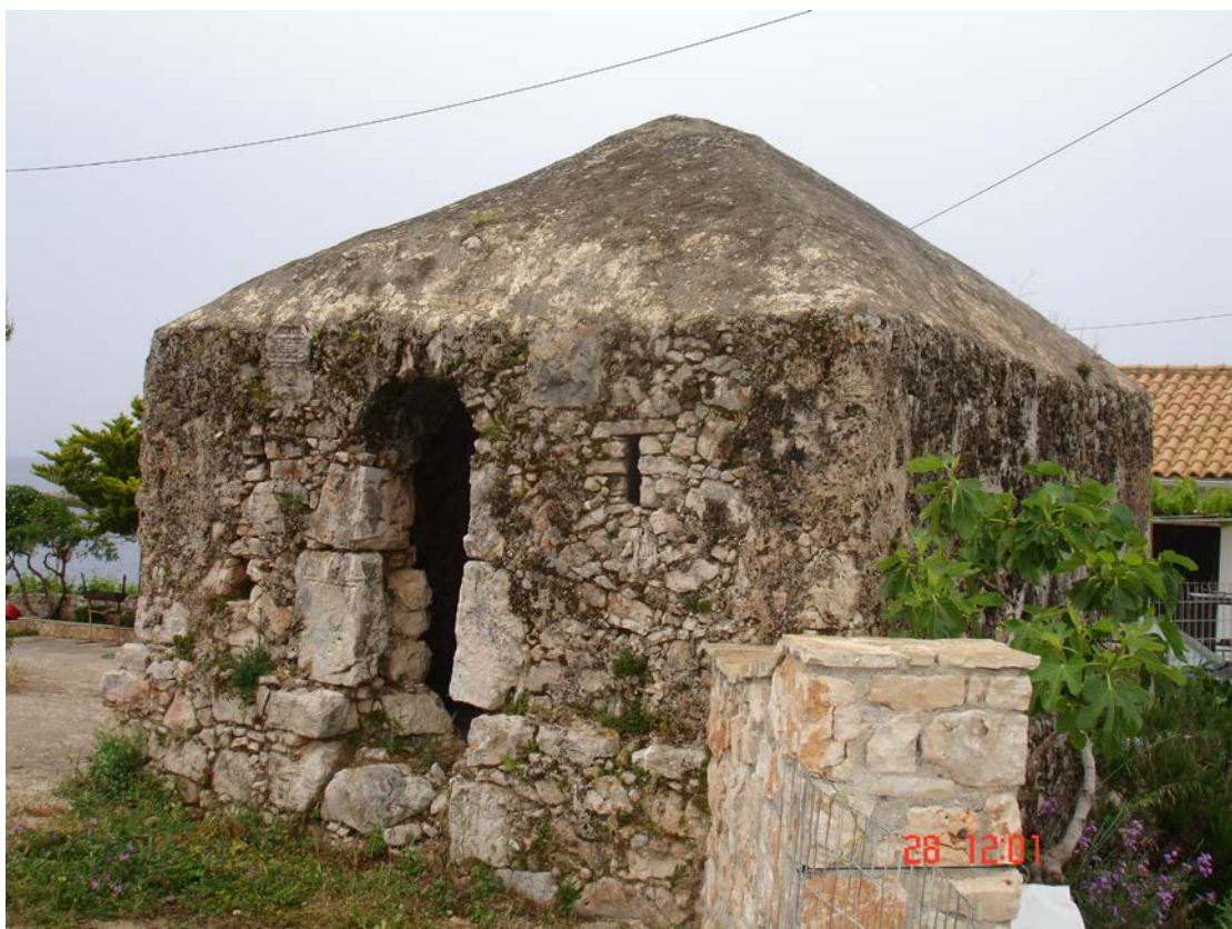
(φωτ.63)Νοτιοδυτική όψη βαρδιόλας.
