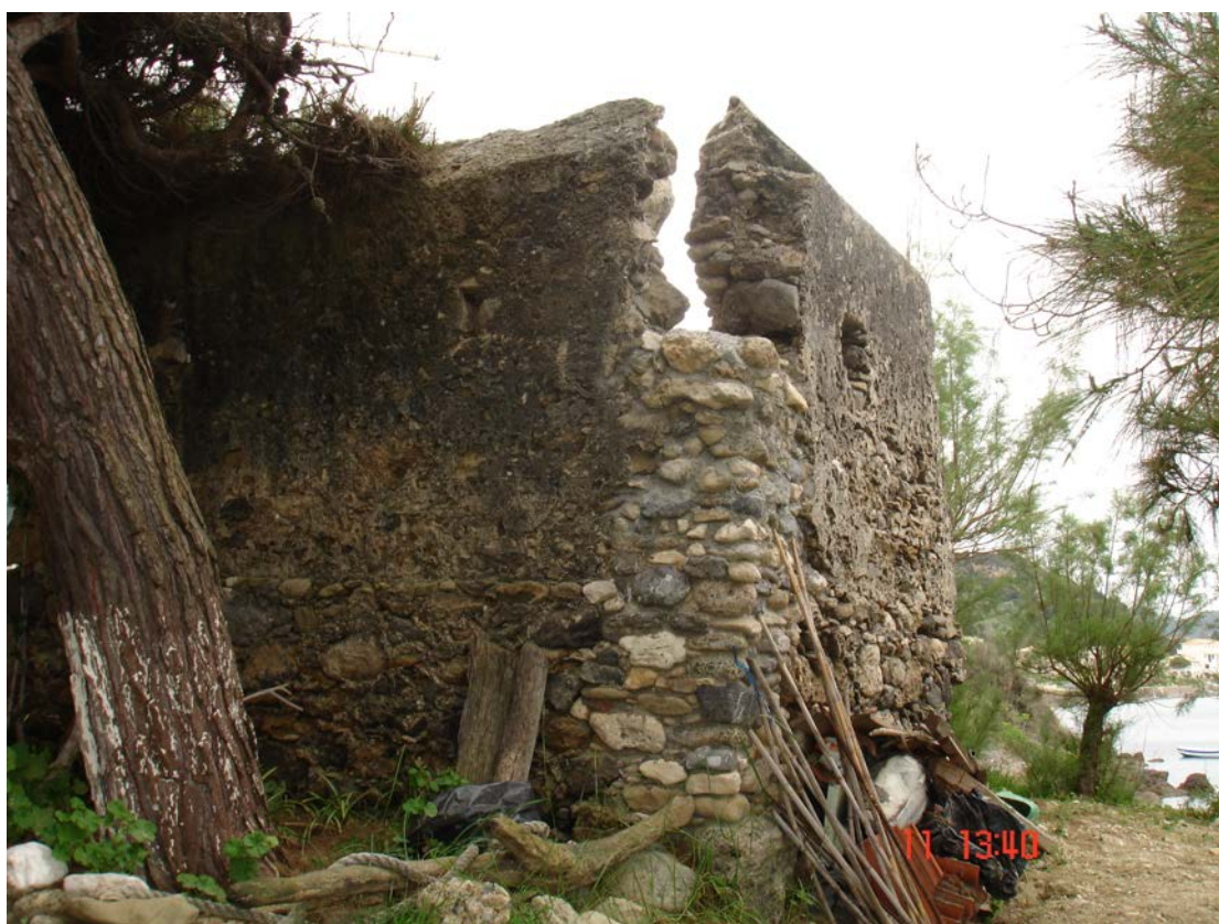
(φωτ.4)Επισκευή απο κατοίκους στη γωνία της προς αποφυγή καταστροφής της
