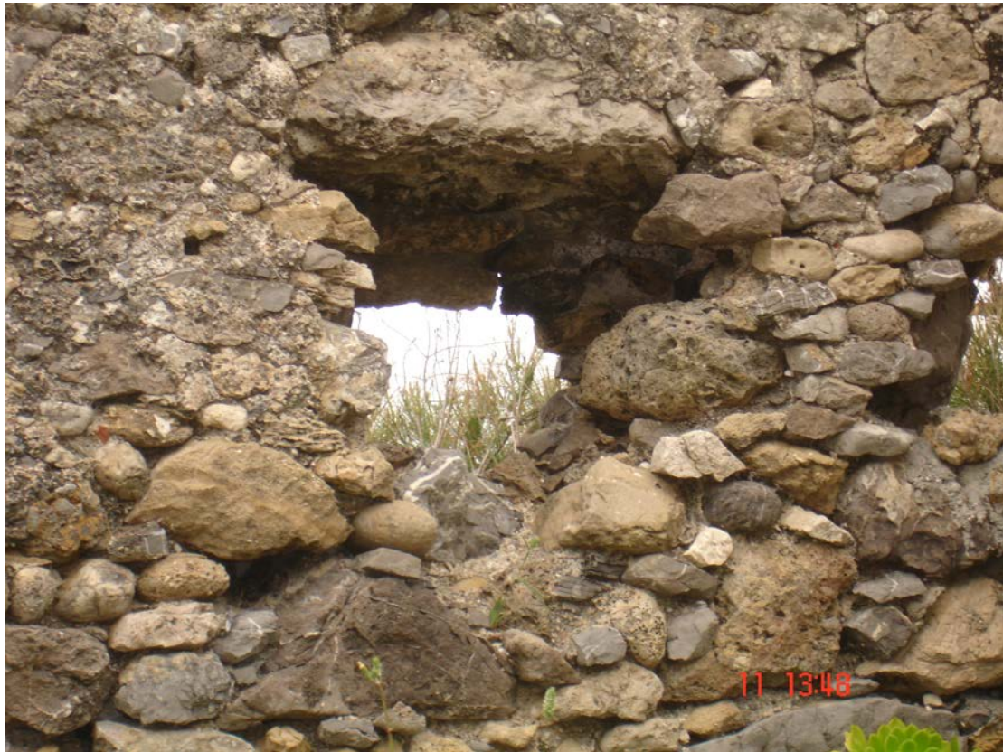
(φωτ.5)Τυφεκιοθυρίδα.Ανακατασκευασμένη απο τους κατοίκους.(Βλ.Διαφορά υλικού)
