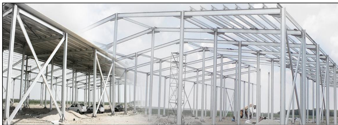
Εικόνα 15 : Μεταλλικό Βιομηχανικό Υπόστεγο
