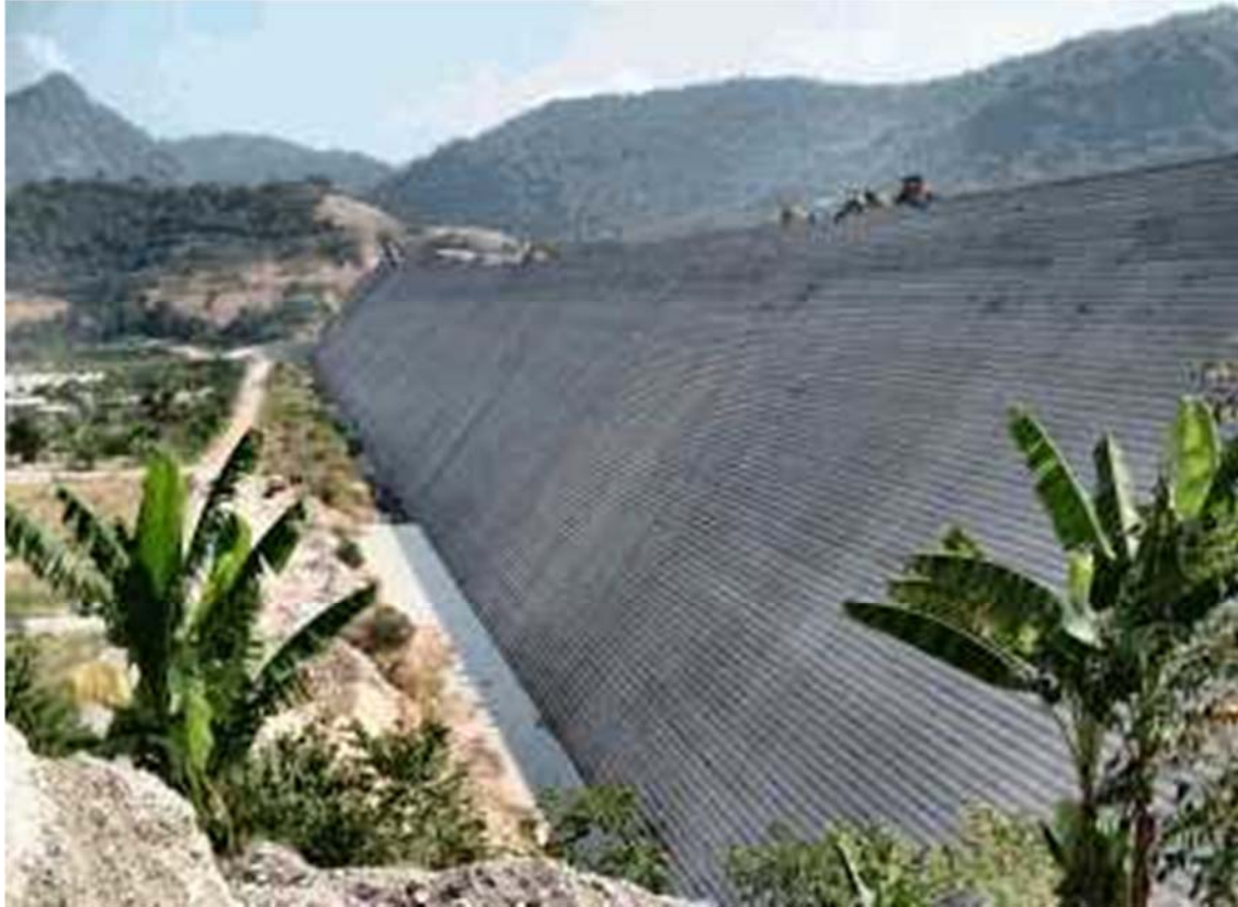
Εικόνα 21: Φράγμα Klong Tha Dan, Ταϊλάνδη
