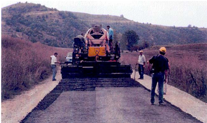
Εικόνα 7: Γρεβενά, θέση γεφύρι του Πασά, κατασκευή πιλοτικού οδοστρώματος με τέφρα. Διάστρωση του τεφροσκυροδέματος με finisher σε 2 στρώσεις σε θερμοκρασία περιβάλλοντος υψηλή κατά την
