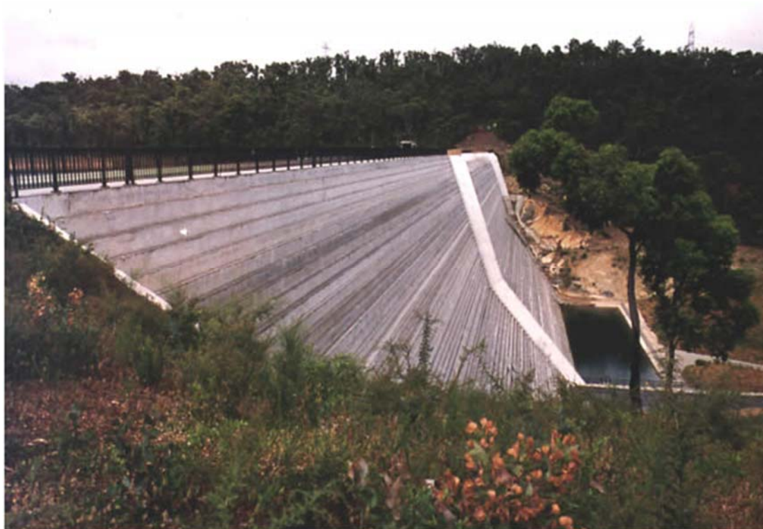
Εικόνα 13: Φράγμα Νέας Βικτωρίας, Αυστραλία
