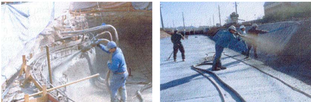
Εικόνα 8: Εκτοξευόμενο σκυρόδεμα για σταθεροποίηση πρανών ώρα της διάστρωσης
