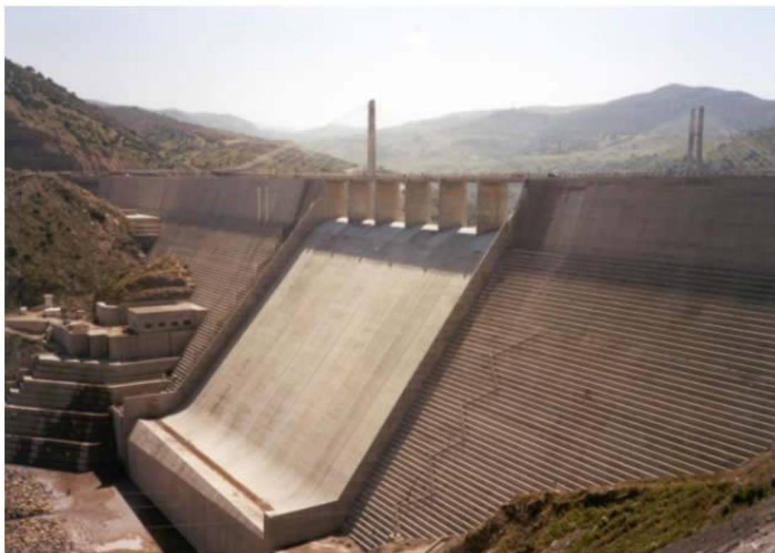
Εικόνα 11: Φράγμα Beni Haroun, Αλγερία
