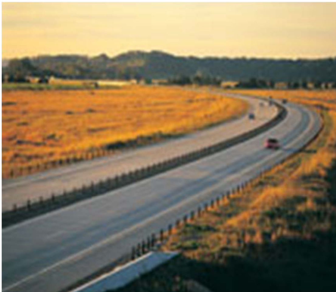
Εικόνα 12: Αυτοκινητόδρομος Yelgun-Chinderah, Australia
