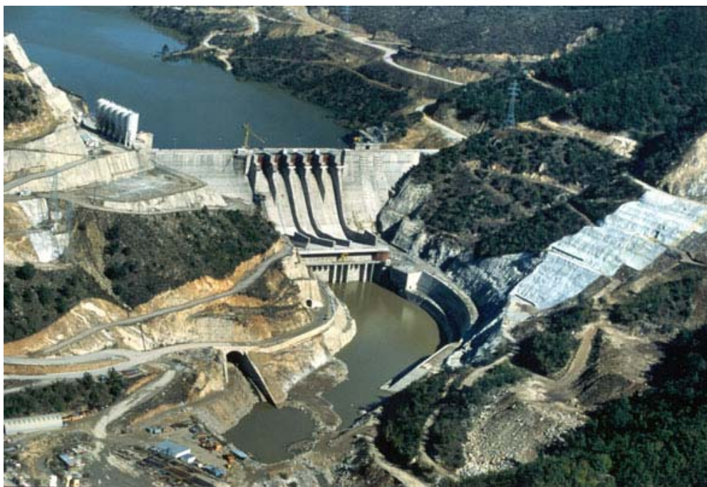
Εικόνα 10: Το φράγμα της Πλατανόβρυσης στον δήμο Δράμας
