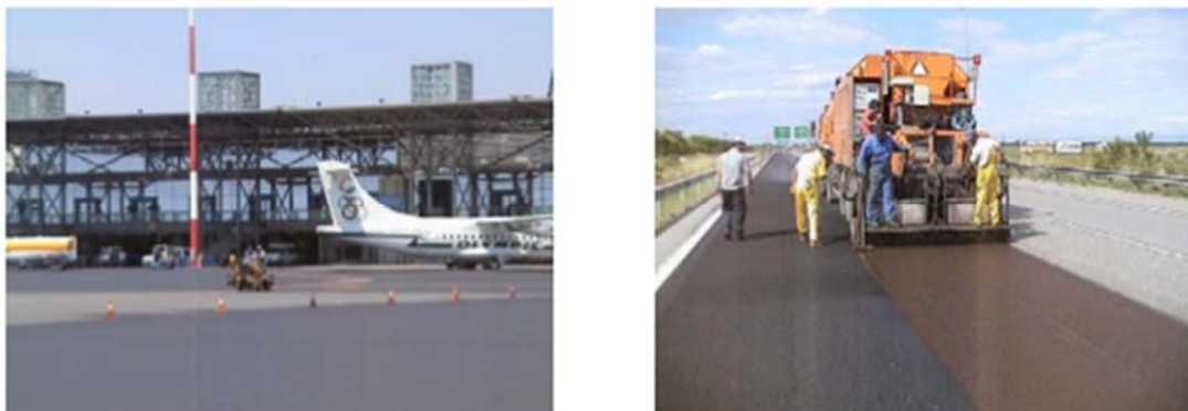
Εικόνα 4: Κατασκευή οδοστρώματος με σκυρία στο αεροδρόμιο Θεσσαλονίκης (2004) και στην Εθνική οδό Αθηνών Θεσσαλονίκης (2005)
