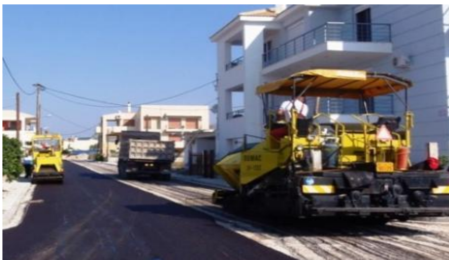
Εικόνα 6 Ασφαλτόστρωση δρόμων
