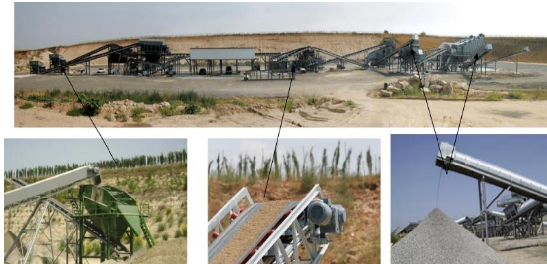
Εικόνα 26 Μονάδα ανακύκλωσης αδρανών υλικών Μακεδονίας Α.Ε
