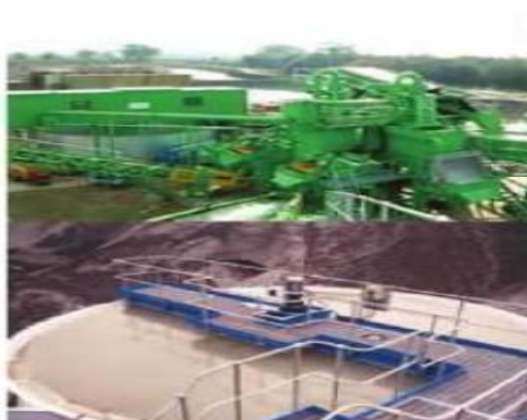
Εικόνα 28 Μονάδα πλύσεως (πάνω), πυκνωτής λάσπης (κάτω)
