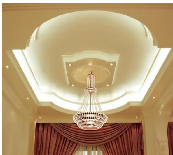
Εικόνα 5 Διακόσμηση εσωτερικών χώρων με γυψοσανίδα
