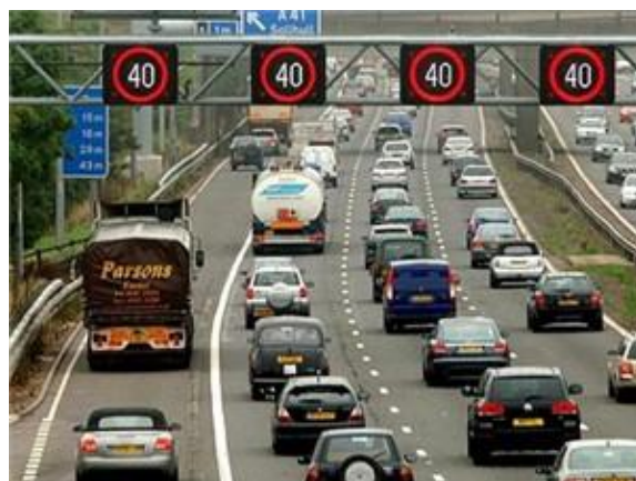
Εικόνα 47: Πινακίδες μεταβλητών ορίων ταχύτητας πάνω από τις λωρίδες κυκλοφορίας [1].
