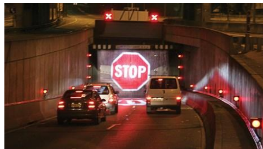
Εικόνα 50: Κινητά φράγματα φυσικού αποκλεισμού σε (α) Στοκχόλμη και (β) Σύνδνεϋ [1].
