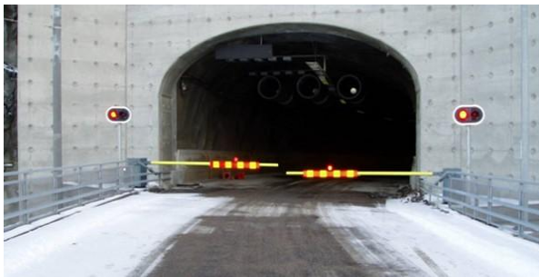
Εικόνα 50: Κινητά φράγματα φυσικού αποκλεισμού σε (α) Στοκχόλμη και (β) Σύνδνεϋ [1].
