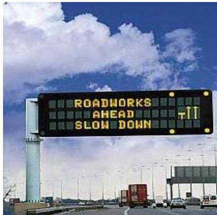
Εικόνα 38: Πινακίδα V.M.S. σε γέφυρα σήμανσης επάνω από το οδόστρωμα [13].
