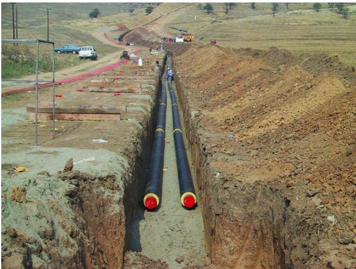
Εικόνα 4.1 Κατασκευή δικτύου τηλεθέρμανσης στην Νυμφασία Αρκαδίας
