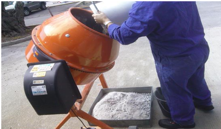
Εικόνα 9 Τοποθέτηση του υλικού στην βαρέλα για σκυροδέτηση
