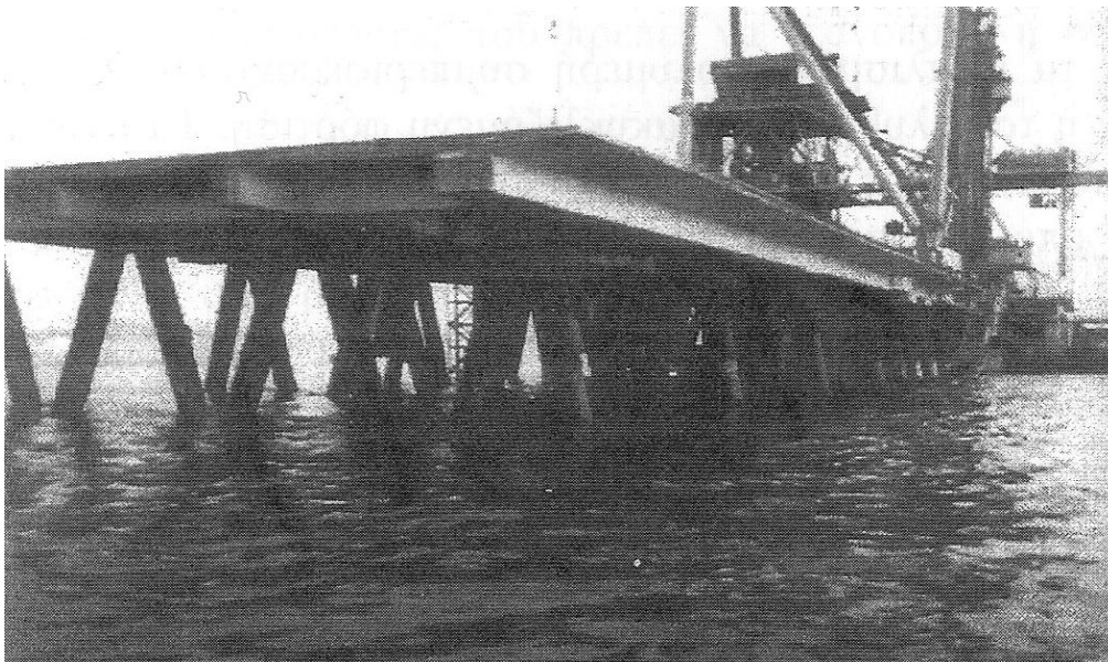
Σχήμα 3.2: (πηγή 2) Ενίσχυση πασσάλων με ανθρακονήματα στο Lamma Island Jetty του Χονγκ Κονγκ
