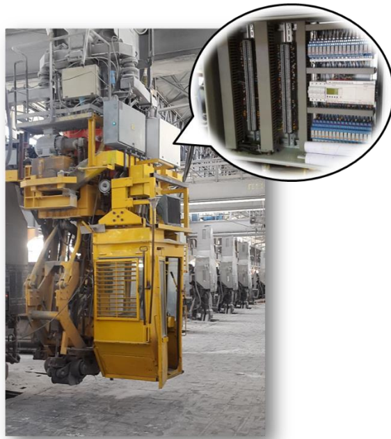
Εικόνα 38. Ερμάριο στην γερανογέφυρα
