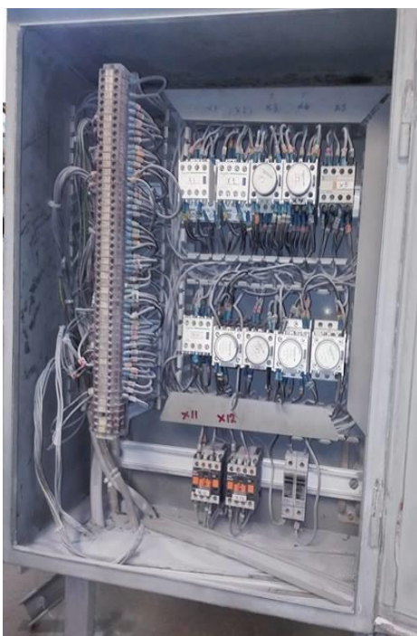
Εικόνα 32. Ερμαρίου με κλασικό αυτοματισμό
