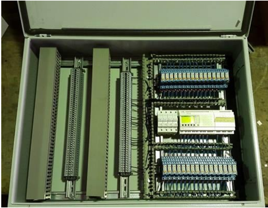
Εικόνα 34. Ερμαρίου με P.L.C
