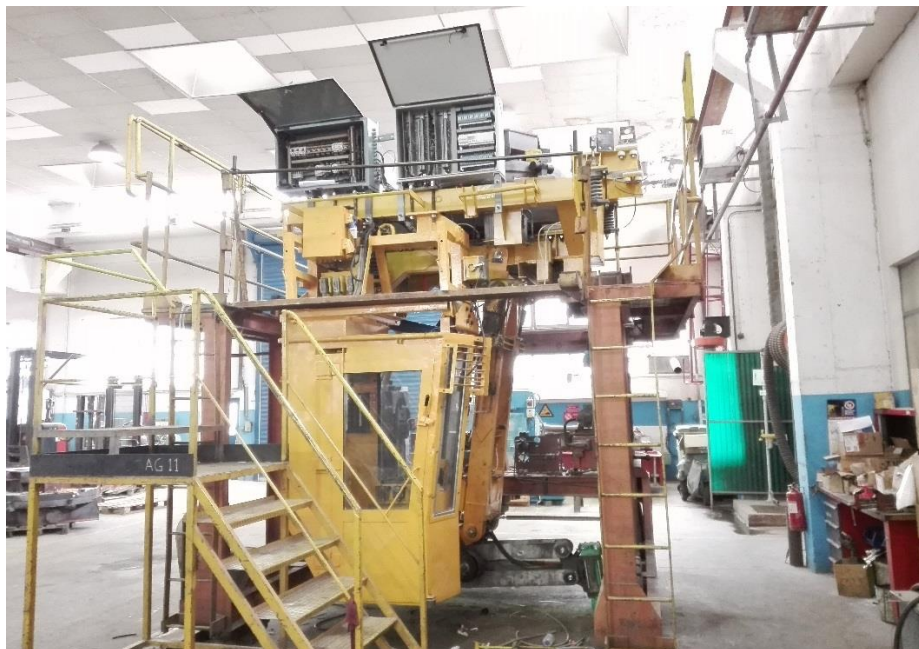
Εικόνα 37. Τοποθέτηση ερμαρίου στην καμπίνα
