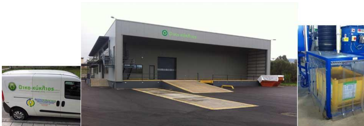
Εικόνα 5.4.1 : Εγκαταστάσεις της εταιρίας
