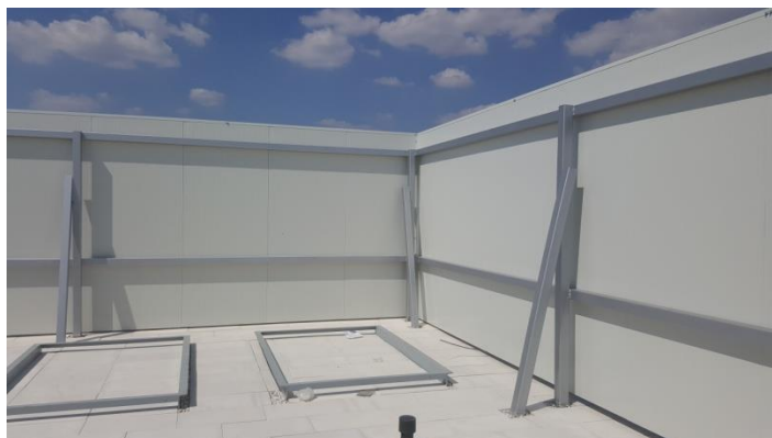
Εικόνα 32: Φωτογραφία απεικόνισης της γωνιακής ενοποίησης των ηχοπετασμάτων πριν τις Κ.Κ.Μ.
