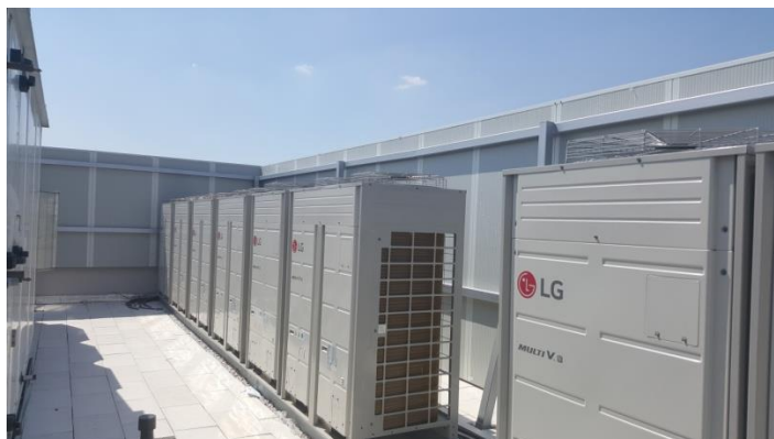
Εικόνα 33: 1η Φωτογραφία απεικόνισης της γωνιακής ενοποίησης των ηχοπετασμάτων μετά τις Κ.Κ.Μ.
