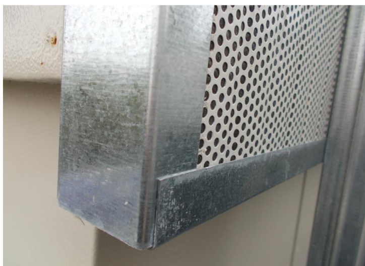
Εικόνα 14: Κάλυψη πλευρών ηχοπετάσματος με "πι".
