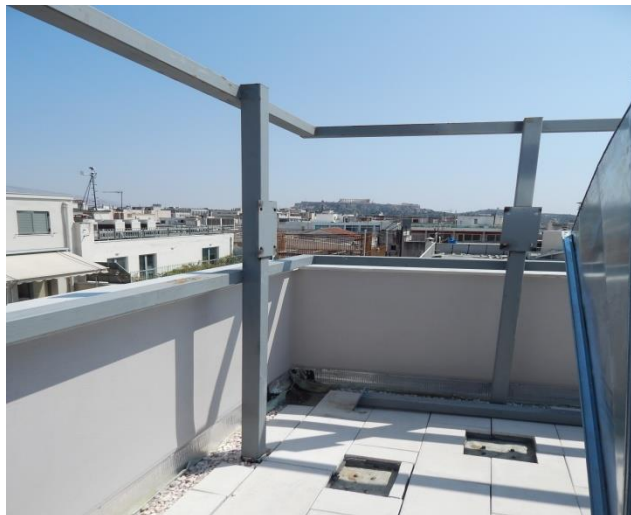
Εικόνα 27: Σημείο (γωνιά) συνένωσης των μεταλλικών ορθοστατών.
