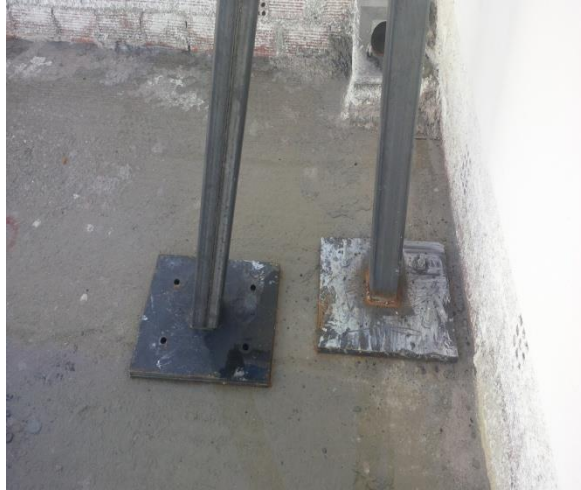
Εικόνα 21: Κάτω μέρος του προς τοποθέτηση ορθοστάτη.
