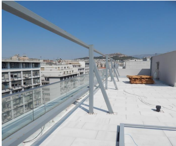
Εικόνα 26: 2η φωτογραφία μετά την τοποθέτηση των ορθοστατών κατά μήκος του δώματος.
