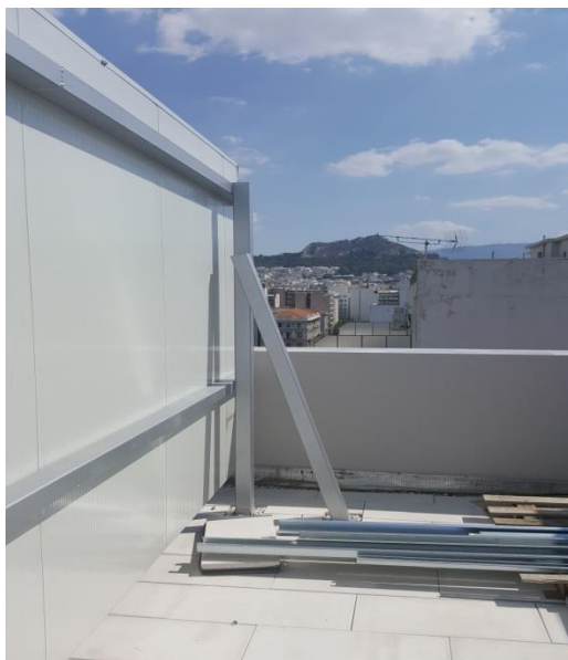
Εικόνα 31: Φωτογραφία απεικόνισης της μορφής του ενιαίου μεταλλικού σκελετού.
