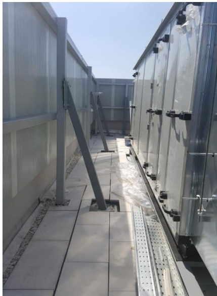
Εικόνα 34: 2η Φωτογραφία απεικόνισης της γωνιακής ενοποίησης των ηχοπετασμάτων μετά τις Κ.Κ.Μ.
