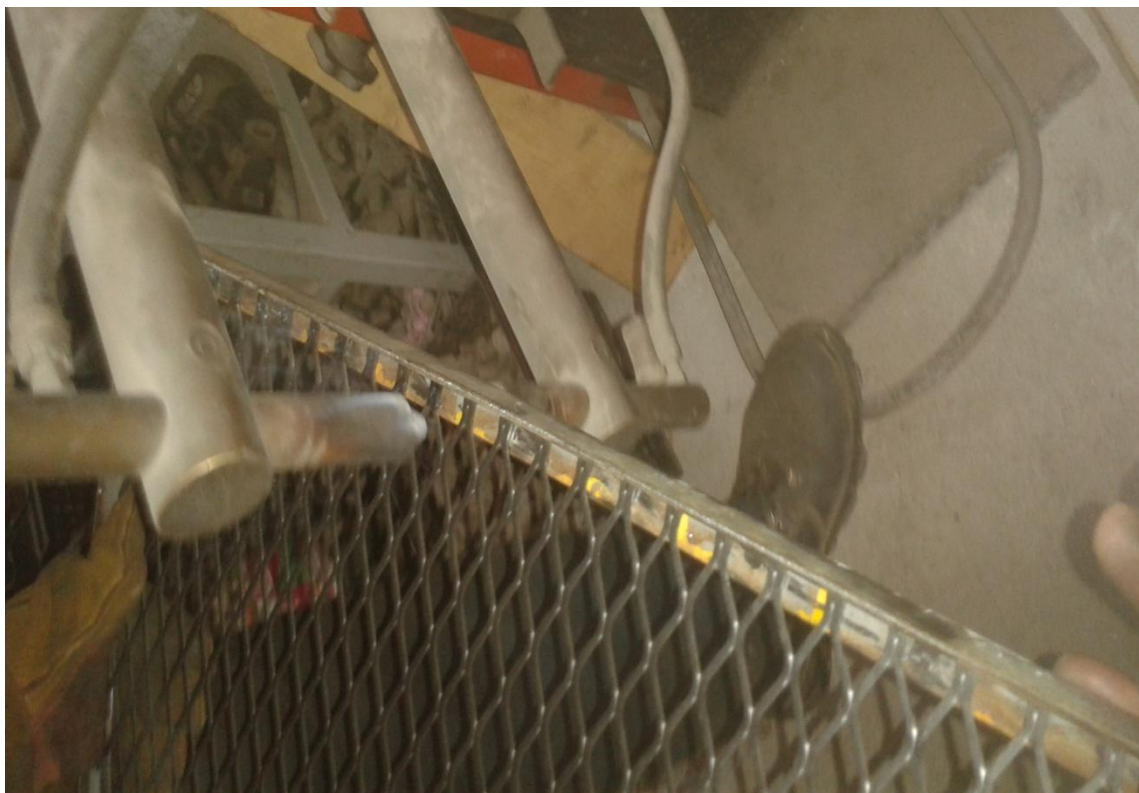
Εικόνα 5.1.1. Εργασία στην ηλεκτροπόντα
