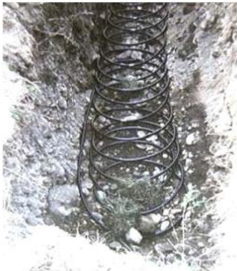
Εικόνα 6.38: Οριζόντιο κλειστό κύκλωμα σε διάταξη με σπείρες.
