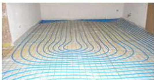
Εικόνα 6.42: Ενδοδαπέδιο κύκλωμα αγωγών
