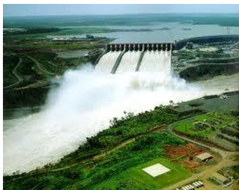
Εικόνα 6.46: Φράγμα μεγάλης κλίμακας
