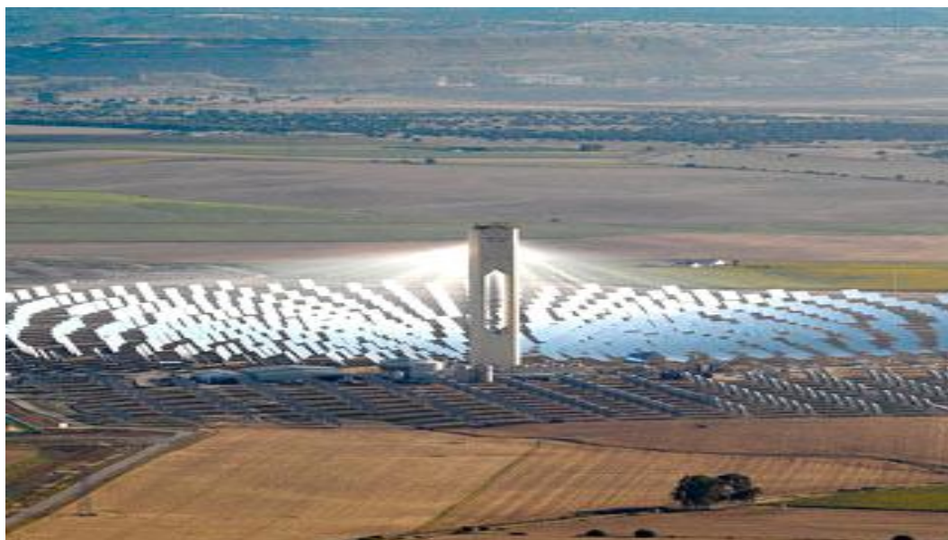
Εικόνα 6.6: Χρήση φακών κάτοπτρων για συγκέντρωση της ηλιακής ακτινοβολίας στα ηλιακά στοιχεία
