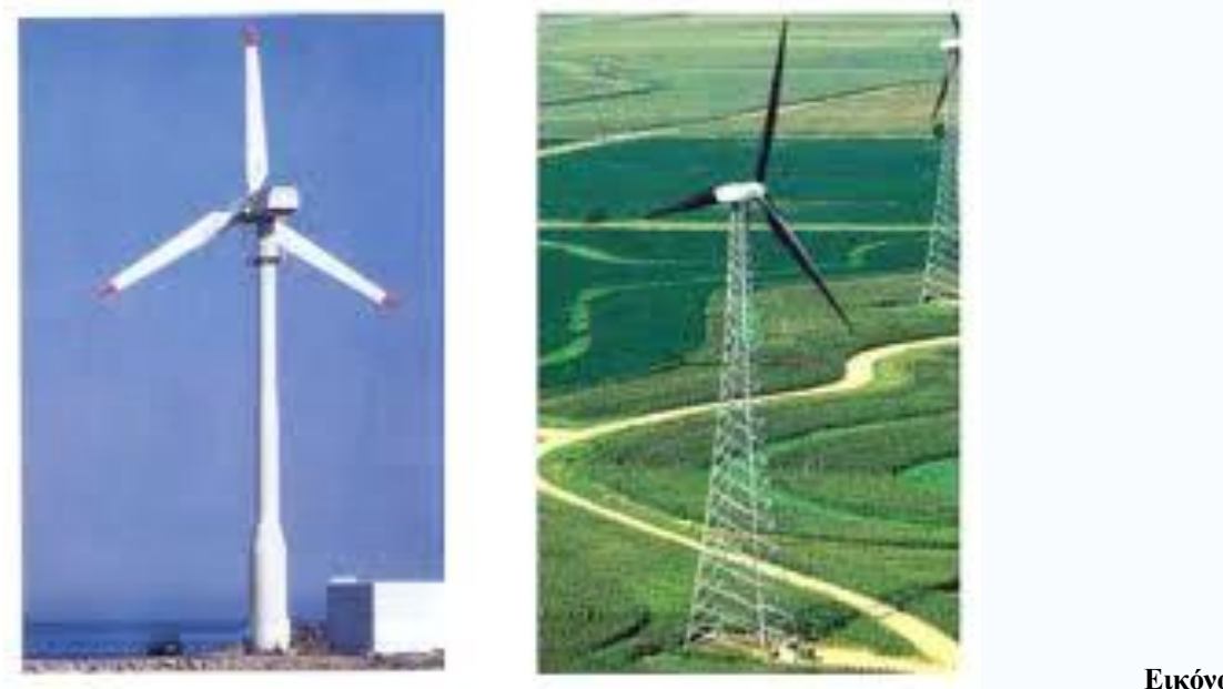
6.27: Τύποι πύργων ανεμογεννήτριας
