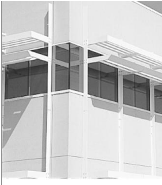
Εικόνα 4.29: Οριζόντιες εξωτερικές περσίδες, κατάλληλες για νότιο προσανατολισμό. Λειτουργούν αποδοτικά, εκτός από τις γωνίες. Διπλή σειρά περσίδων έχει χρησιμοποιηθεί.
