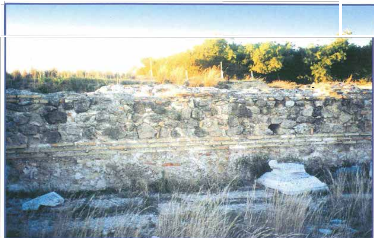
Βασιλική Αρχαίου Λεωνίδα εις αρχαίο λιμάνι Λεχαιού, μερική άποψη. Εικονίζεται τμήμα του μεσαίου και νοτίου κλίτους. (φωτ. συγγραφέα)
