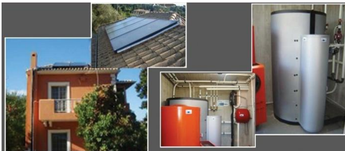
Σχήμα 4.22: Κατοικία στη Κέρκυρα [98]
