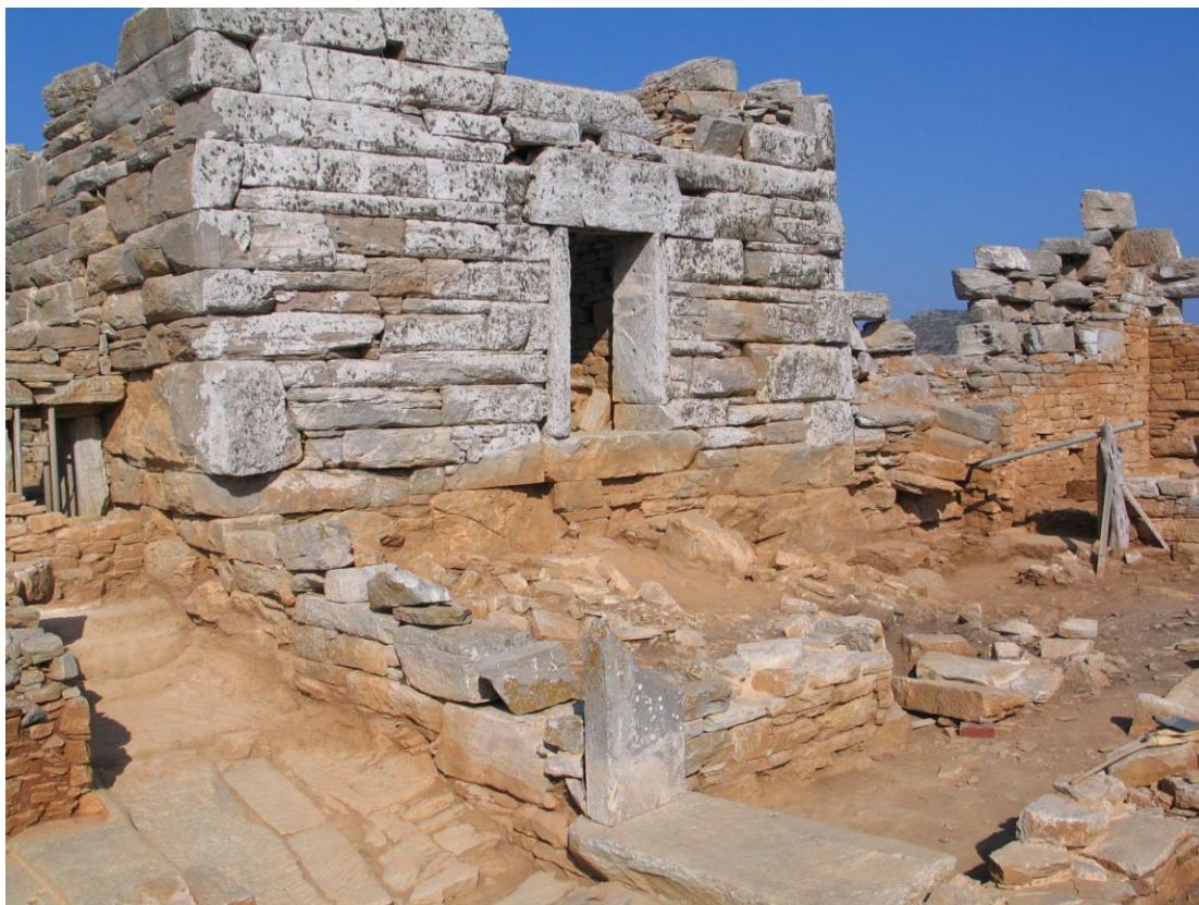
Εικόνα 18.α. Παραστάδα και κατώφλι θύρας.
