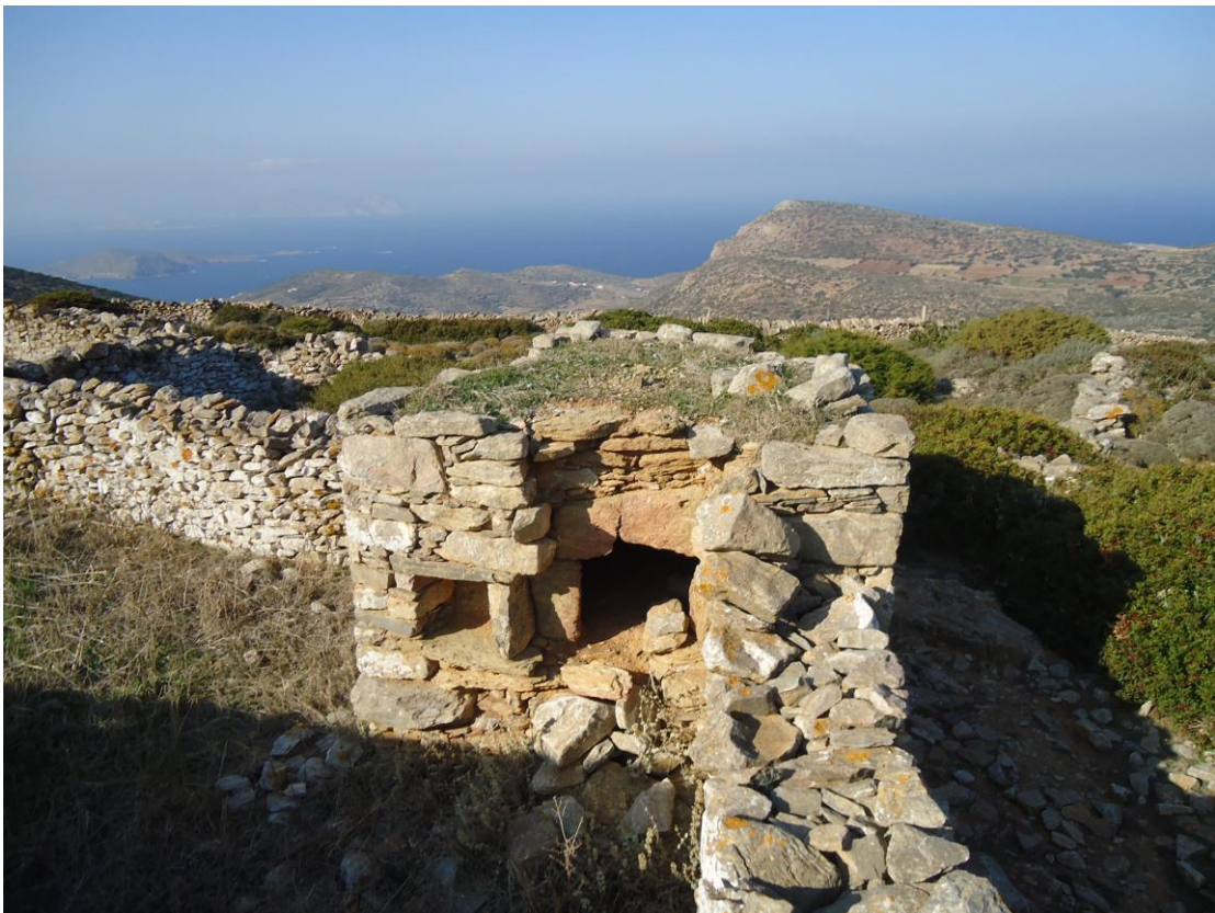
Εικόνα 40.Πρόχειρα κατασκευασμένοι τοίχοι πάνω από θεμέλια ελληνοιστικής περιόδου τοιχοδομίας.
