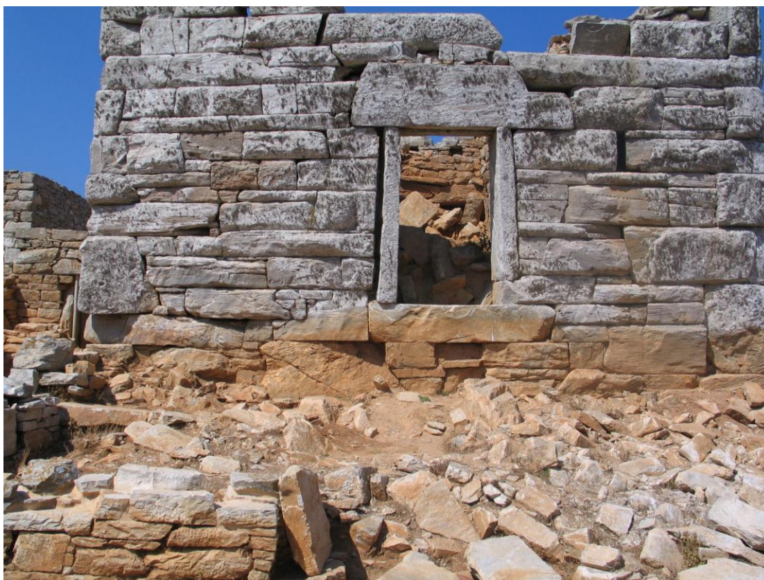
Εικόνα 14.Είσοδος στον κυρίως Πύργο. Θύρα πλάτους 1,25μ και ύψους 2,20μ.
