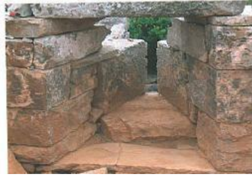
Εικόνα 15. Διαμπερές άνοιγμα τριγωνικής διατομής. (πολεμίστρα)
