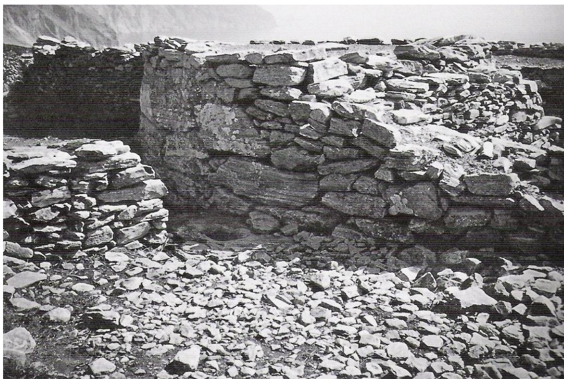
Εικόνα 55.Θεμέλια Πύργου στην δυτική πλευρά.
