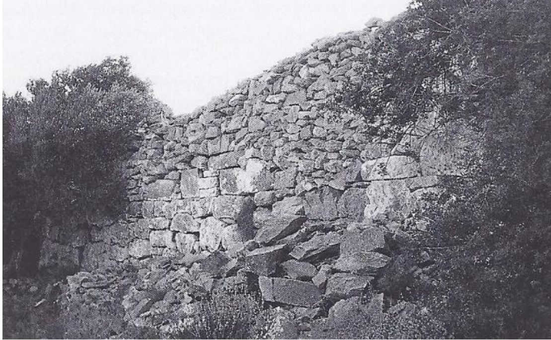
Εικόνα 27. Κυφωτή τοιχοδομία.
