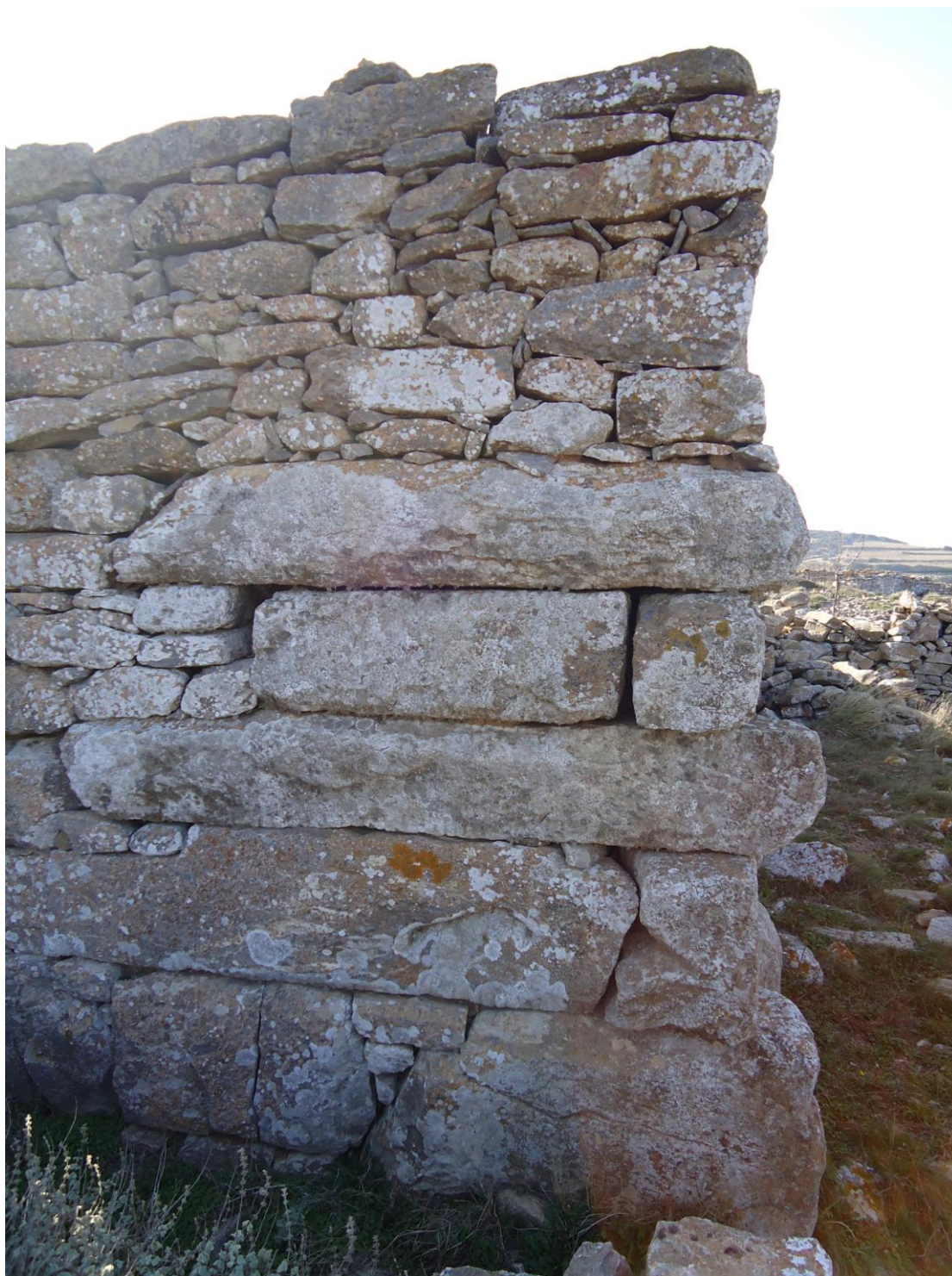
Εικόνα 35.Λεπτομέρεια ψευδοϊσοδόμης τοιχοποιίας.
