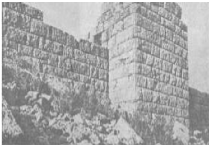
Εικόνα 61. Ισόδομο τραπεζιόσχημα με βελονιές (Wrede).
