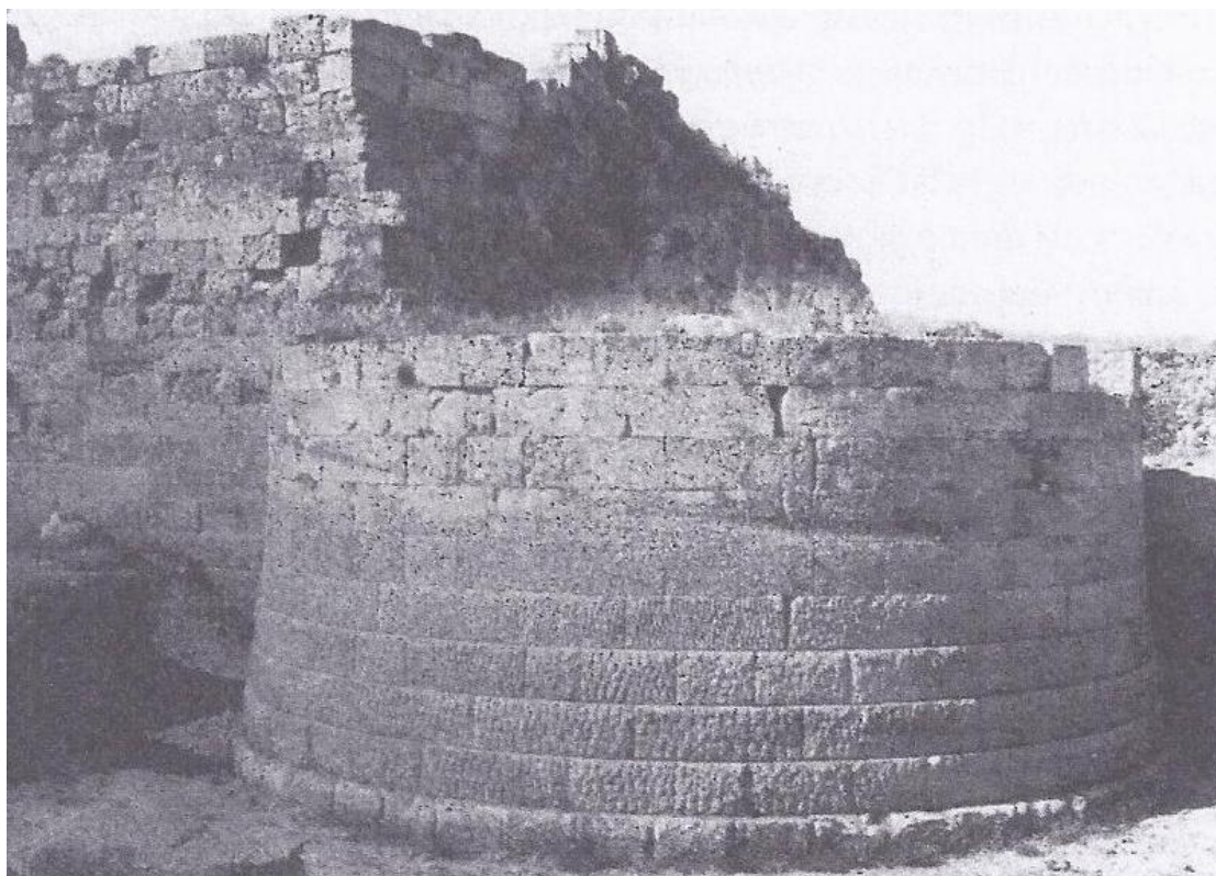
Εικόνα 64.Οχυρωματικό τείχος ,νότιος γωνιακός πύργος με διακόσμηση από χτυπήματα βελονιού (450 π.Χ.)(Πηγή βιβλίο Wolfgang Müller- Wiener Η ΑΡΧΙΤΕΚΤΟΝΙΚΗ ΣΤΗΝ ΑΡΧΑΙΑ ΕΛΛΑΔΑ )
