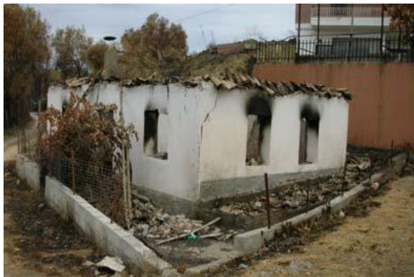
Εικόνα 52 Κτίριο από ωμοπλινθοδομή
