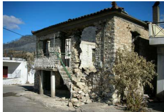
Εικόνα 51 Διώροφο κτίριο από λιθοδομή
