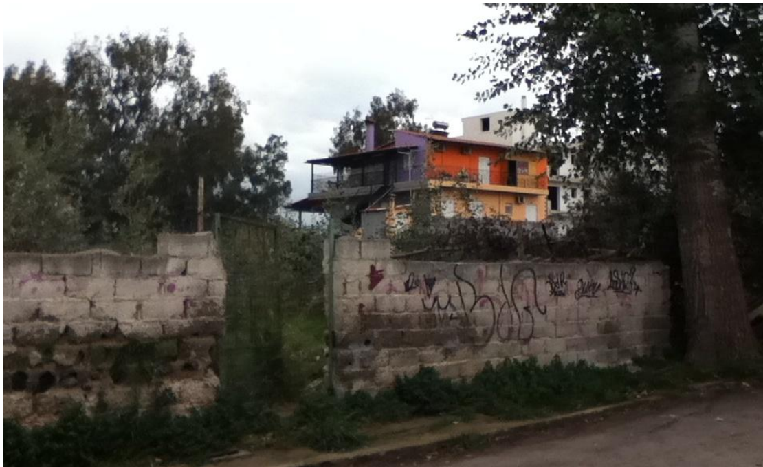
Εικόνα 25 Τσιμεντόπλινθοι βαρέως τύπου βρίσκουν εφαρμογή σε δευτερεύουσες κατασκευές.
