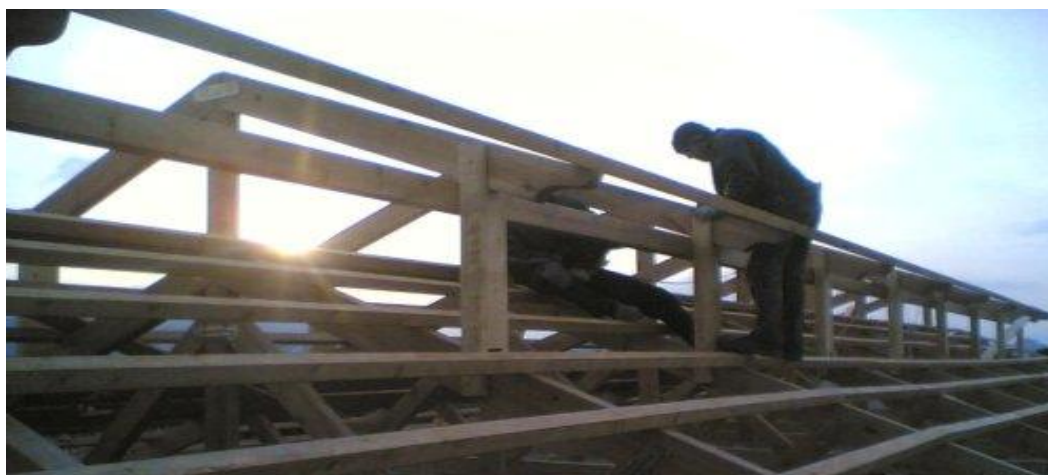
Εικόνα 37 Σκελετός ξύλινης στέγης
