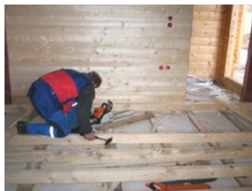
Εικόνα 31 Προετοιμασία τοποθέτησης πατωμάτος
