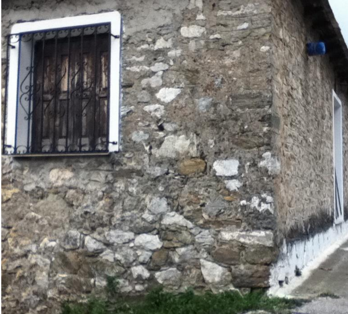
Εικόνα 14 Παραδοσιακή κατοικία στις Μηλιές Πηλίου. Η εξωτερική τοιχοποιία ανήκει στη κατηγορία της λιθοδομής
