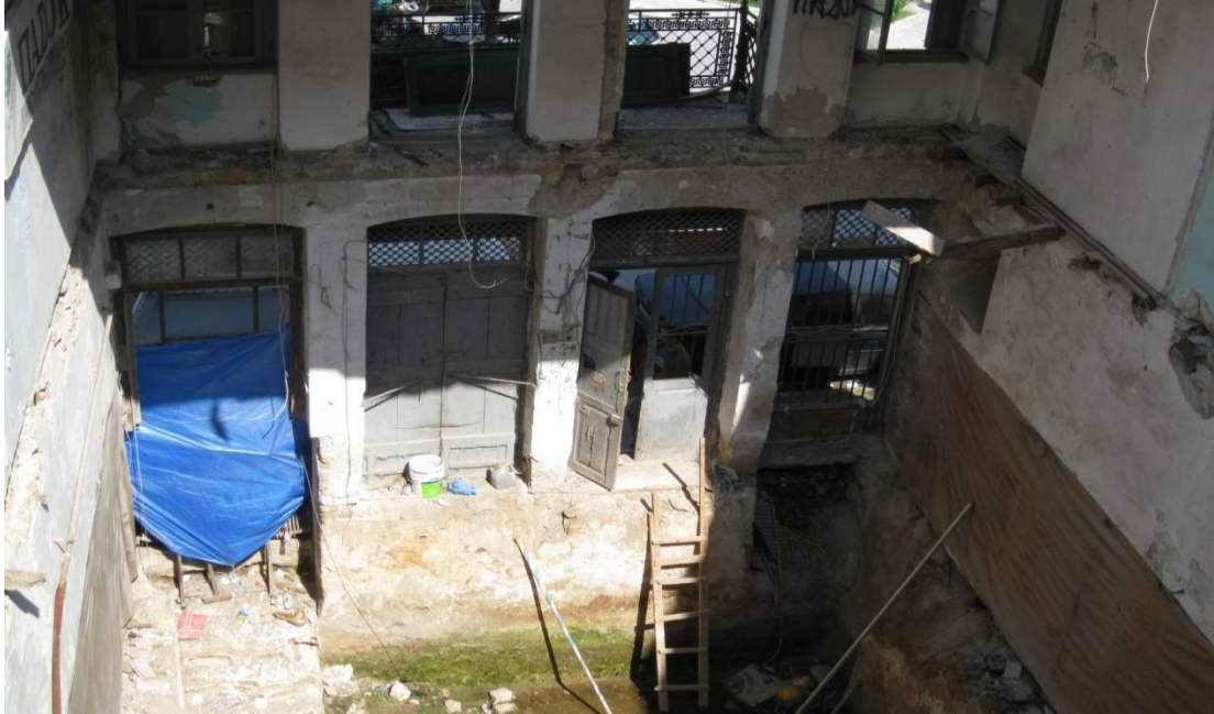
Εικόνα 11 Διατηρητέο Κτίριο στο Γύθειο. Στο εσωτερικό του κτιρίου δεν διασώζονται τα πατώματα, τα οποία κυρίως λόγω παλαιότητας έχουν καταστραφεί.
