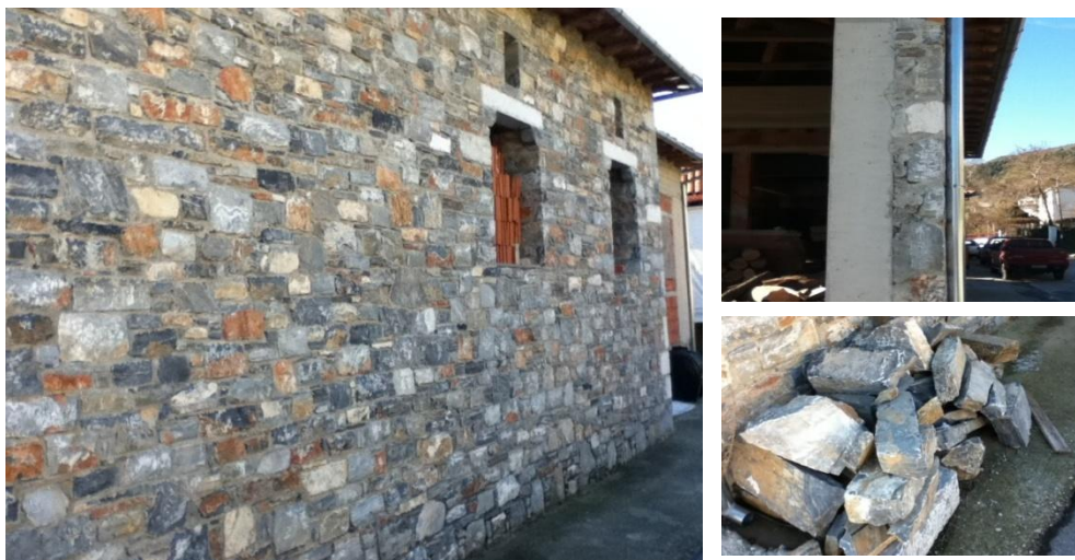
Εικόνα 15 Σύγχρονη κατοικία με εξωτερική επένδυση με λαξευμένη πέτρα.
