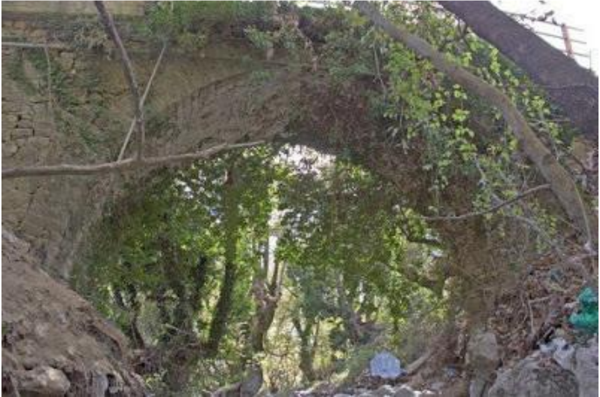
Εικόνα 31 Γεφύρι στο Κορφίτο.
