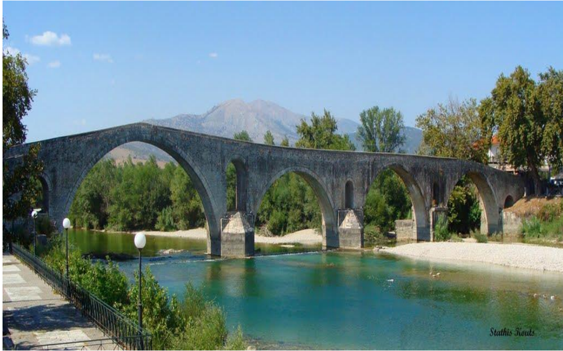
Εικόνα 20 Το γεφύρι της Άρτας (πηγή: static.panoramio.com)
