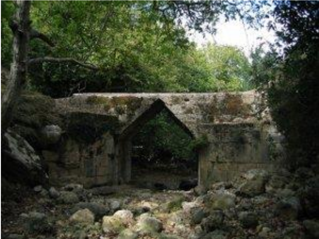
Εικόνα 17 Η γέφυρα της Ελεύθερνας στο Ρέθυμνο της Κρήτης, που χρονολογείται από τον 4ο αιώνα π.Χ. κτισμένη με το εκφορικό σύστημα
