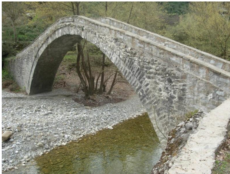
Εικόνα 30 Γεφύρι του Μεσόπυργου
