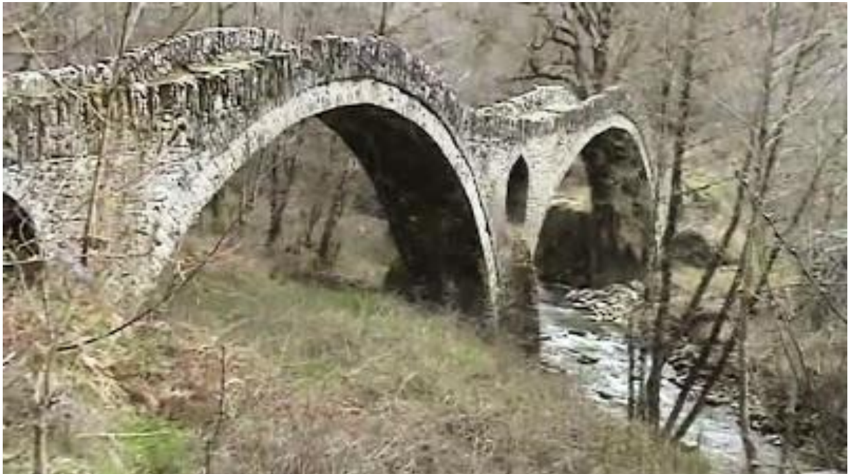
Εικόνα 9 Το Φραγκαδιώτικο, ή γεφύρι του Πιτσώνη
