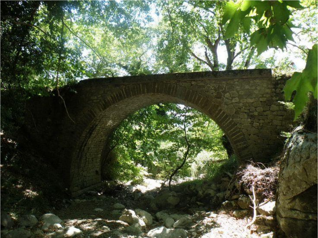
Εικόνα 39 Γεφύρι στο Ρέμα του Τσαγκαράκη.
