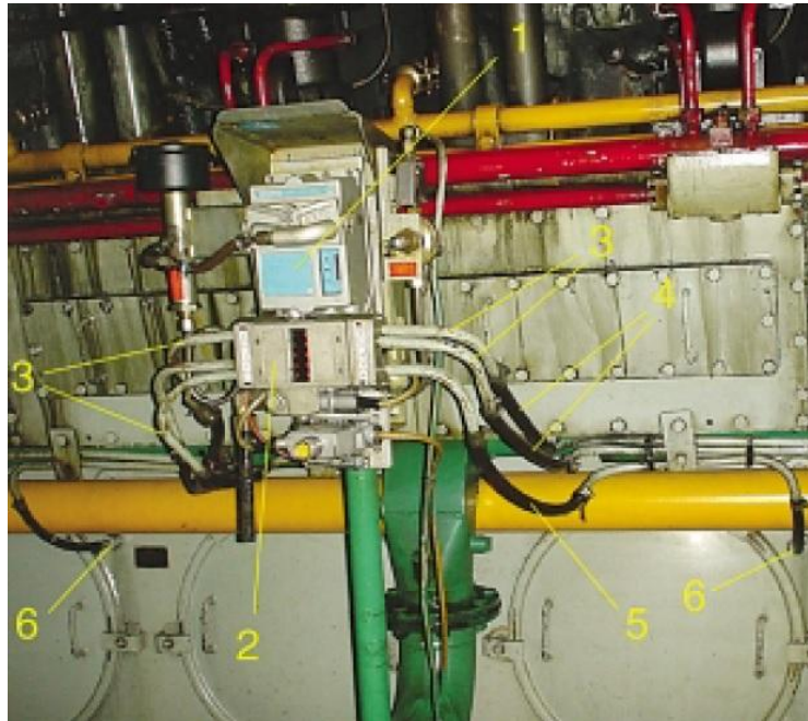
Εικόνα 3.10: Λανθασμένη εγκατάσταση συστήματος VISATRON VN215 με ξεχωριστές σωλίνες αναρρόφησης συνδεδεμένες σε κάθε διαμέρισμα στροφαλοθαλάμου [7].
