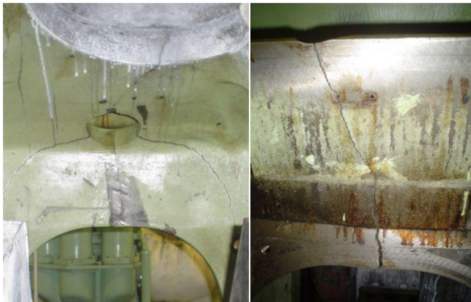
Εικόνα 2.8: Εμφανή εσωτερικά cracks στο κορμός (block), κύριας μηχανής πλοίου, τύπου Sulzer ZA40 [23].
