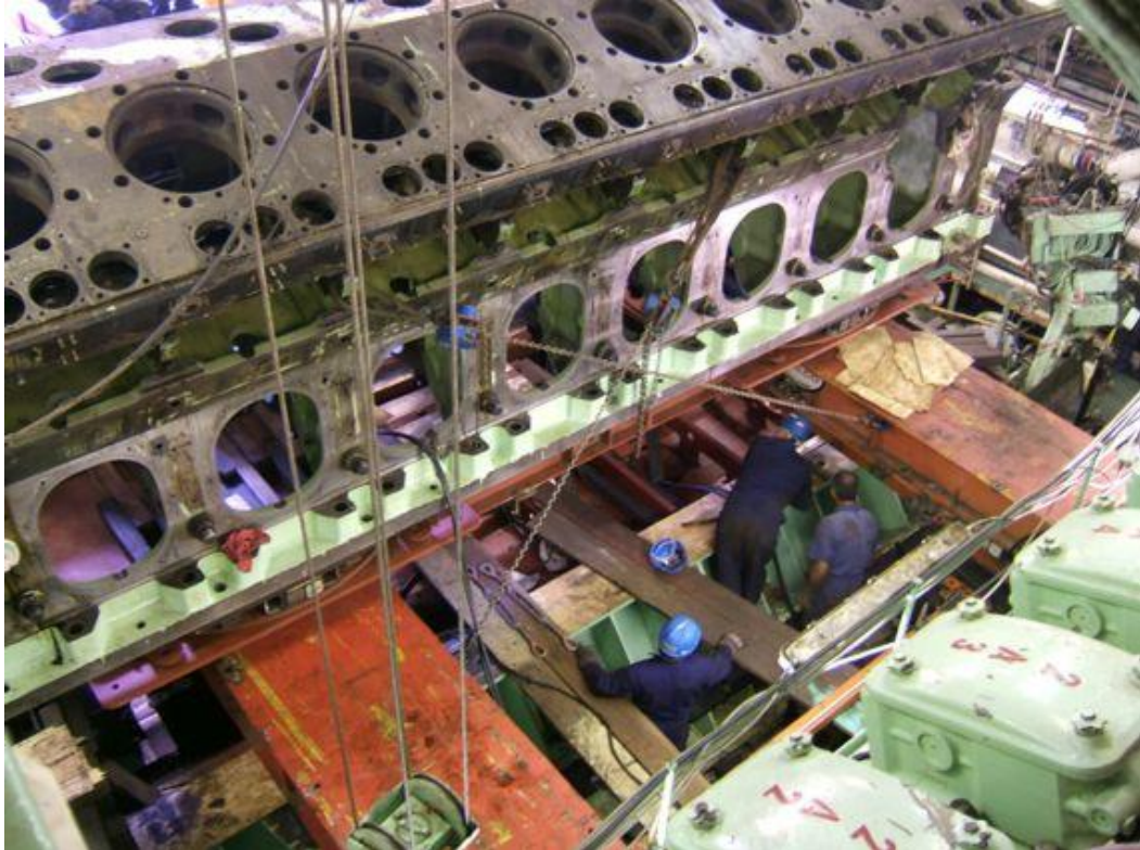
Εικόνα 2.5: Καταστροφικά αποτελέσματα έκρηξης νέφους ελαίου (αντικατάσταση μηχανής) στο στροφαλοθάλαμο, κύριας μηχανής πλοίου, τύπου Sulzer ZA40 [23].
