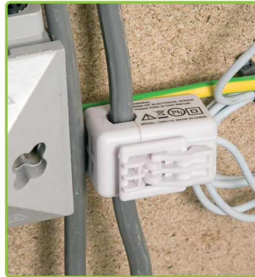
Σχήμα 6.4.4.1 Τοποθέτηση αισθητήρα
