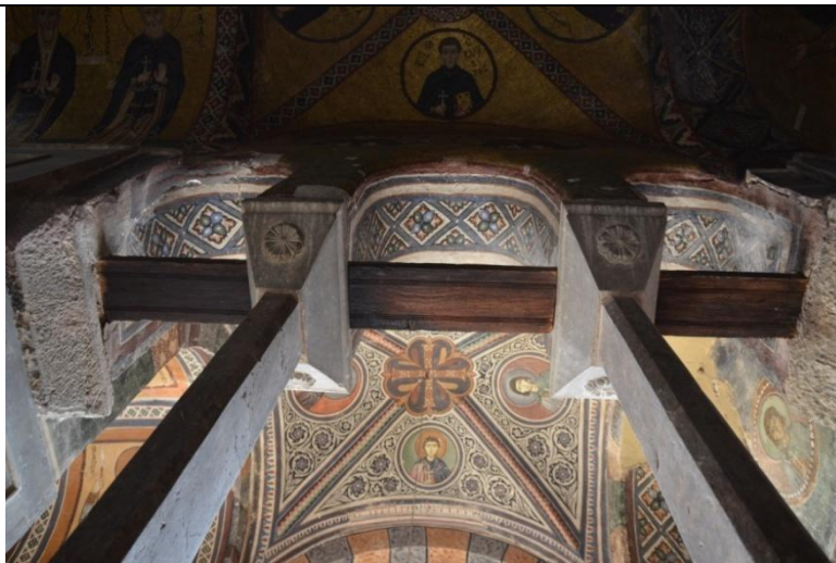
Φωτ. 3_Εσωτερική ενίσχυση_πηγή: προσωπικό αρχείο
