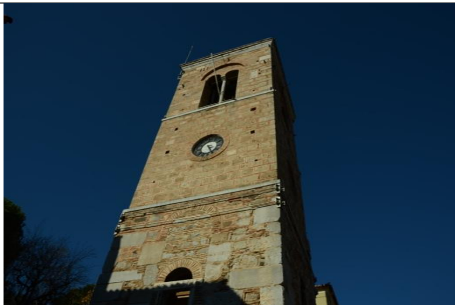
Φωτ. 1_Εξωτερική περίδεση καμπαναριού_πηγή: προσωπικό αρχείο
