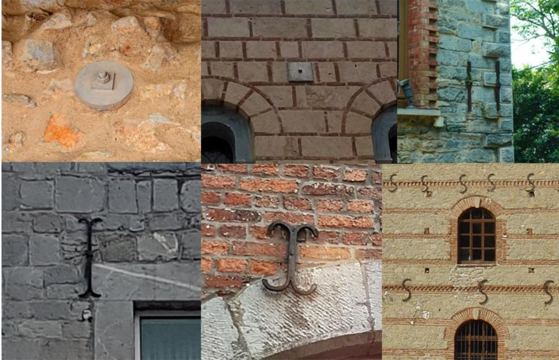
Εικόνα 6_Είδη αγκυρώσεων ράβδων ελκυστηρών: (α) πλάκα αγκύρωσης στρογγυλή διατομής, (β) πλάκα αγκύρωσης τετράγωνης διατομής, (γ) πύργος αγκύρωσης / «μπαστούνι» - (ε) κλειδιά αγκύρωσης σχήματος «I», (στ) κλειδιά αγκύρωσης σχήματος «S». πηγή: προσωπικό αρχείο, ίδια επεξεργασία.
