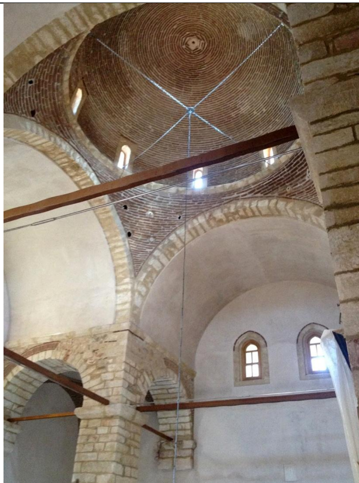
Φωτ. 9_Ενίσχυση εσωτερικού
