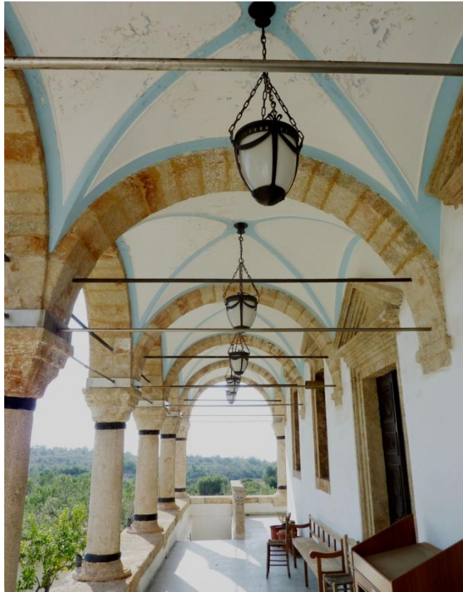
Εικόνα 1_Ενίσχυση θολοδομίας Ιερού Ναού Παναγίας ρτιδιώτισσας (Κύθηρα)_πηγή: φωτ. Αρχείο Χ. Γιαρλέλ
