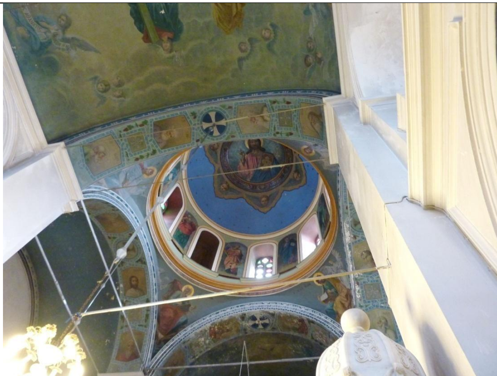
Φωτ. 7_Ενίσχυση εσωτερικού_πηγή: φωτ. αρχείο Χ. Γιαρλέλη
