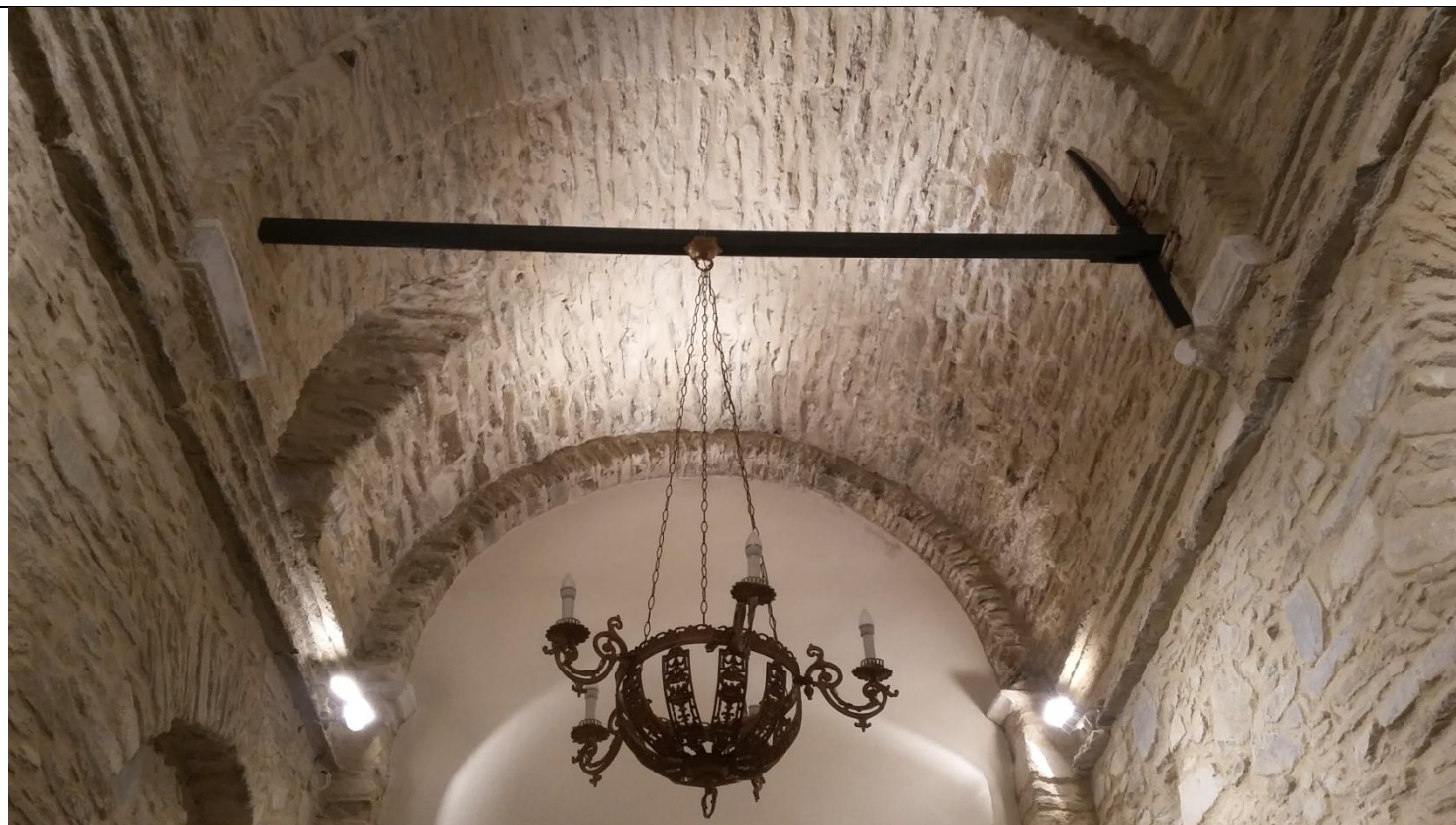
Φωτ. 19_Ενίσχυση αψίδας_πηγή: προσωπικό αρχείο
