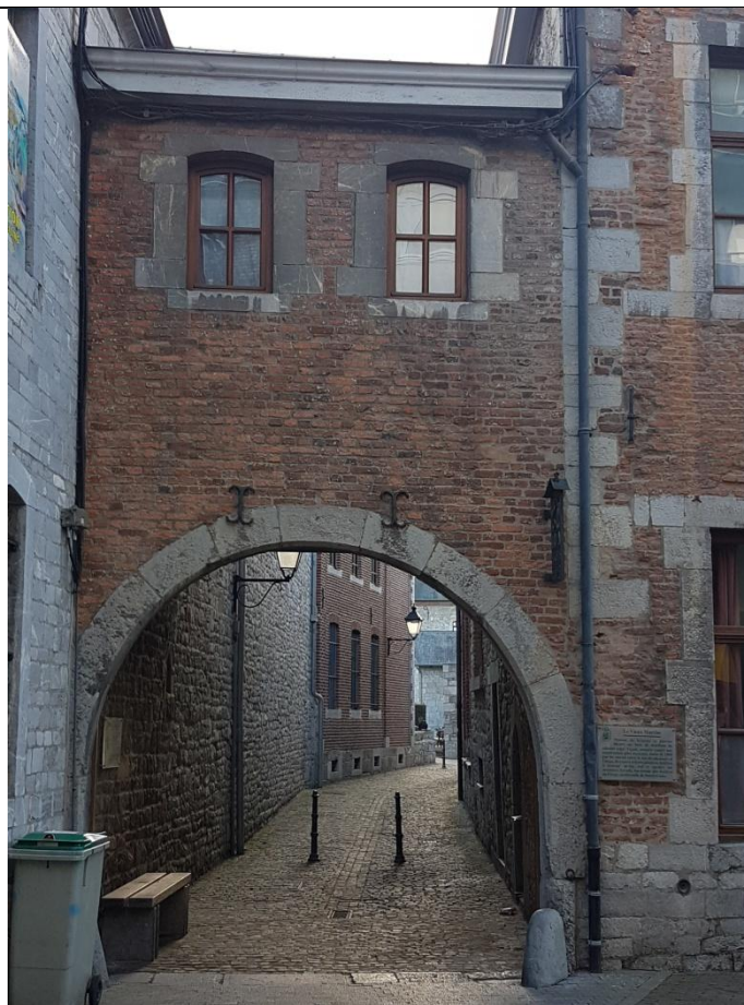
Φωτ. 15_Ενίσχυση αψίδας_πηγή: προσωπικό αρχείο
