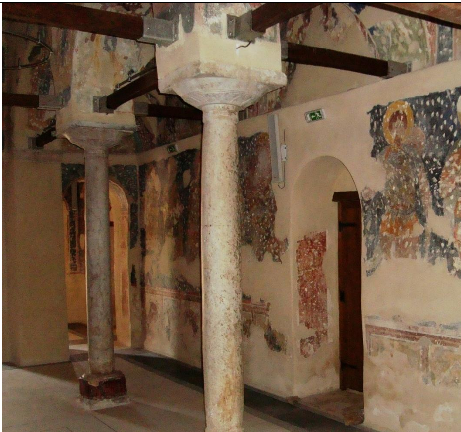
Φωτ. 18_Ενίσχυση τόξων
