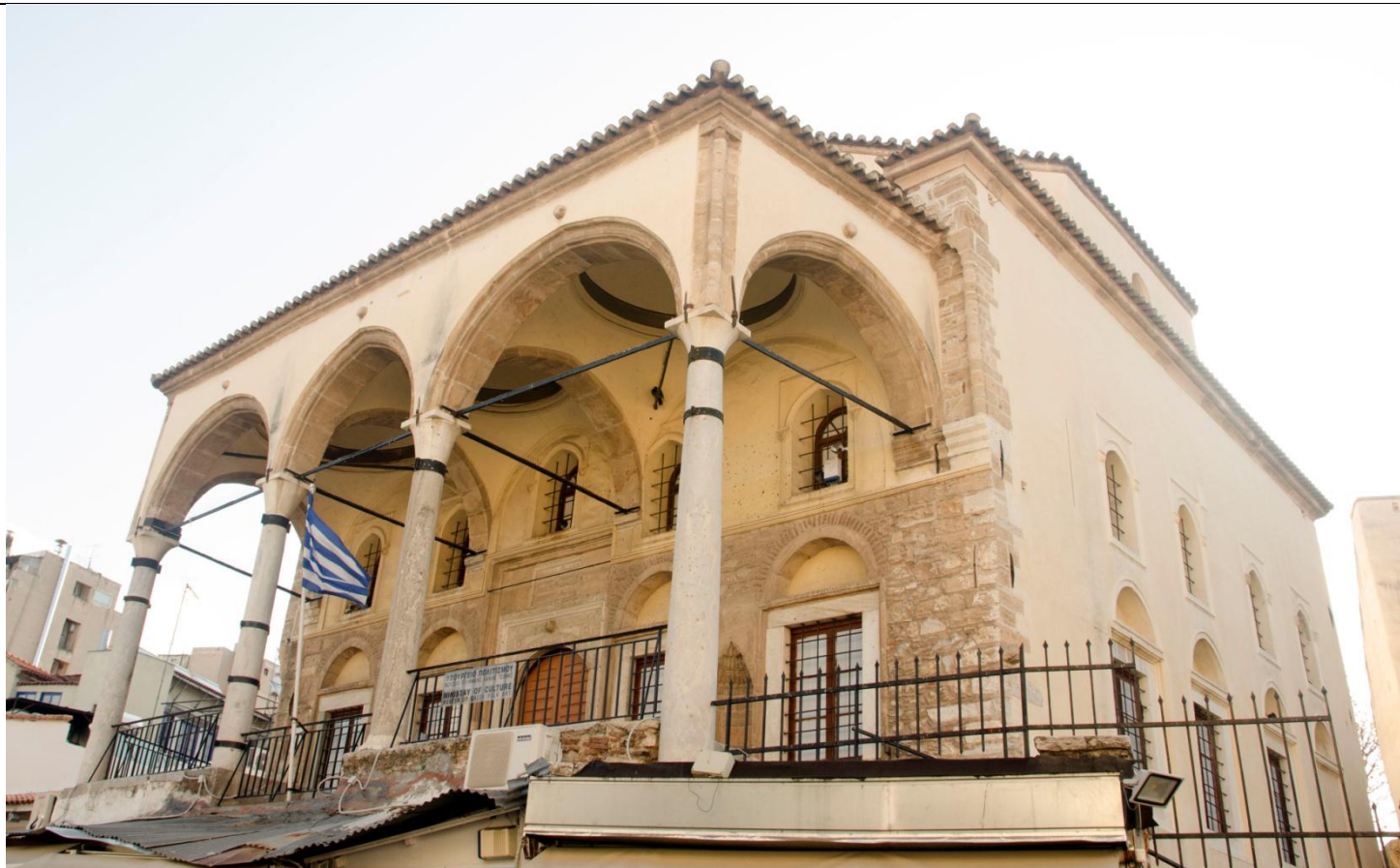
Φωτ. 23_Σύστημα ενίσχυσης_πηγή: προσωπικό αρχείο
