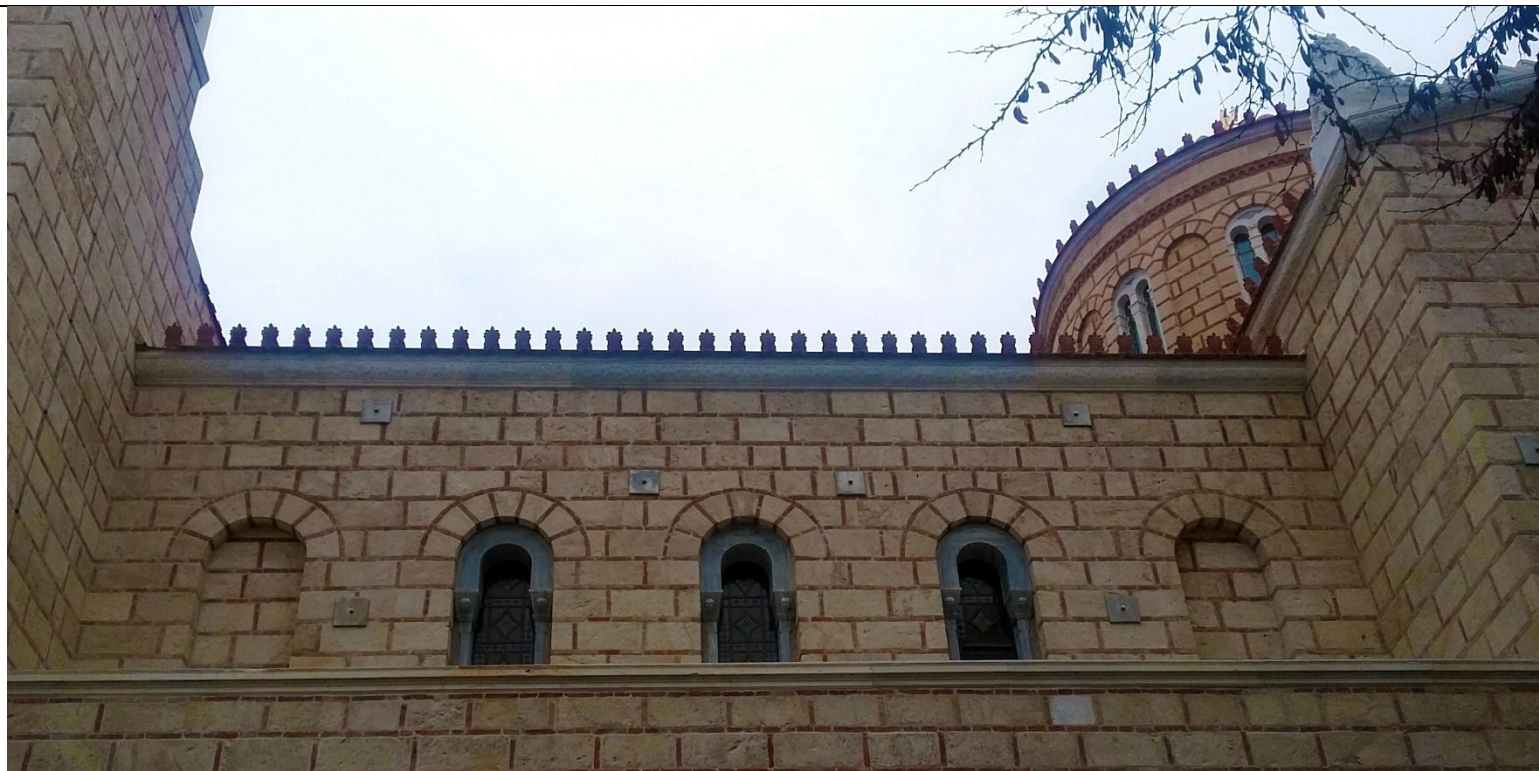
Φωτ. 10_Πλάκες αγκύρωσης ελκυστήρων_πηγή: προσωπικό αρχείο
