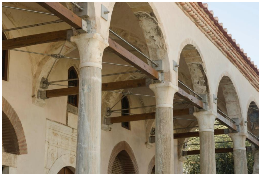
Φωτ. 21_Σύστημα ενίσχυσης_πηγή: προσωπικό αρχείο
